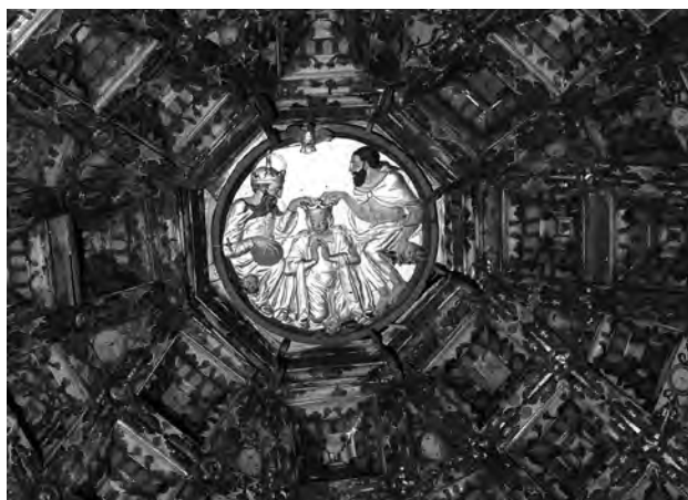
Detalle de la techumbre de la antigua capilla de Montserrat (1540), convento franciscano de la Inmaculada Concepción [TRCP]
