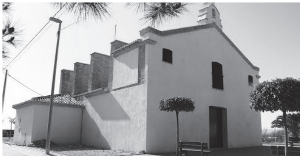
Ermita de Los Ríos en Lobosillo. Fotografía del autor.
