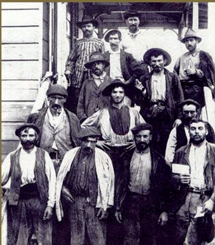
Trabajadores españoles en el Canal de Panamá
