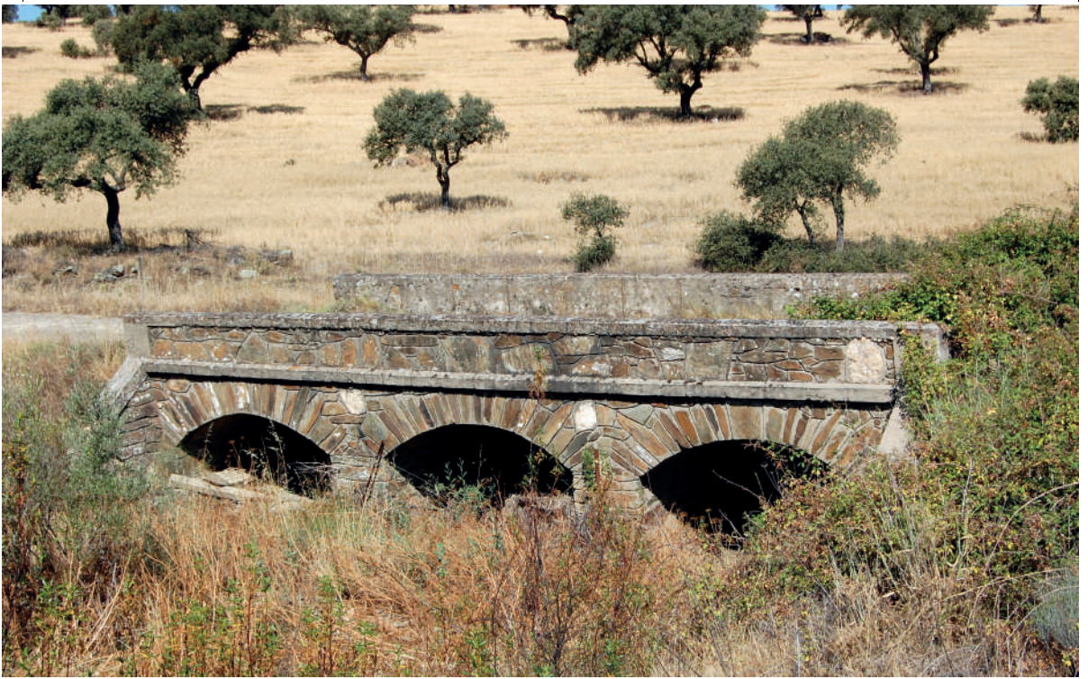
Puente en dehesa de Mirabel (Cáceres).
