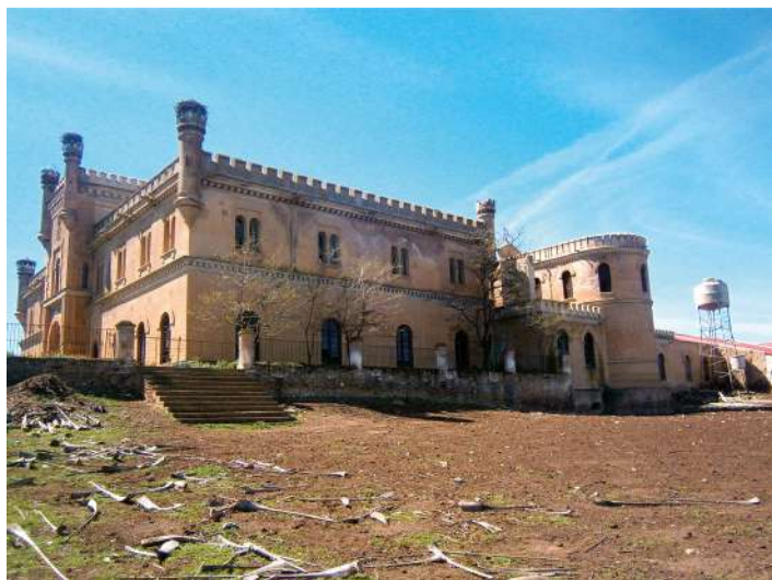
Fachada oriental de Las Poyatas
