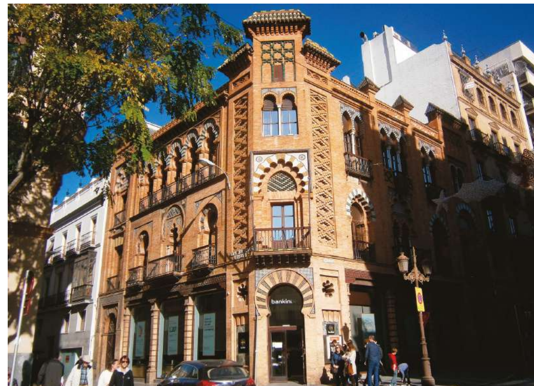
Edificio para Manuel Nogueira, esquina a la plaza de la Campana, Sevilla
