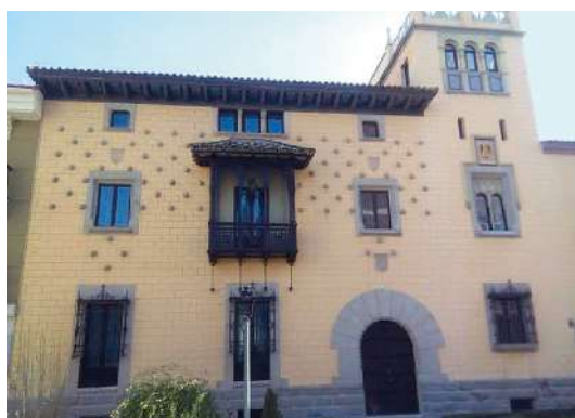
Casa de los Bolos, Villanueva de la Serena
