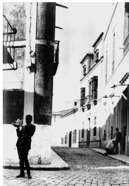
Vista de la calle Gobernador. A la derecha en primer término, el casino y a continuación, la casa
