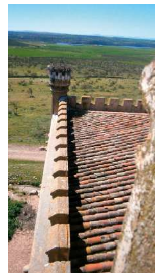
Vista de la cubierta del cortijo desde la terraza del torreón central
