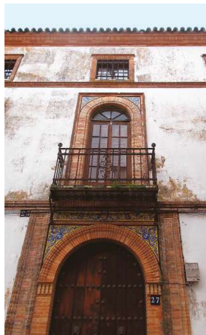
Detalle de los tres niveles de la fachada
