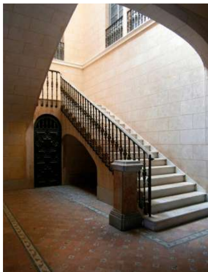
Escalera interior del cortijo
