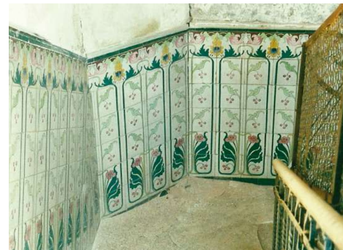
Detalle de la escalera con su azulejería original de inspiración Decó
