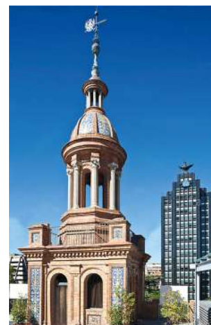
Remate final de la fachada vista desde la terraza
