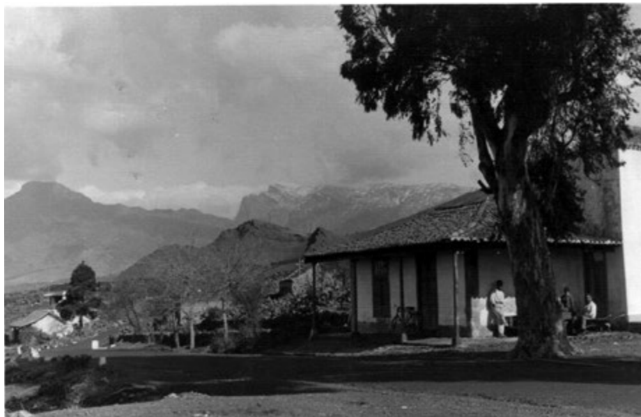
Casas junto al antiguo camino real. Las Manchas. El Paso. CDMVH
