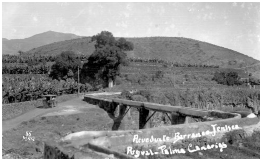
Acueducto. Barranco de Tenisca. Argual. Foto MRQ
