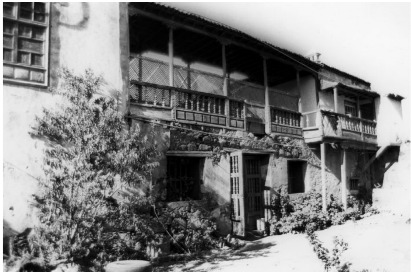
Casa Massieu Vandale antes de la restauración. Galería trasera, balcón y letrinas (desaparecidos). Llano de Argual. Foto JLV
