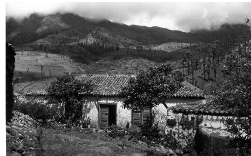
Casa terrera, con cocina anexa y horno. El Paso. CDMVH
