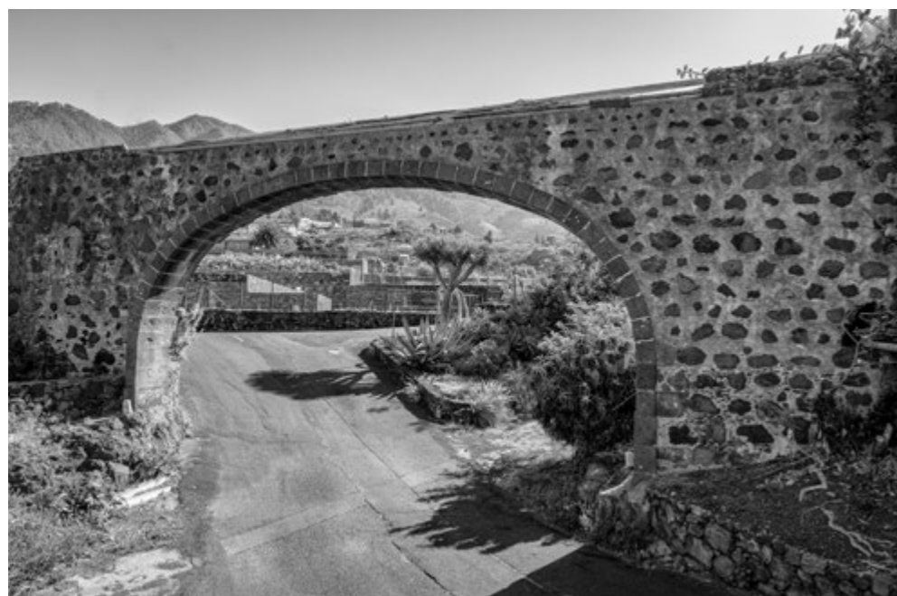
Acueducto construido en 1874 sobre el barranco de Tenisca, al pie de la cuesta de Hermosilla. AHMLA
