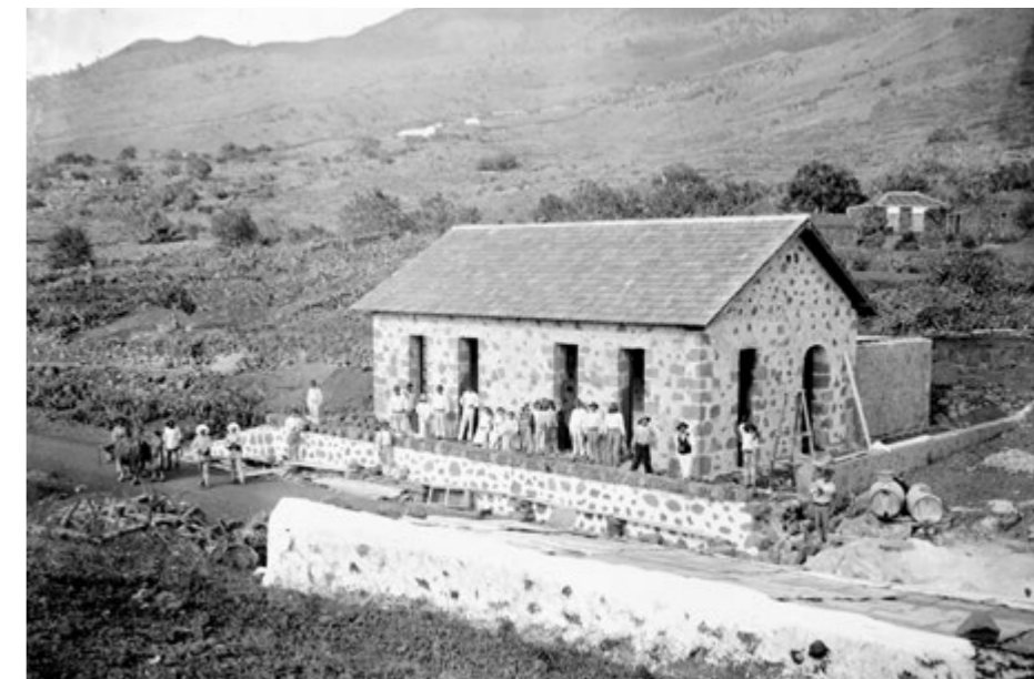
Casa de camineros en construcción. Las Manchas, 1905. Foto MBR. AGP
