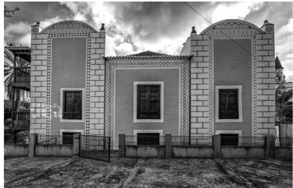
Fachada trasera de la iglesia de Bonanza. Decoración de esgrafiados antes de la restauración. LAULL
