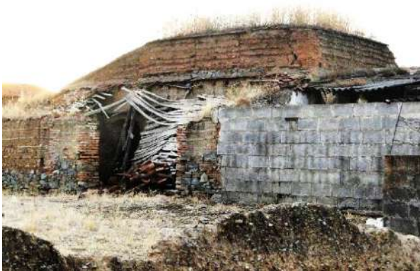
Fig. 12: Antiguo horno de tejas y ladrillos de los hermanos Lorenzana, en la calle Fernando Poo.
