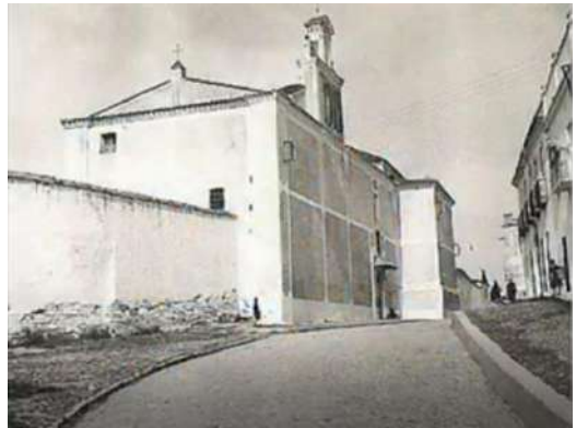
Fig. 45: Antigua fachada de la iglesia del Carmen, años 70.
