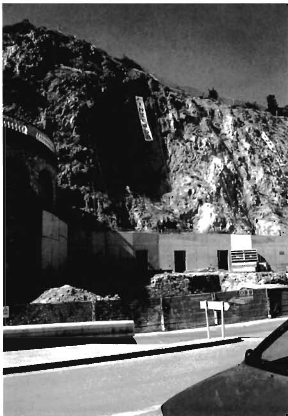
Fig. 17. Proyecto de adecuación de los refugios de la guerra civil de la calle Gisbert, en fase de ejecución.
