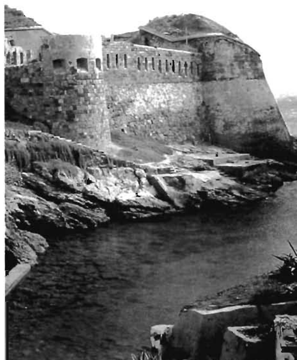
Fig. 15. Vista general de la Bateria de Santa Ana.
