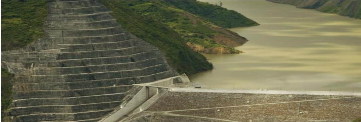
Ilustración 6. Embalse de la Central Hidroeléctrica Mazar HIDROPAUTE CELEC_EP
