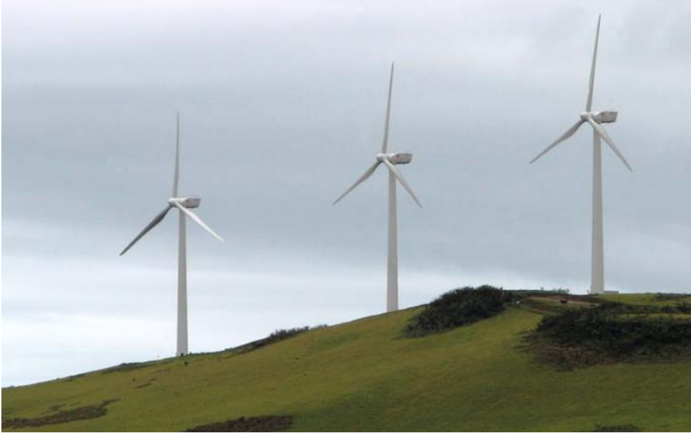
Ilustración 33. Vista frontal del parque eólico San Cristóbal (Rosero y Chiliqinga, 2011)
