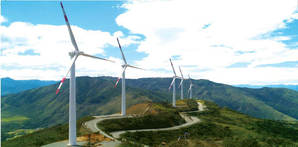
Ilustración 23. Parque eólico onshore (Villonaco, Ecuador)
