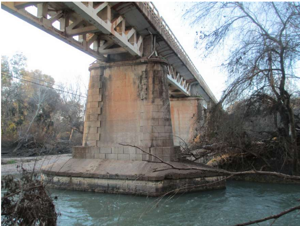
Fotografía M.Roll. Pilares del puente del Guadalquivir construidos sobre los cimientos antiguos.
