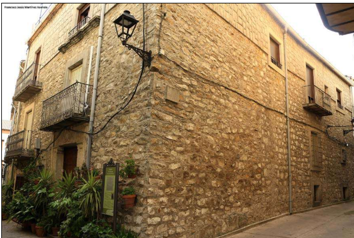
Antigua ermita de la Concepción construida en 1712
