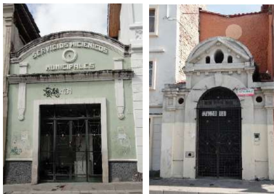
Fotos 132,133: Baterías de servicios higiénicos públicos, 2018. Fuente: autores
