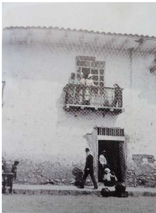
Foto 30: Arquitectura civil de Cuenca, CA 1930, autor anónimo Fuente: www.fotografianacional.com.ec
