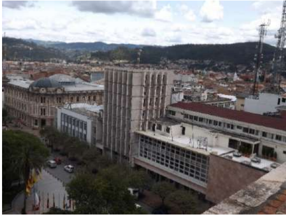
Foto 141: Edificio municipal, 2018. Fuente: Autores
