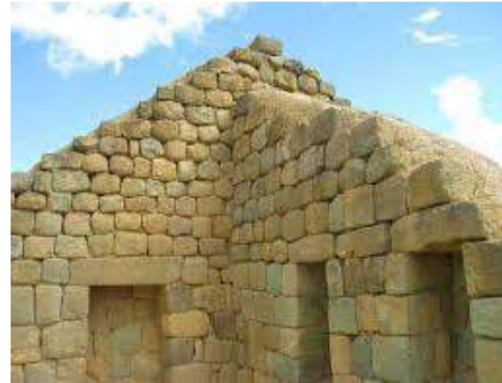
Foto 19: Ingapirca, muro con hornacinas, 2018 Fuente: Autores
