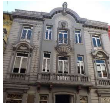
Fotos 117, 118, 119: Construcciones del maestro Luis Lupercio en la primera etapa, 2018.
