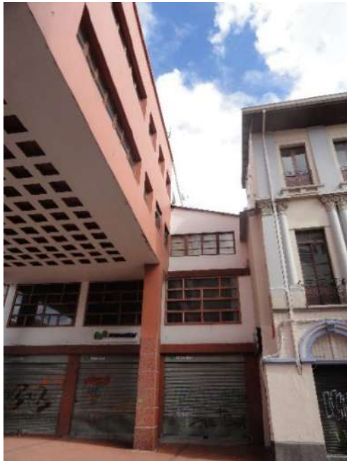
Foto: 140: Edificio de la Casa de la Cultura, 2018. Fuente: autores
