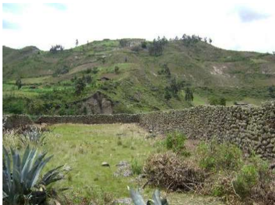
Foto 13: Muro cañari, 2018 Fuente: Autores
