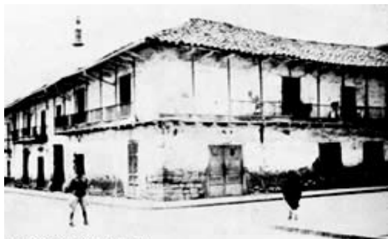
Foto 31: Casa de adobe y teja, CA 1890, autor anónimo Fuente: www.fotografianacional.com.ec
