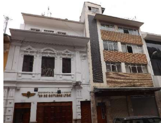
Foto 148: Edificio intervenido, 2018. Fuente: autores
