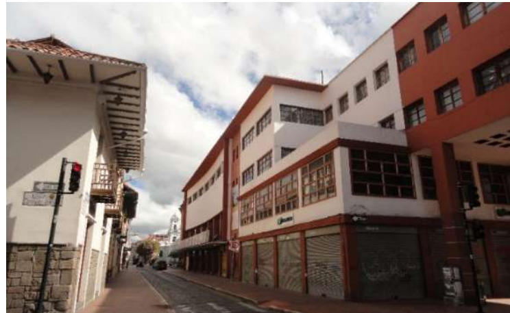
Foto: 139: edificio de la Casa de la Cultura, 2018. Fuente: autores
