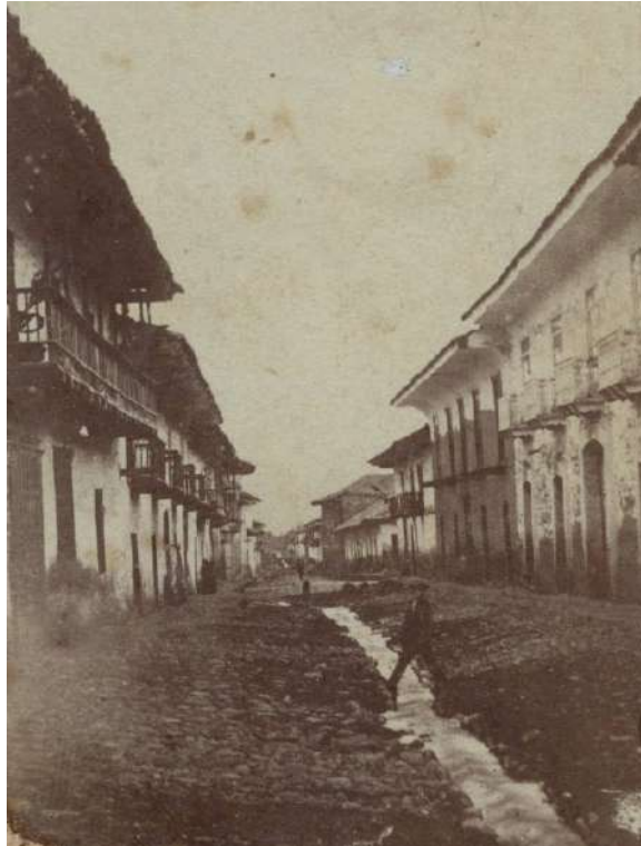
Foto 122: Calle central con acequia, CA 1930, autor Manuel Serrano.
