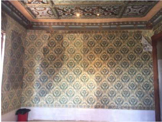
Foto 68: Cielorraso de latón, 2018. Fuente: Autores
