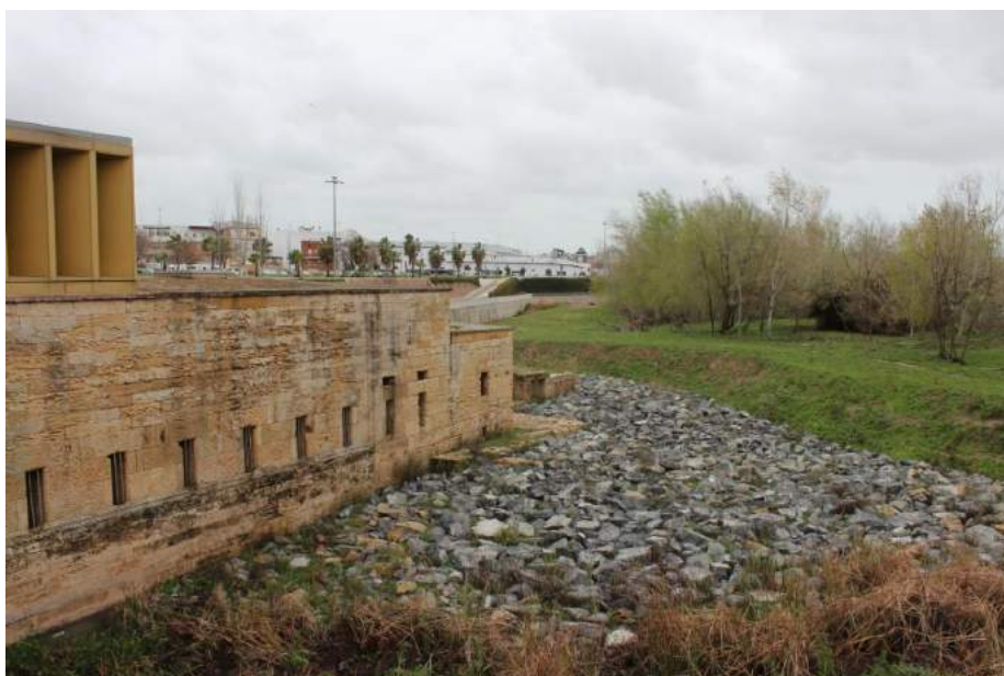
[80] Fachada meridional del Molino de Martos. A su derecha se aprecia el depósito de materiales fluviales que arrasó con el azud trazado en 1590 por Juan de Ochoa.
