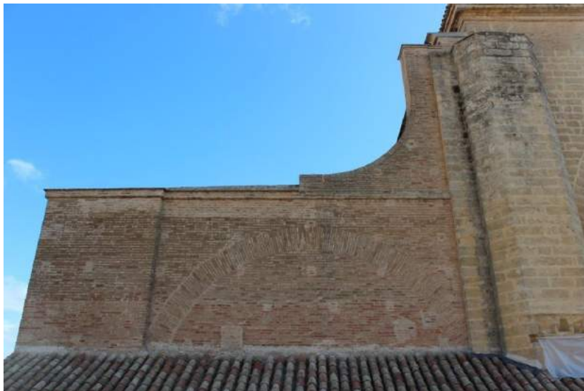
[95] Contrafuerte exterior de la nave coral. Catedral de Córdoba. Juan de Ochoa, 1598.
