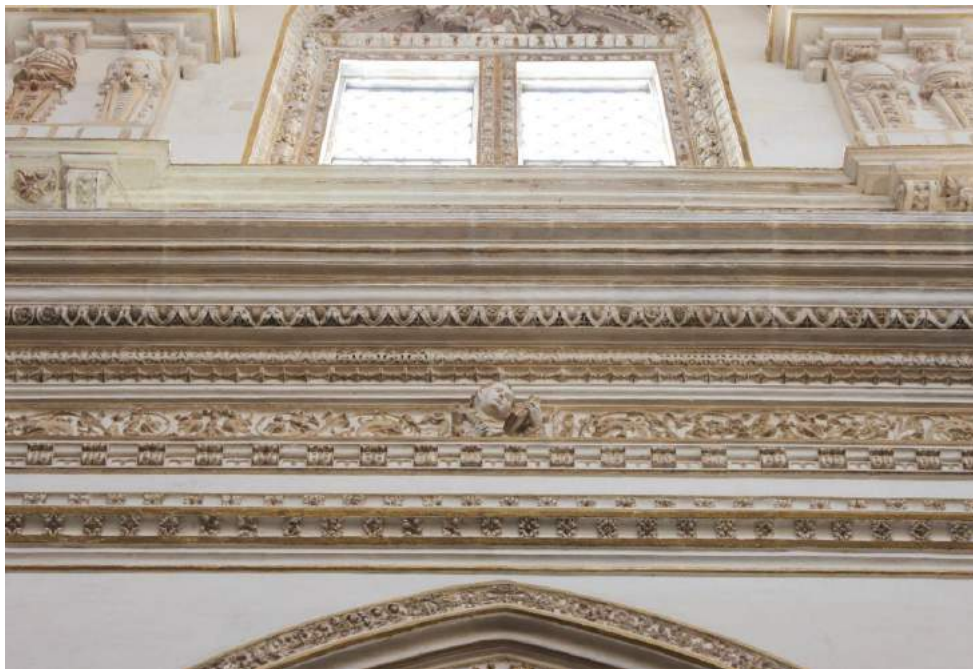
[92] Cornisa en cantería labrada en el segundo tercio del siglo XVI por Hernán Ruiz I, sobre la que continuó edificando Juan de Ochoa a partir de 1598. Nave del coro, Catedral de Córdoba.
