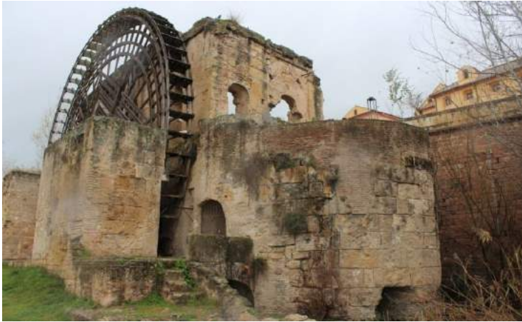
[46] Molino de la Albolafia , de origen romano y modificado en época califal y siglo XVI. Córdoba, río Guadalquivir.
