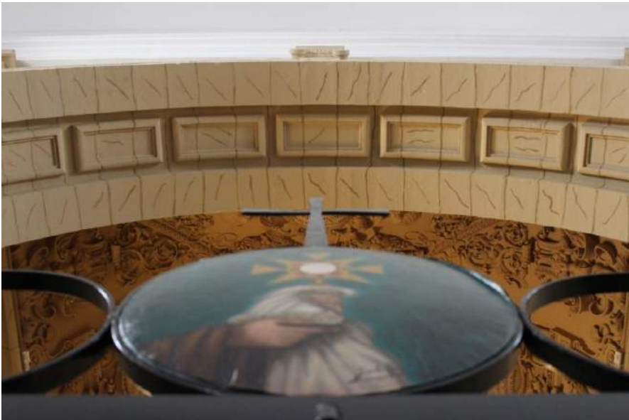
[51] Detalle del intradós del arco toral. Iglesia del ex convento de Santa Isabel de los Ángeles, Córdoba. Juan de Ochoa. 1583.
