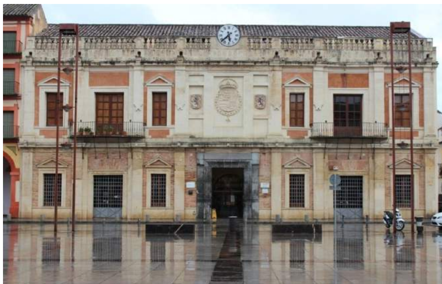
[65] Córdoba, Plaza de la Corredera. Edificio de la Cárcel y Casa del Corregidor (fachada). Juan de Ochoa, 1583-86.
