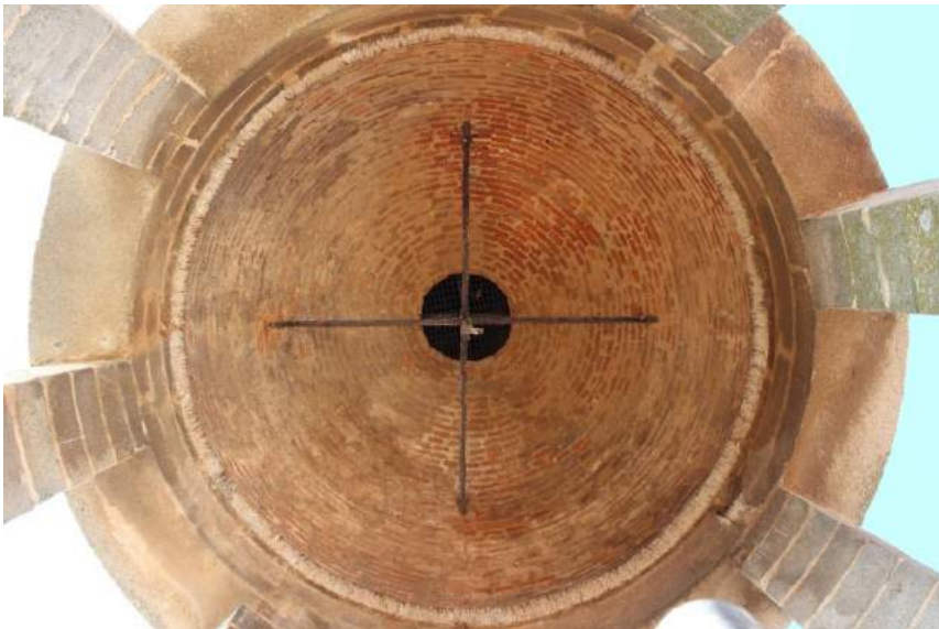
[77] Torre parroquial de El Salvador, Pedroche. Interior de la bóveda baída del chapitel (det.) Juan de Ochoa, 1588-90.
