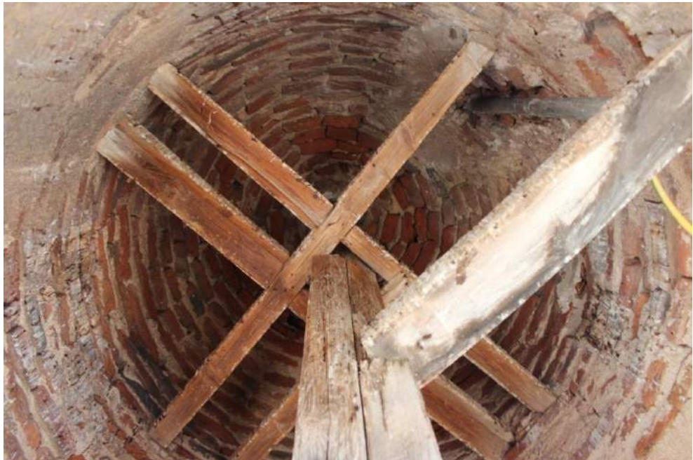
[72] Torre parroquial de San Juan Bautista, Hinojosa del Duque. Interior de la bóveda reforzada con tirantes de madera (det.) Juan de Ochoa. 1588-89.
