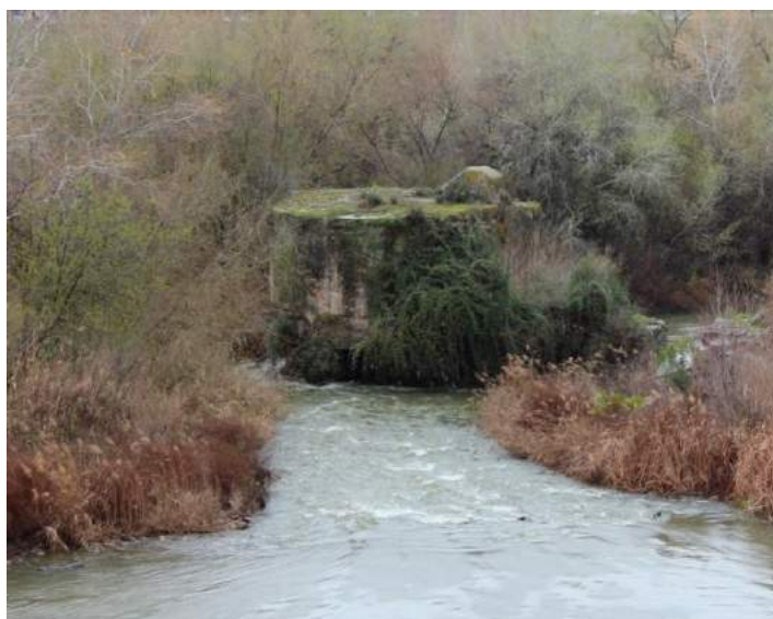
[45] Molino de Enmedio . Fachada septentrional soterrada por la vegetación de los sotos de la Albolafia. Córdoba, río Guadalquivir. Fábrica original medieval.
