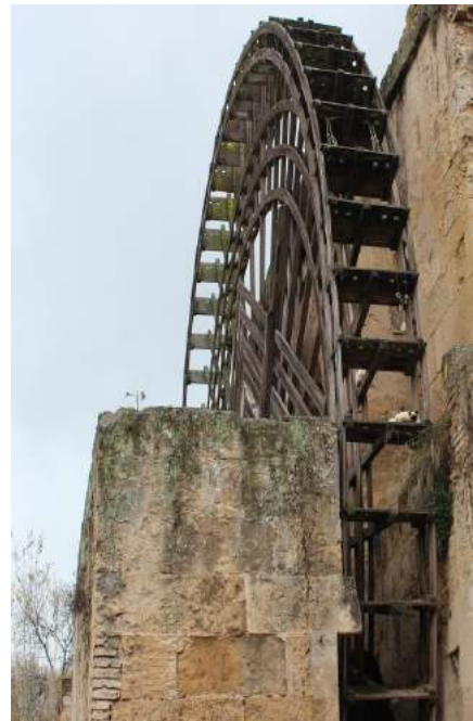
[47] Molino de la Albolafia (detalle de la noria elevadora de agua). Córdoba, río Guadalquivir.
