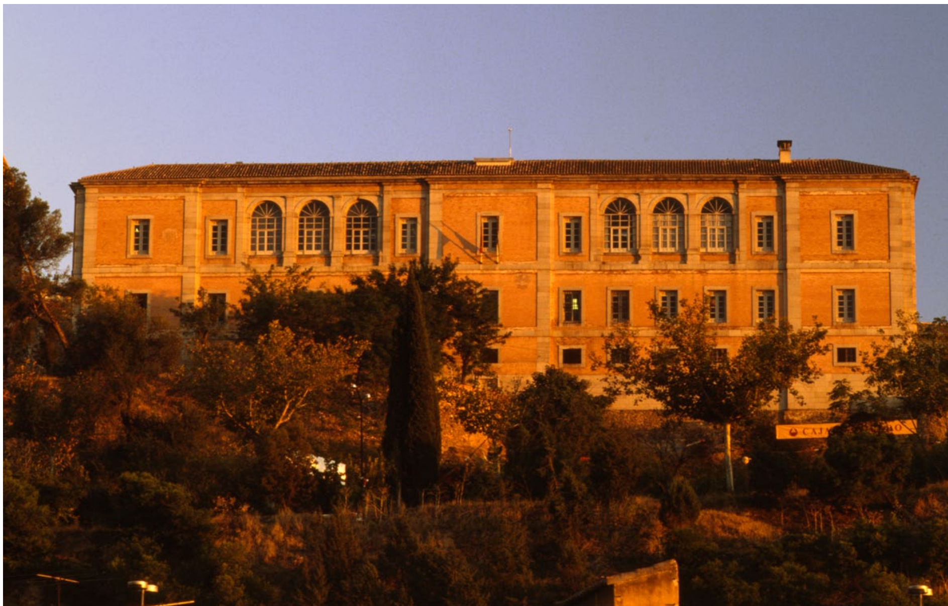
FACHADA TRASERA, ABIERTA A LA VEGA
