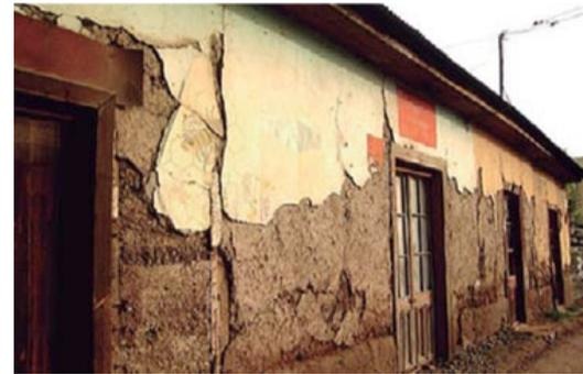
Fig. 1: Paramento exterior de adobe y empañetado con visible deterioro
