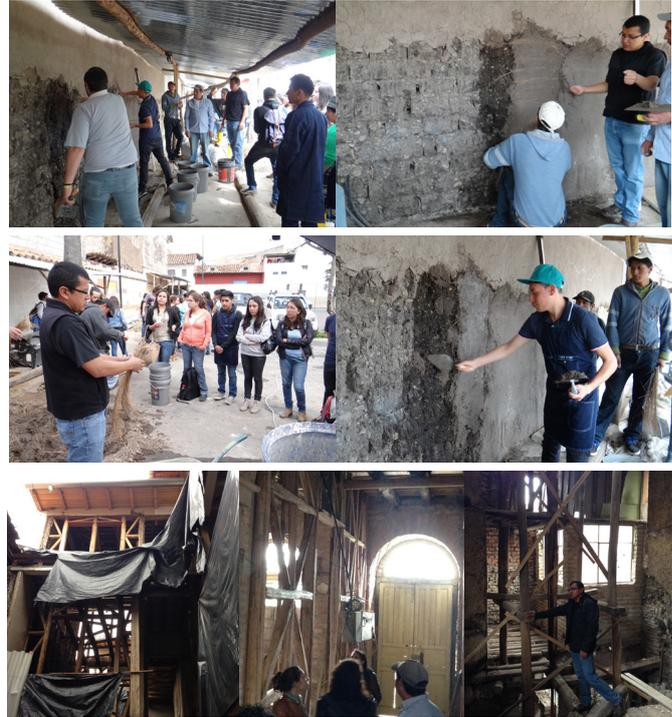
Fig. 4: Fotografías Taller de revestimiento, marzo 2016. Fuente: Proyecto vIirCPM
