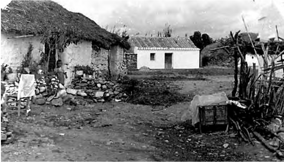
Viviendas en Los Barrios. Años cincuenta a sesenta. Fuente: web Los Barrios.
