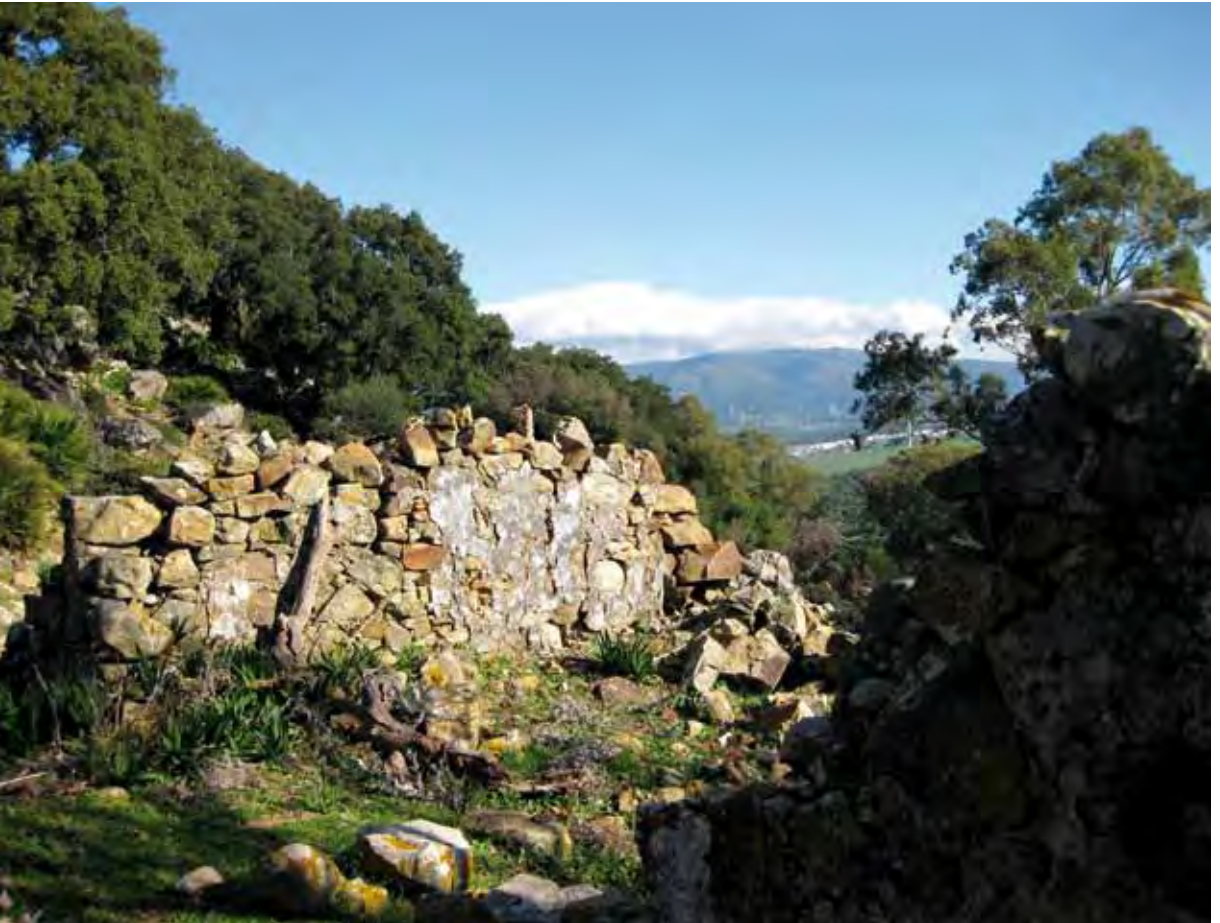
Quinta vivienda, en estado ruinoso, situada junto a la cuarta vivienda.
