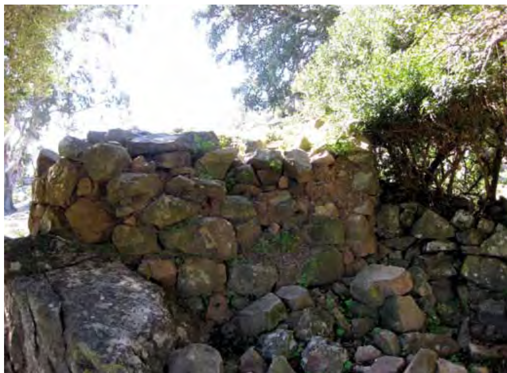
Primer horno de piedra, de base circular y boca orientada hacia el norte. La bóveda se ha derrumbado. Está construido junto a una roca y a cierta distancia de las viviendas.
