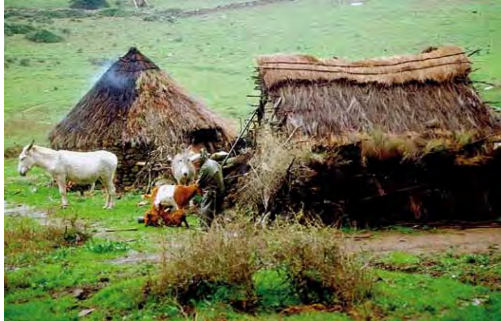
Vivienda de un pastor. Venta de Ojén. Años 80. La choza de planta rectangular sería la casa de las camas y la de planta circular la casa de la candela. En la segunda el humo sale a través del techado vegetal. Fotografía: Juanlu González Pérez.
