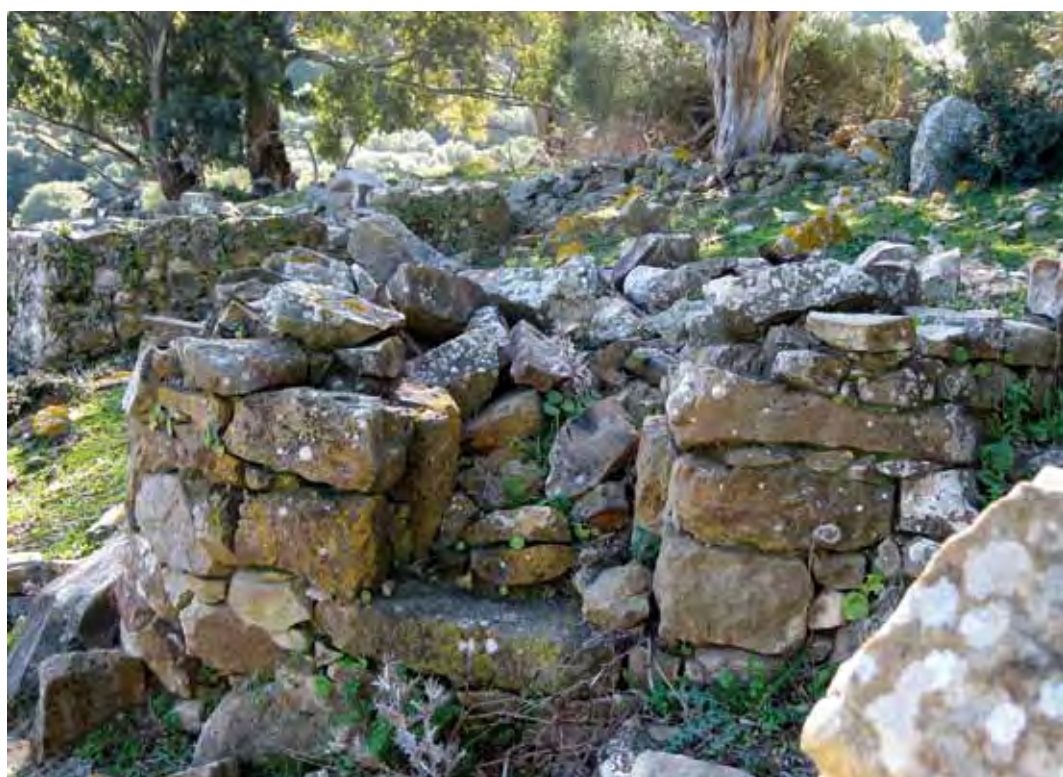
Segundo horno, cercano a un grupo de viviendas. Es de base circular. Su bóveda se ha derrumbado hacia el interior.
