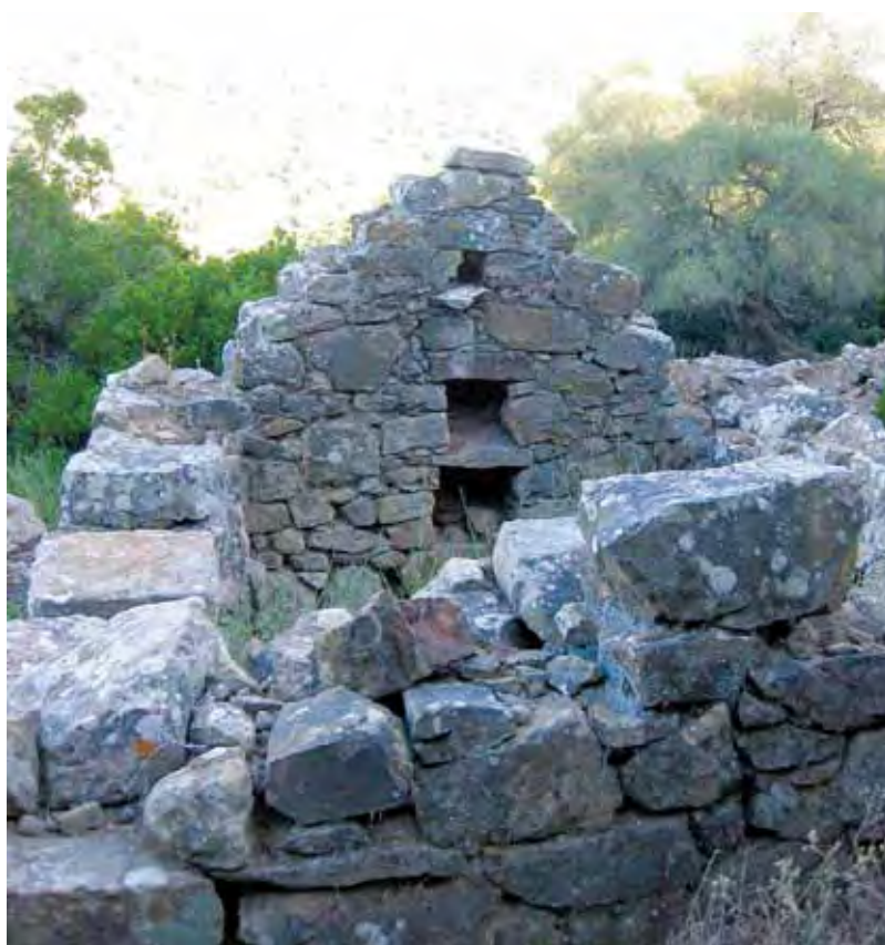
Cocina de la sexta vivienda, con alhacenas.
