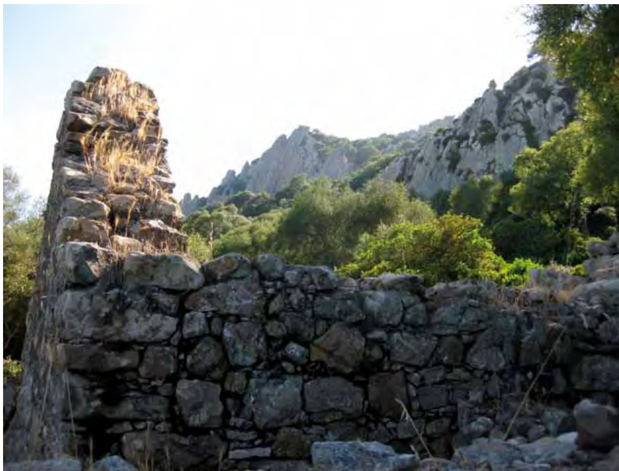
Casa de las camas de la primera vivienda. Puede observarse la construcción en doble hilera del muro. Al fondo, un cresterío rocoso.
