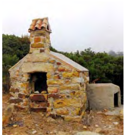
Horno comunitario de piedra junto a la ermita de El Chaparral.
