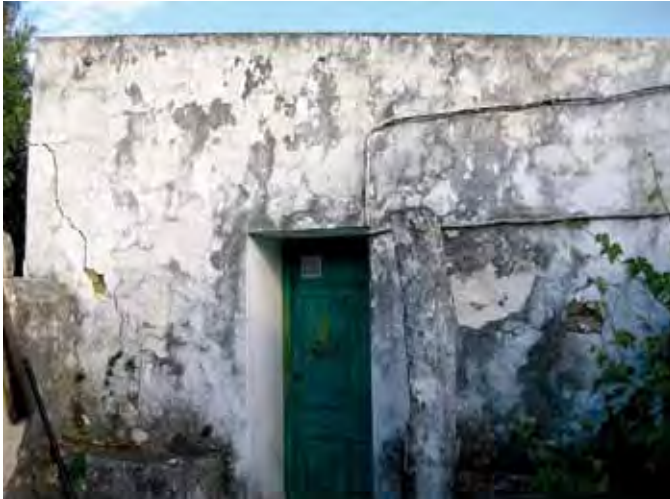
Casa de la candela, con techo de cielo raso. A ambos lados de la puerta hay dos bancos de mampostería. Pueden verse dos conducciones de electricidad a la altura superior de la puerta.
