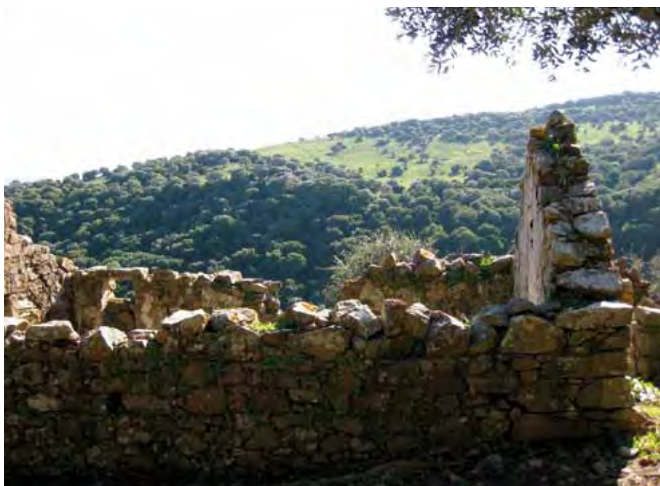
Vista lateral con detalle del muro de piedra de doble hilera.
