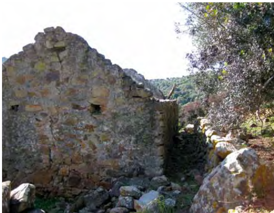
Segunda vivienda, vista desde el extremo opuesto. A su derecha hay un paso delimitado por un murete de contención.
