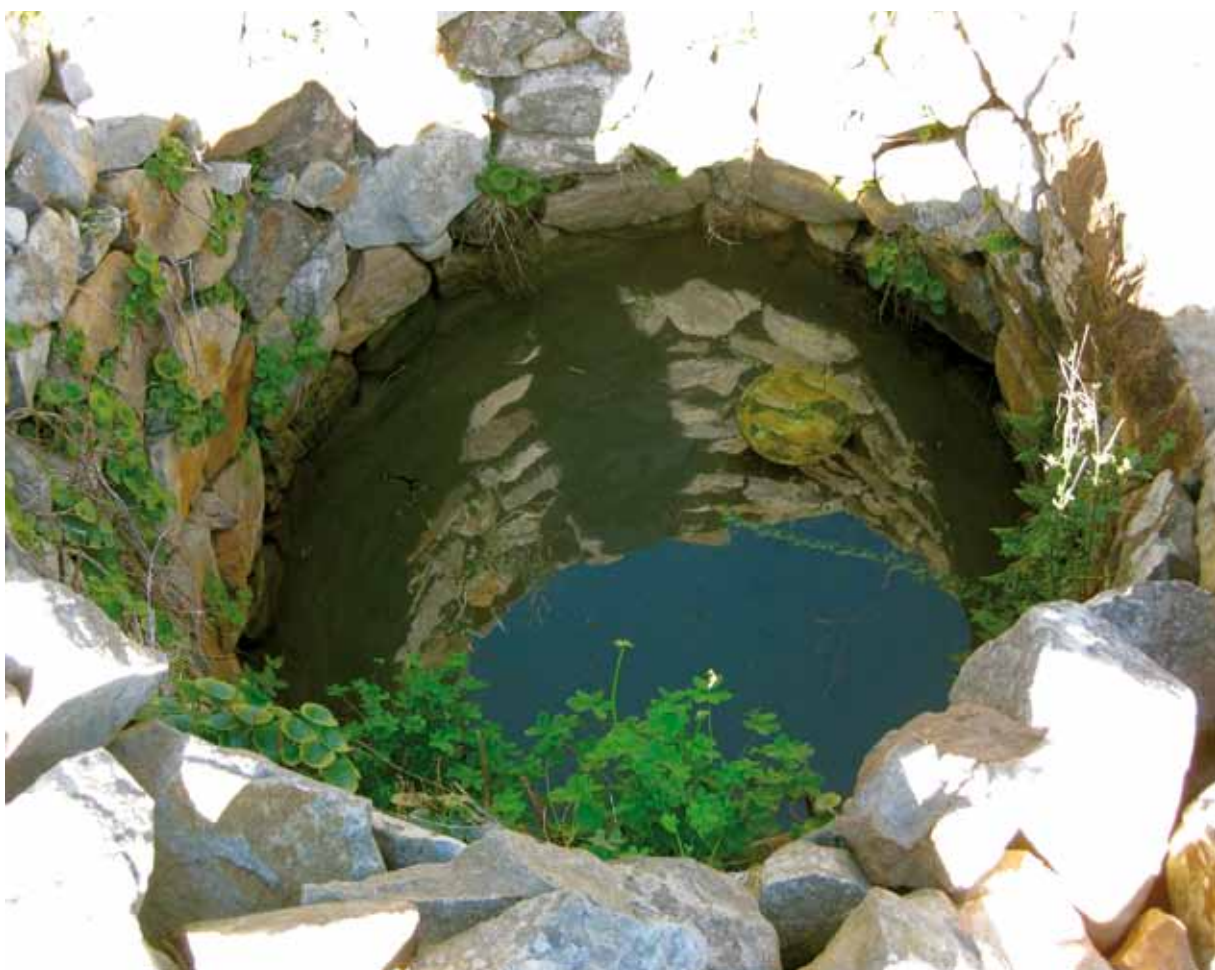
Vista interior del pozo.
