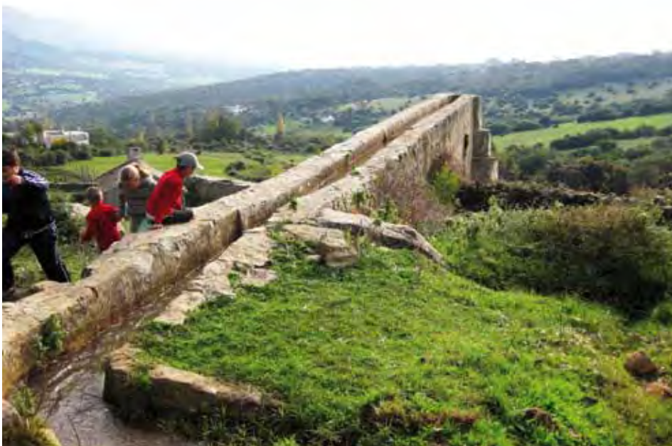
Molino harinero hidráulico de Puertollano (Tarifa). Interior y vista del canal que recoge las aguas del arroyo del Rayo y las conduce a la atarjea. Imágenes tomadas en 2009.
