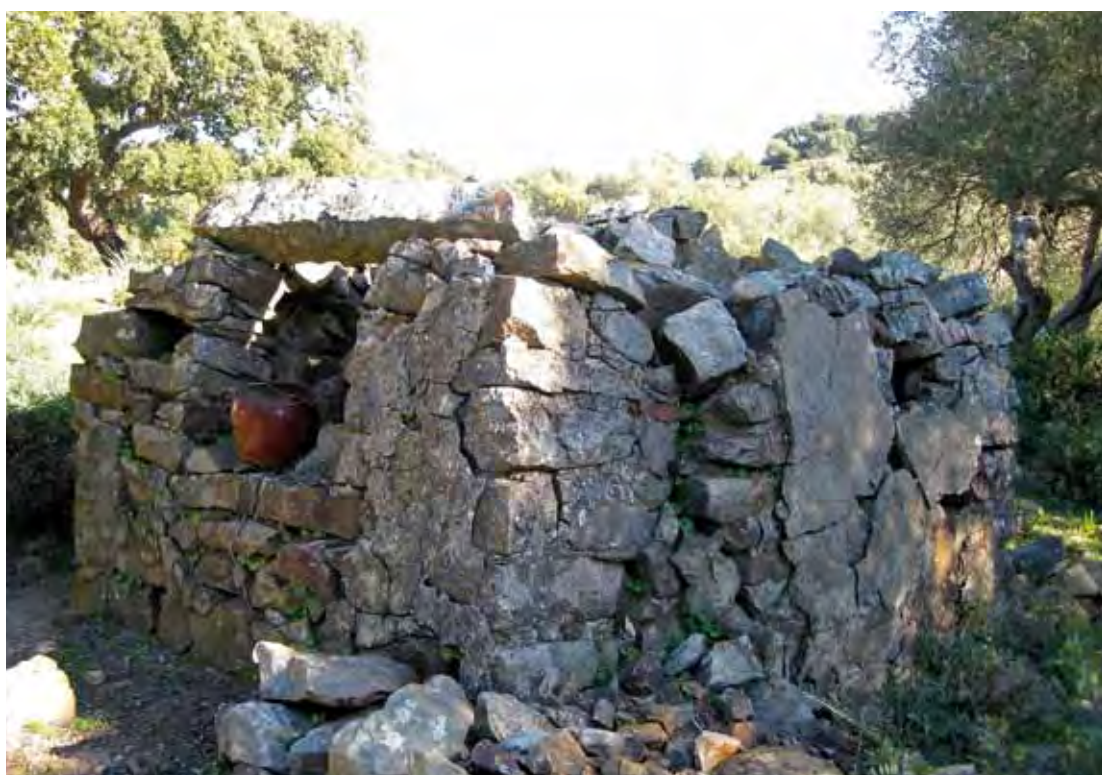
Gran horno comunitario de piedra, cercano a la vivienda anterior. Se conserva en mejor estado que los anteriores hornos. Sus paredes parecen haber ha sido enlucidas hace pocas décadas.
