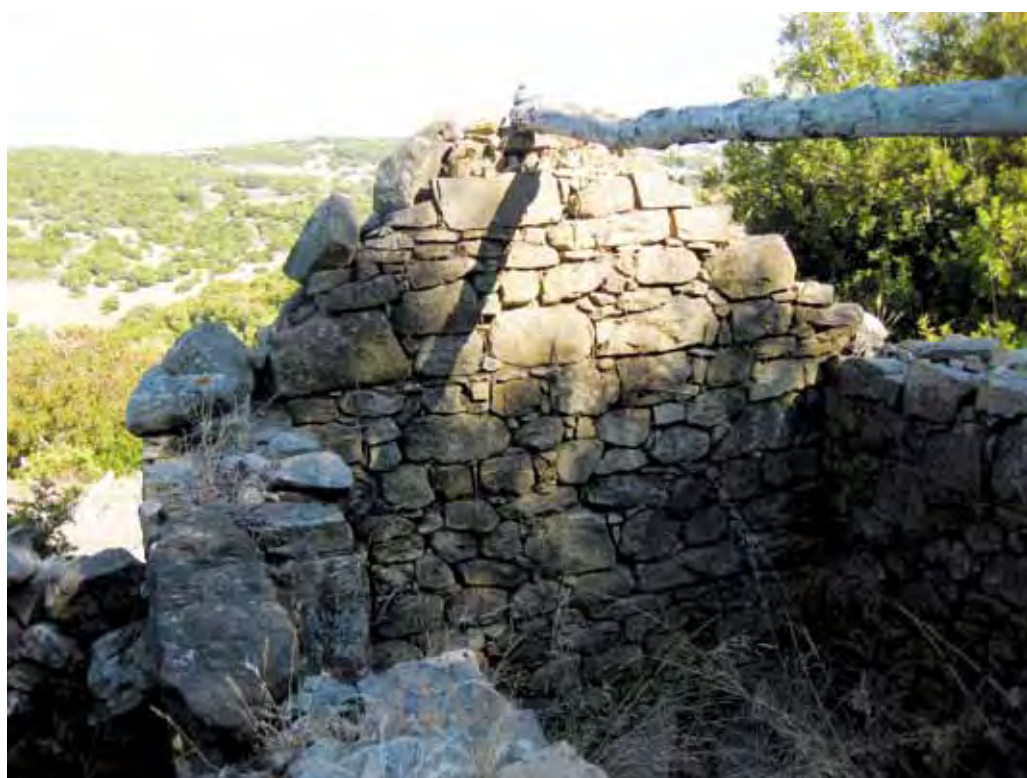
Cocina de la primera vivienda. (1) Detalle de la viga transversal y de alhacenas en una de las paredes. (2) Pared opuesta. A la derecha se ve un lentisco y al fondo un pinar sobre arenas.
