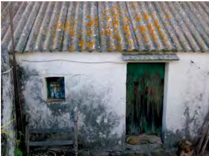
Casa de las camas, con techo de uralita. Sobre la puerta hay una sencillo alero y una conducción de electricidad.
