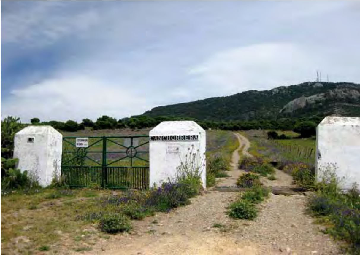
Acceso rodado a la finca de La Canchorrera, y cancela a la izquierda. Se observa al fondo el monte denominado Silla del Papa.
