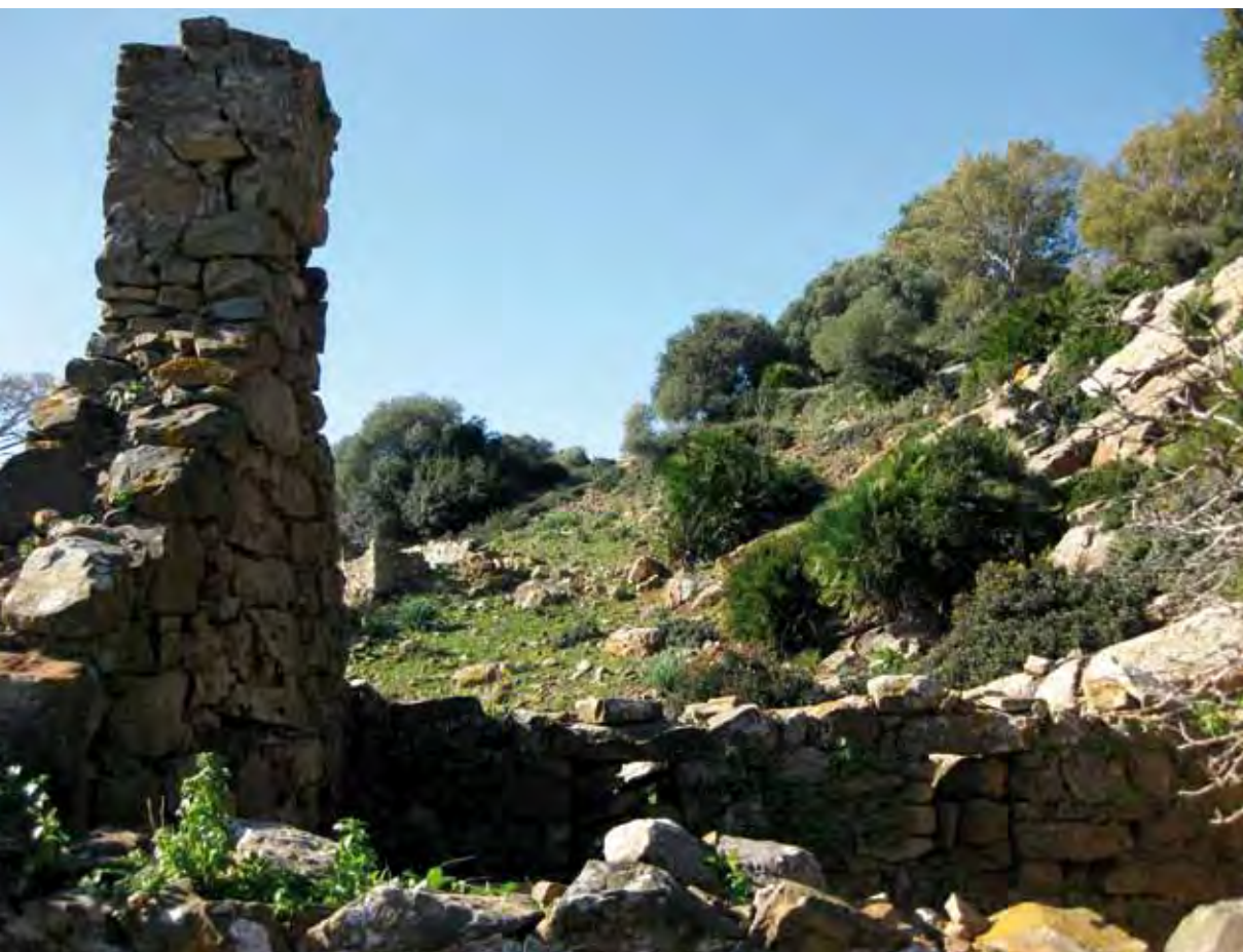
Vista lateral y en picado del interior de la casa de la candela, tomada desde el patio.
