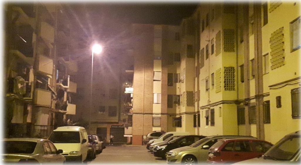
Imagen nocturna de edificios de La Zona
