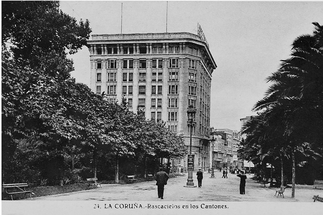
Imagen 49. Edificio del Banco Pastor, proyectado por los arquitectos Tenreiro y Estellés, que fuera durante varios años el edificio más alto de España.
