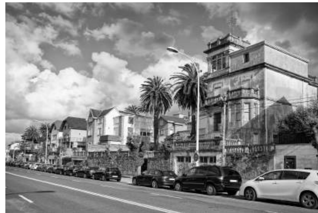
Imagen 42. La vivienda, que perteneció a Ramón Rivera, a la sazón dueño de la compañía cervecera Estrella Galicia, fue diseñada por Antonio Tenreiro.
