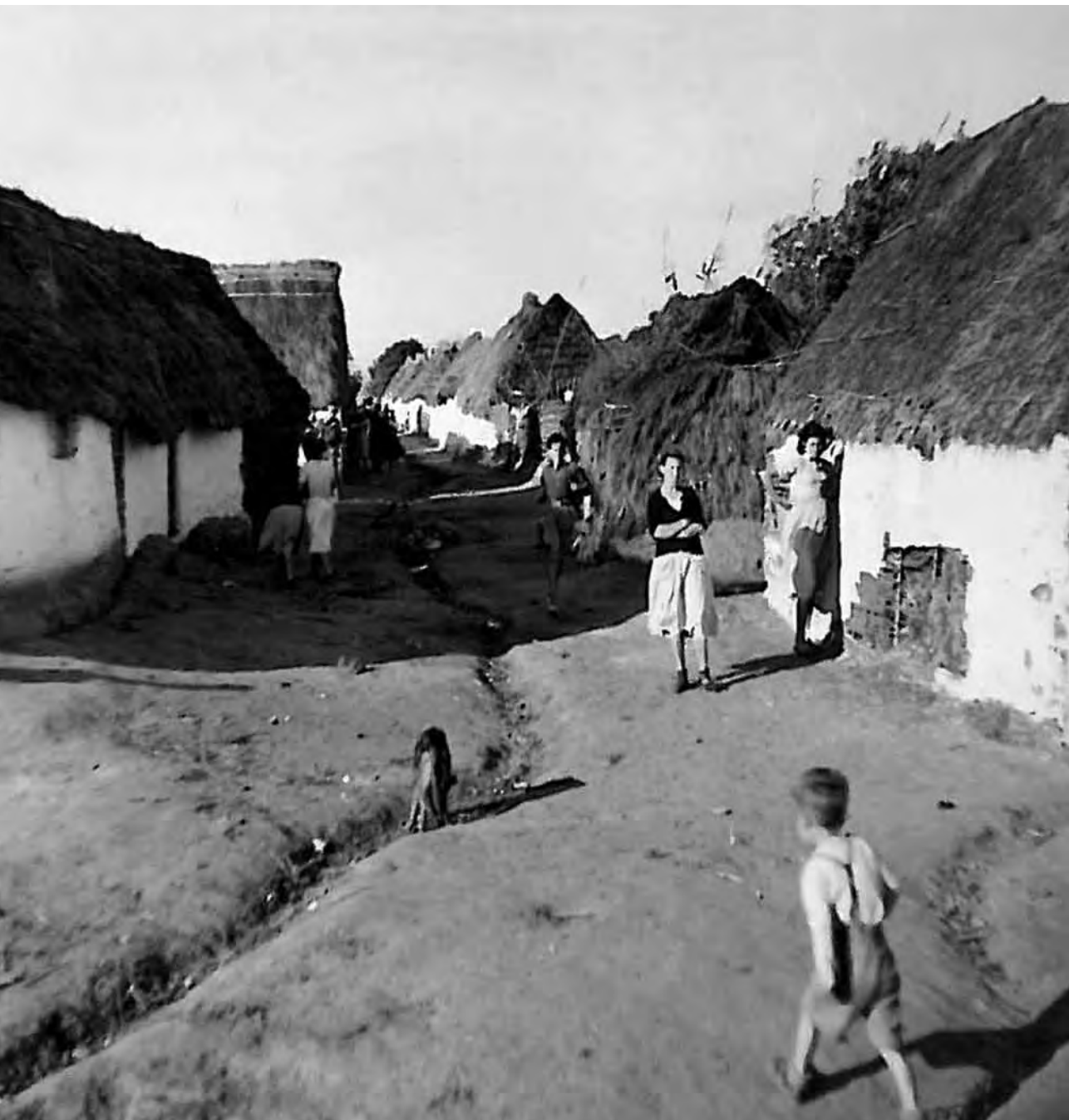
Calle del Río, en la Estación de San Roque. Las chozas son de junco y barro con paredes encaladas. Hay varias personas y un perro. En el centro de la calle, un surco canaliza las aguas negras.
