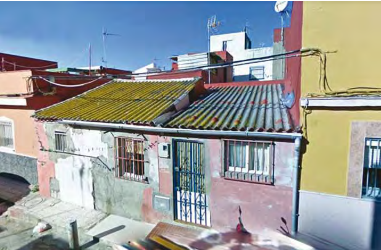
Barraca reformada en la calle Villaverde número 39, de la barriada de La Atunara (La Línea). Año 2015. Imagen: Google Maps.
