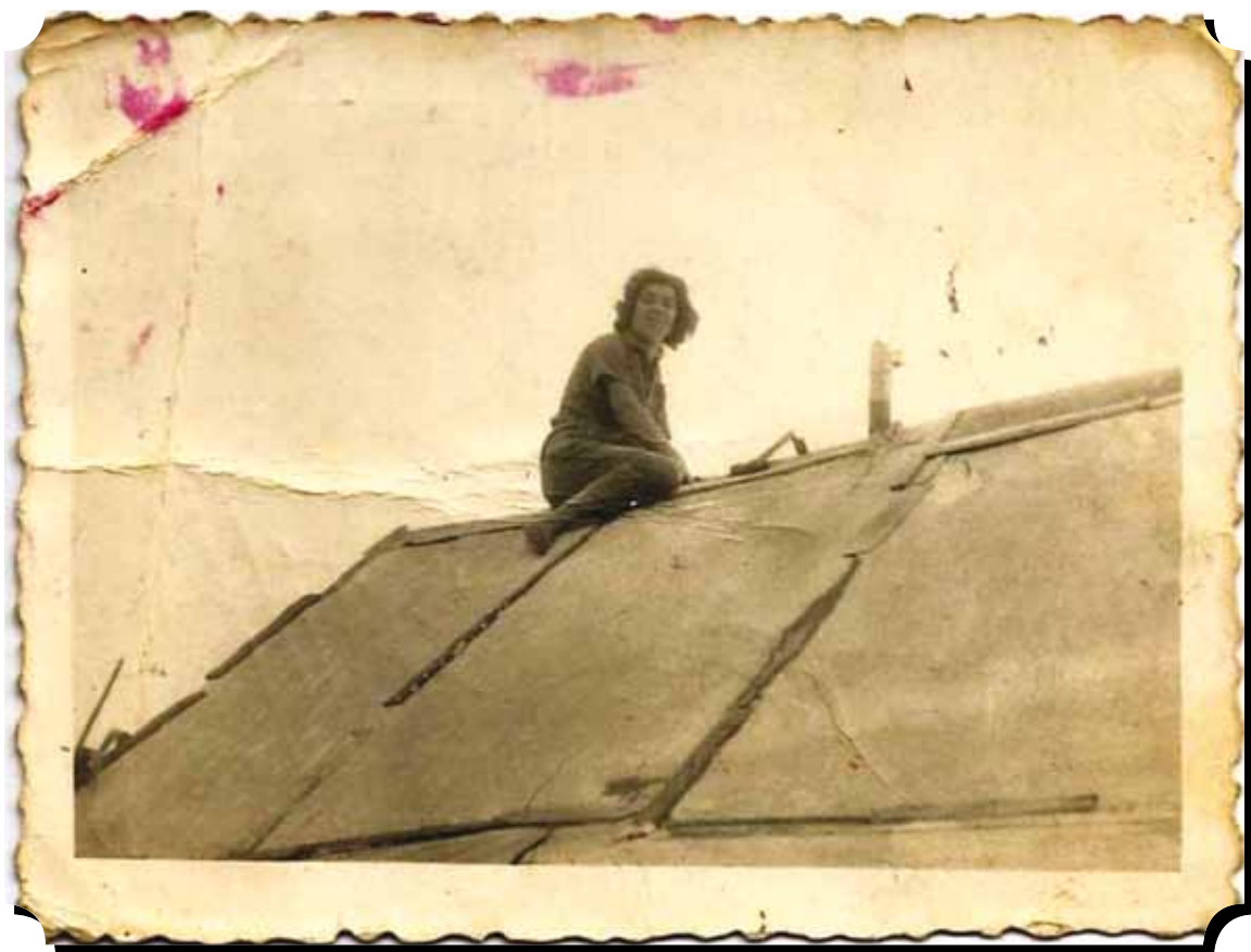
Trinidad Gómez arreglando el techo de su barraca en los años 60. La Línea.
