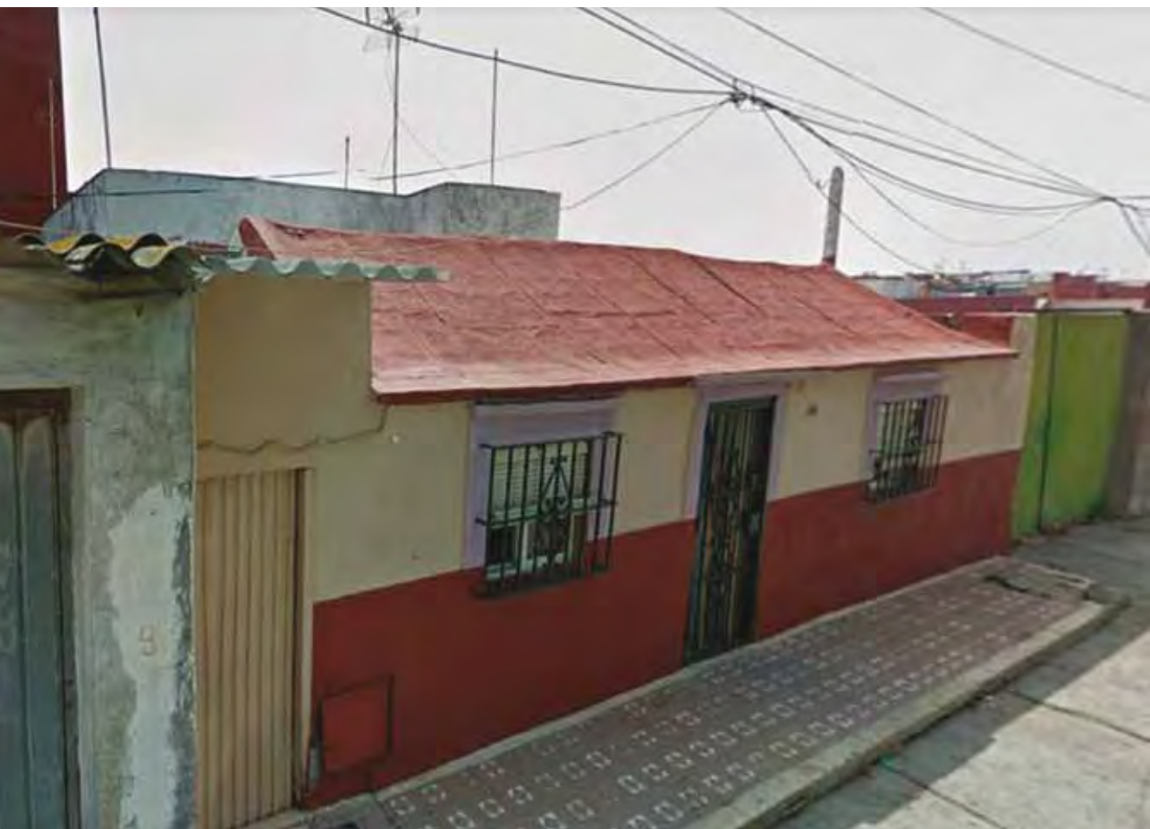
Barraca reformada en la calle Villaverde número 26, de la barriada de La Atunara (La Línea). Año 2015. Imagen: Google Maps.
