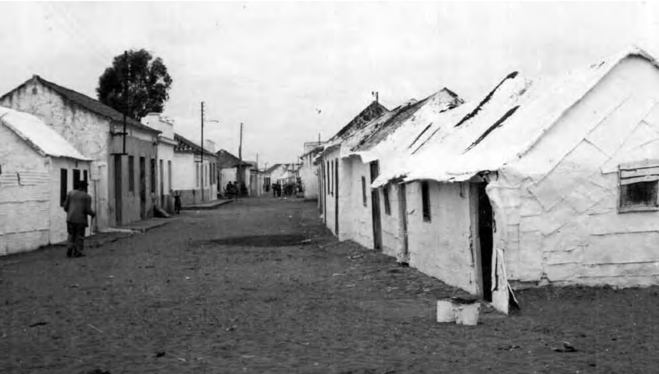
Calle de La Atunara (La Línea). Las casas con tejado de teja conviven con barracas con techo de chapa, que están pintadas o encaladas. Años 60 ó 70.
