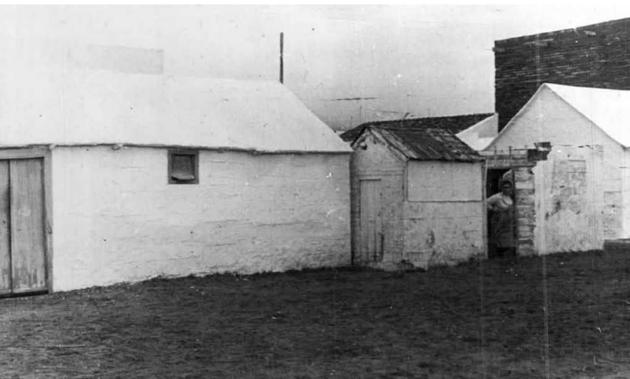
Calle Oquendo (La Atunara, La Línea). Viviendas de Antonio García y de Antonio Cabrera Rodríguez. Una mujer está en la puerta de lo que parece ser un patio.
