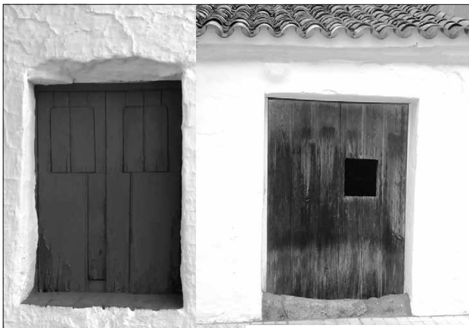
Ventana y puerta.
