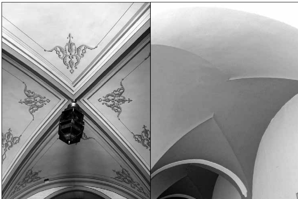
Bóvedas de crucería.
