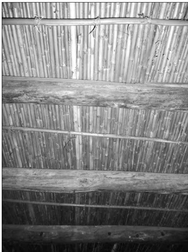
Cubierta de teja vana: vigas y cañizo.
