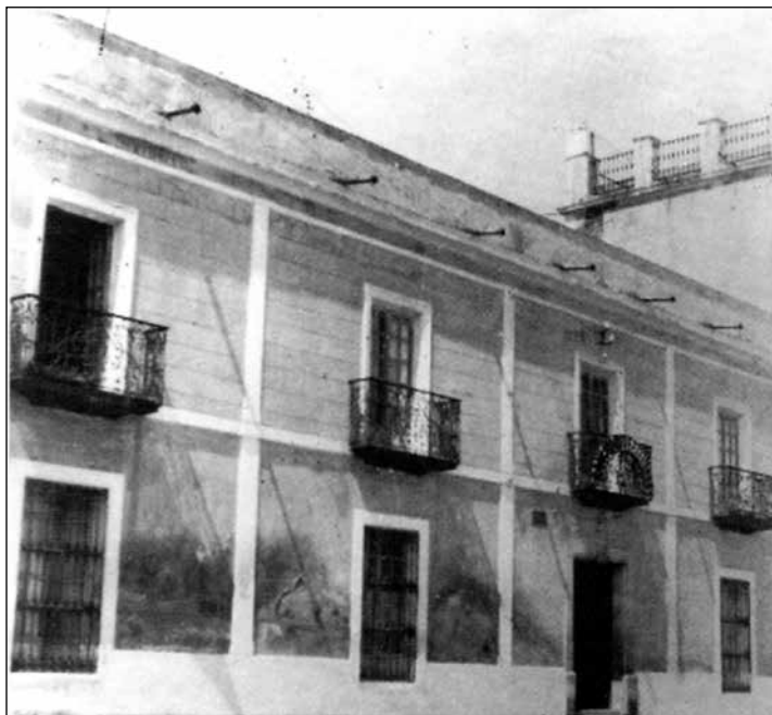
Palacio de la Encomienda y sede del Ayuntamiento
