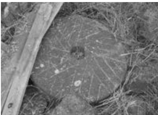
Piedra molinera del molino de la Cruz de La Pasión; obsérvese el dibujo tallado en la muela, 2016 [ALT]
