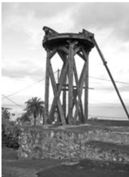
Molino de Breña Alta; obsérvense el timón elevado y la plataforma giratoria circular, ca. 1960 y 2015 [AMBA y ALT]
