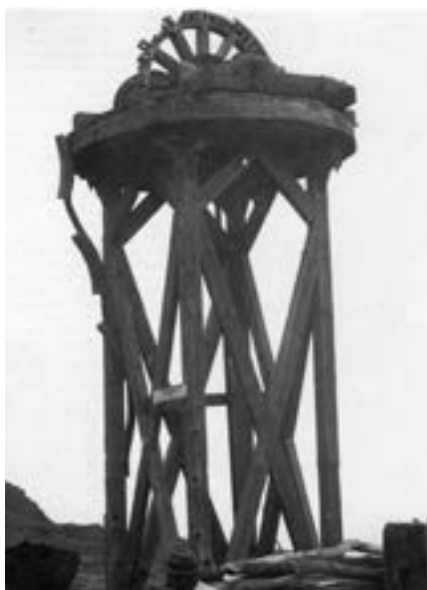
Molino de Breña Alta; obsérvense el timón elevado y la plataforma giratoria circular, ca. 1960 y 2015 [AMBA y ALT]
