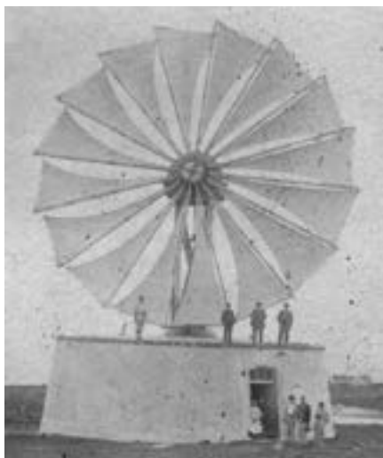
Molinos de viento harineros del Sistema Ortega: a. Molino de Monte Pueblo, ca. 1955; b. Molino de viento sin identificar (La Palma); c. Molino sin identificar, probablemente Fuerteventura; d. Molino de viento sin identificar (La Palma) [AMCM]. Obsérvese la evolución desde las velas de madera a las textiles o de lona, incorporadas durante la primera década del siglo xx
