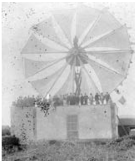
Molinos de viento harineros del Sistema Ortega: a. Molino de Monte Pueblo, ca. 1955; b. Molino de viento sin identificar (La Palma); c. Molino sin identificar, probablemente Fuerteventura; d. Molino de viento sin identificar (La Palma) [AMCM]. Obsérvese la evolución desde las velas de madera a las textiles o de lona, incorporadas durante la primera década del siglo xx
