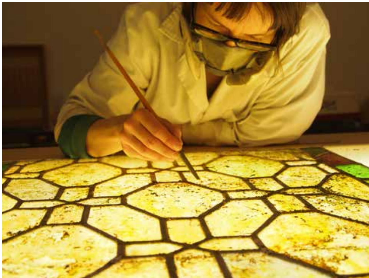
2. Trabajos de reconstrucción del rosetón de la Iglesia de Sant Esteve de Bordils, Gerona
