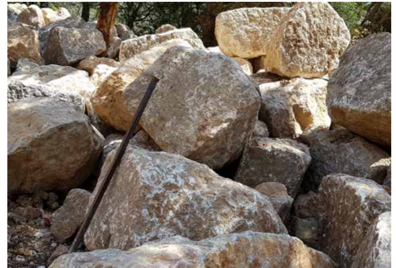
Piedras recuperadas del derrumbe del muro, listas para volver a usarse en su reconstrucción
