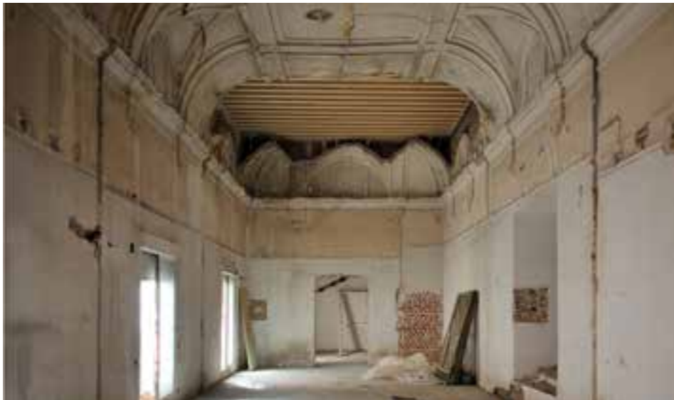
1. Estado previo a los trabajos de restauración en el nártex del Convento de las Comendadoras de Santiago de Madrid 2. Trabajos de restauración en el nártex del Convento 3. Patio de Moradillo del Convento de las Comendadoras de Santiago de Madrid, tras su restauración
