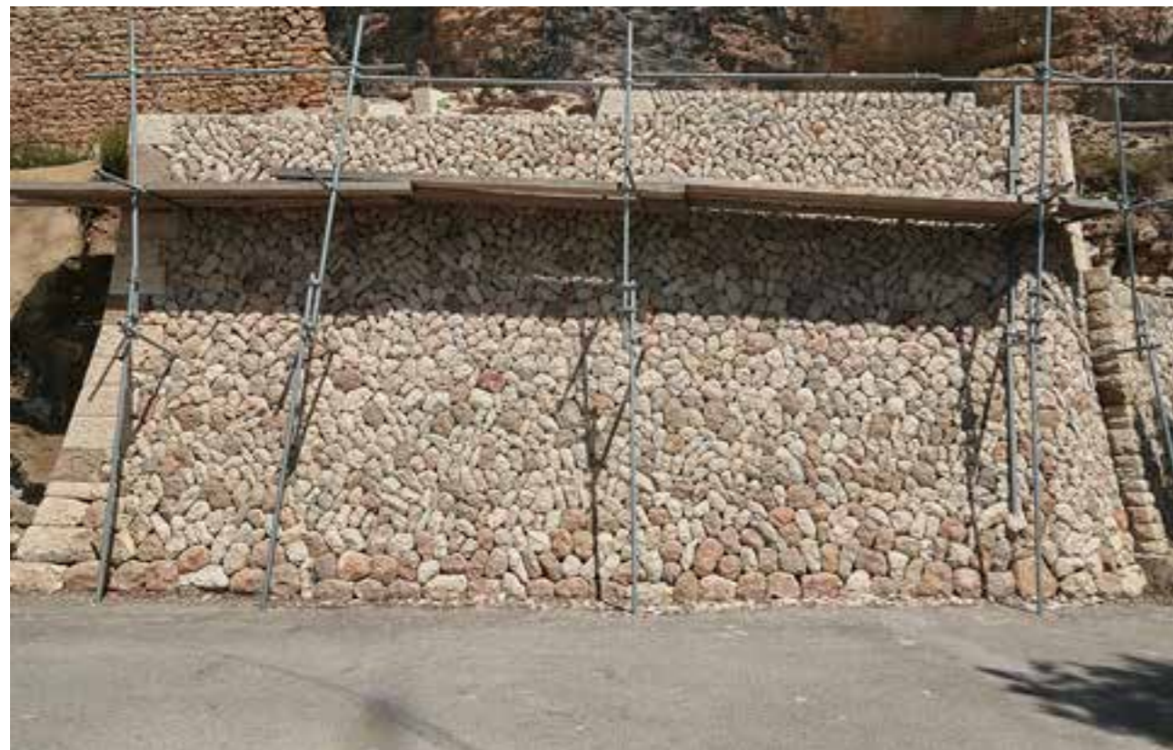
3. Cara exterior de un muro de mampostería y mortero de cal
