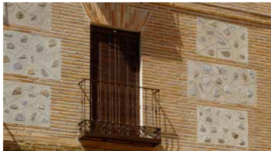
1 y 2. Revestimiento de ladrillo fingido en una fachada mudéjar de Toledo
