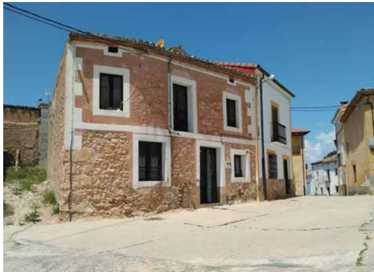
Construcción tradicional en Vildé, Soria
