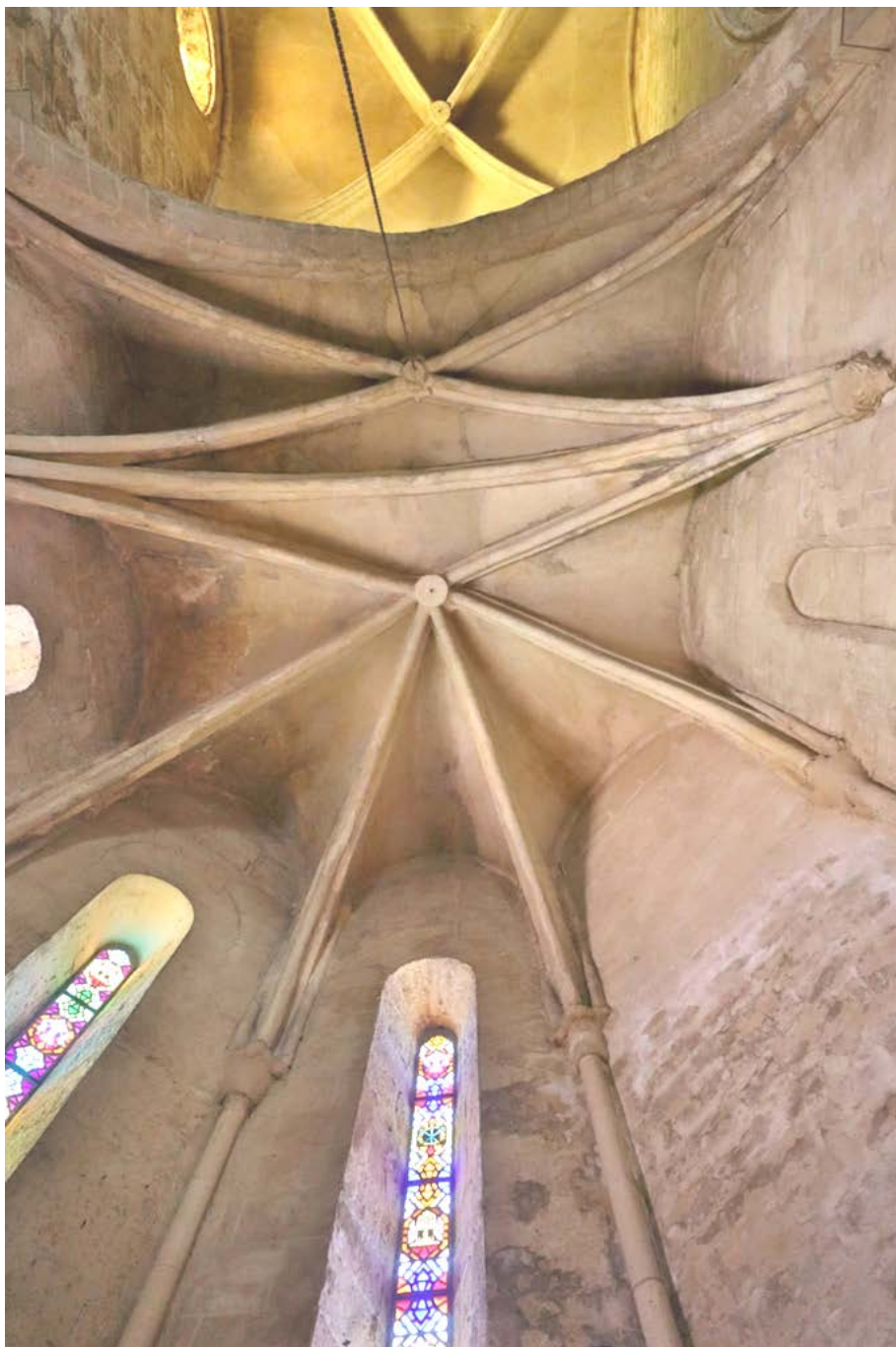
Bóveda de la capilla de la Vera Cruz (foto Jesús Mohedano)
