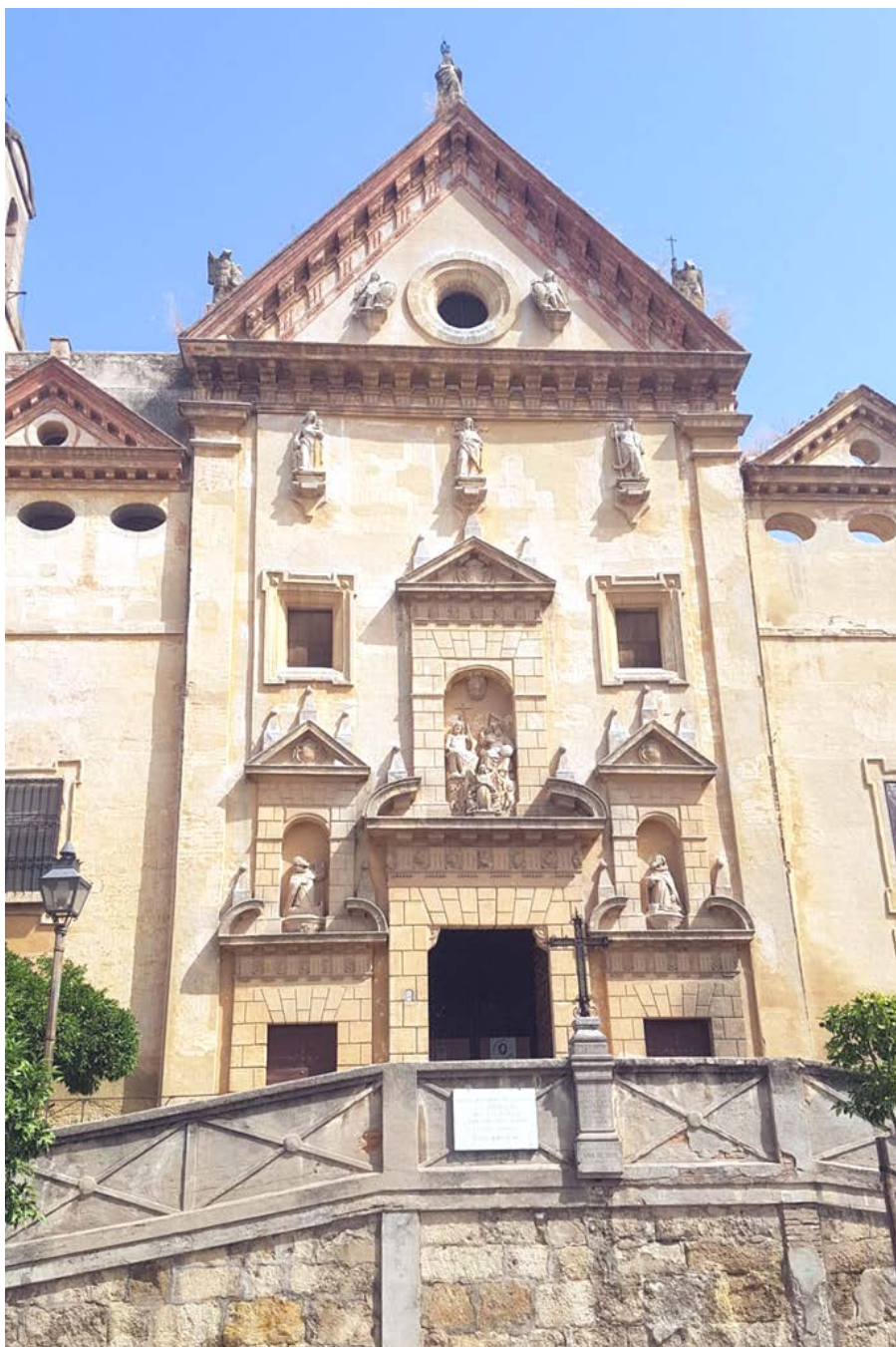
Fachada del templo de los trinitarios descalzos, primer asentamiento de los claretianos en la ciudad (foto Jesús Mohedano)
