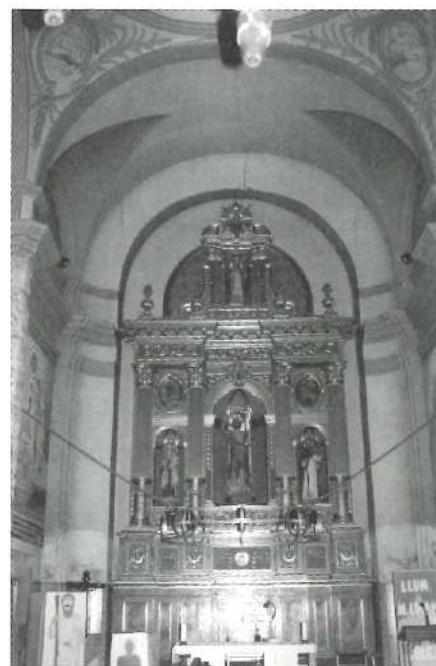
Fig. 50. Presbiteri de l'església del Palau d'Anglesola. Podem observar la volta de canó amb llunetes. (Foto: I. Puig.)
