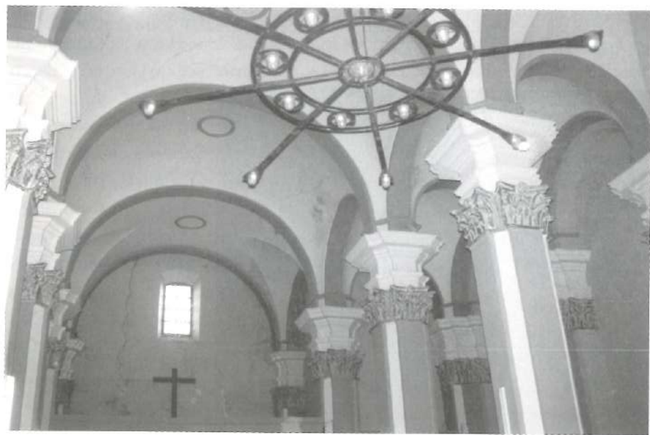
Fig. 38. Vista de l'interior de l'església de Rocafort de Queralt, des del creuer cap al cor, on podem observar les voltes bufades de tot el temple. (Foto: I. Puig.)
