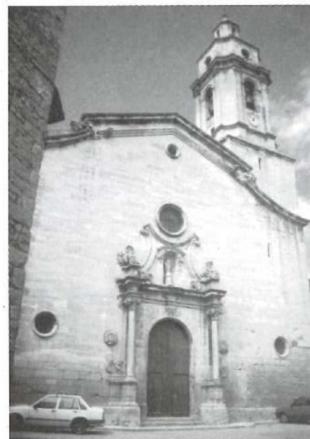
Fig. 18. Façana de l'església de l'Espluga Calba.
