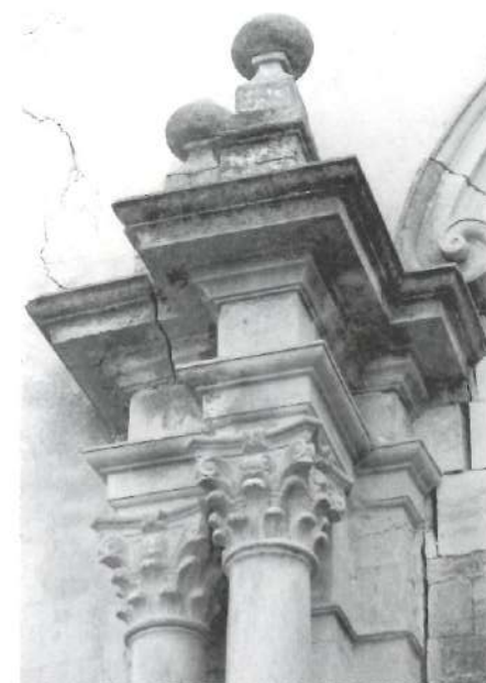
Fig. 29. Detall de l'entaulament, dels capitells i de les columnes de l'església de Rocafort de Queralt. (Foto: I. Puig.)
