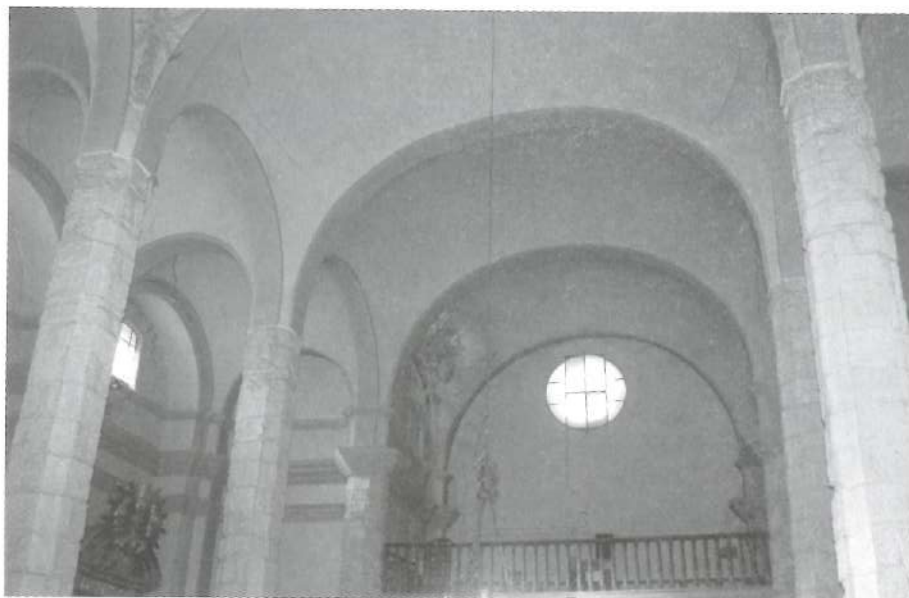
Fig. 37. Vista de l'interior de l'església del Palau d'Anglesola, des del creuer cap al cor, on podem observar les voltes bufades de tot el temple. (Foto: I. Puig.)
