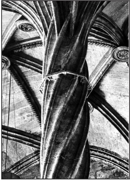
Pere Compte, secció d'una columna de la sala de contractació. Lotja de València (foto: Jordi Gumí).
