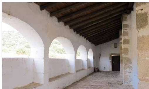
Pórtico, con arcos carpaneles y cubierta de madera
