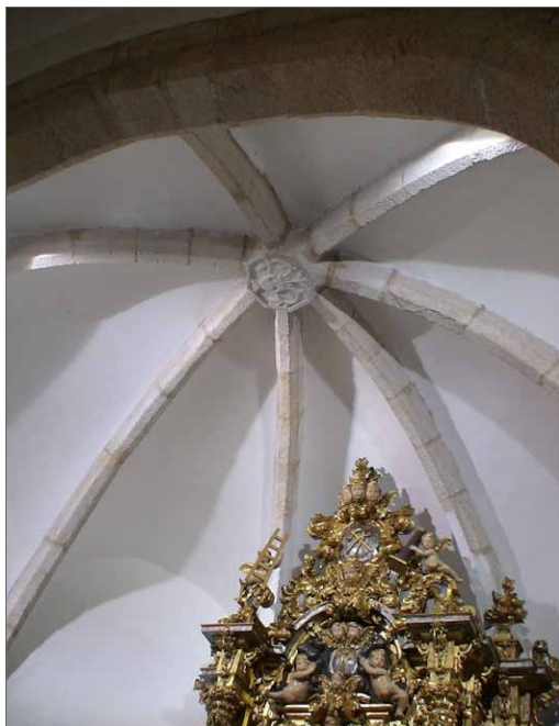
Cabecera cubierta con bóveda de crucería
