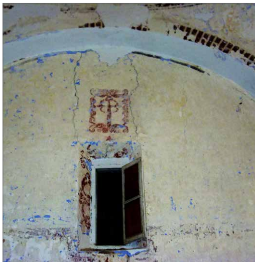
Proceso de restauración, 2008
