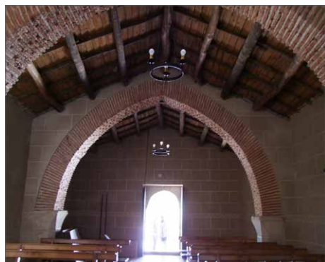
Nave dividida en tres tramos por arcos apuntados apoyados en anchos pilares achaflanado son de granito
