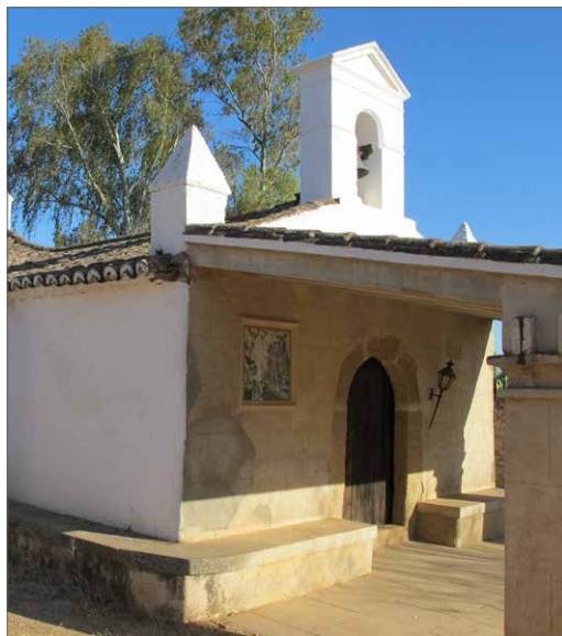
Vista lateral, detalle de los distintos volúmenes
