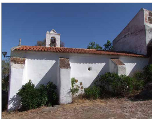
Detalle, contrafuertes que refuerzan la bóveda de medio cañón rebajado
