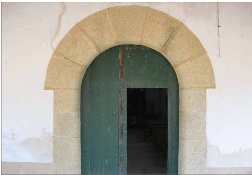
Puerta de acceso a la ermita
