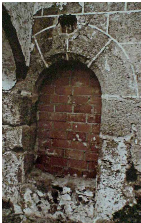
Acceso al interior, sin restaurar
