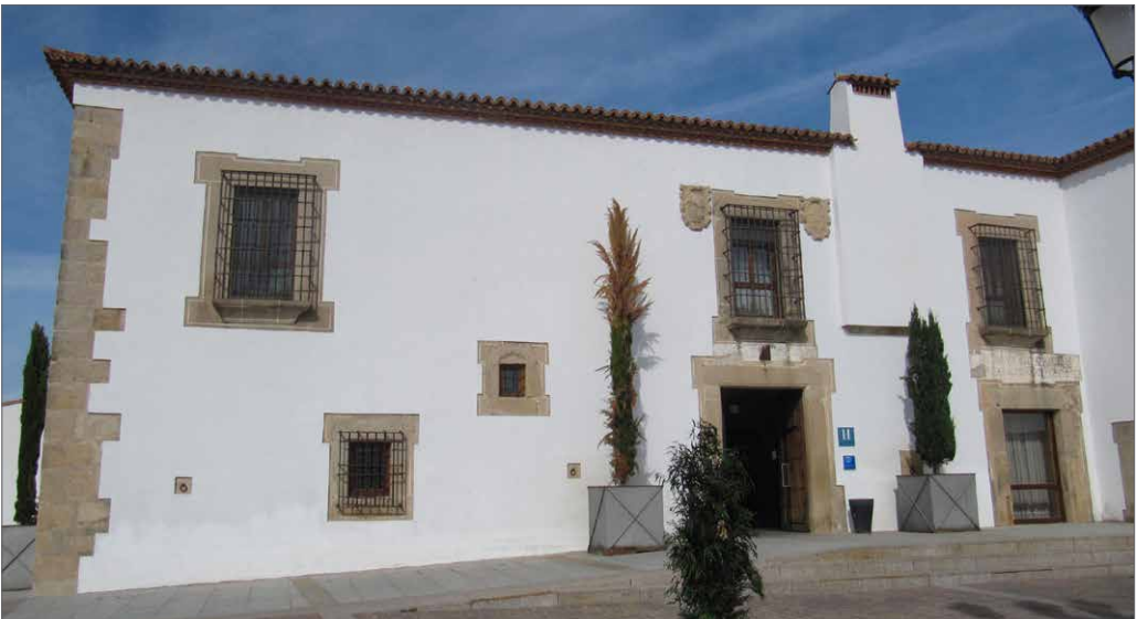
Casa de los Arenales
