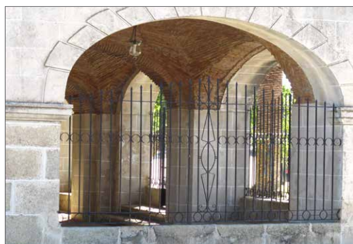
Detalle del pórtico y bóvedas de aristas de ladrillo
