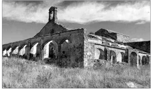
Ermita de San Benito, antes de su restauración
