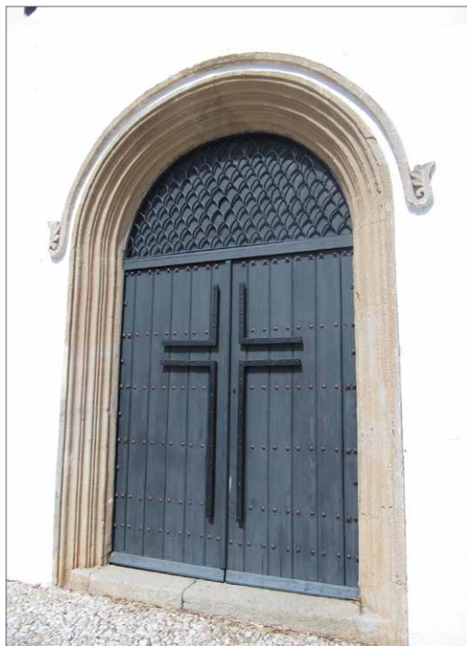
Portada, acceso al interior de la ermita
