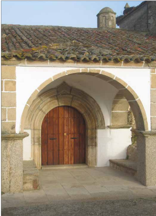
Entrada principal en el muro de la Epístola
