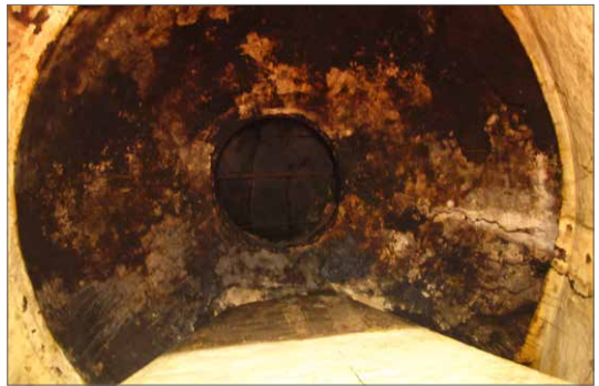
Cúpula de la capilla mayor
