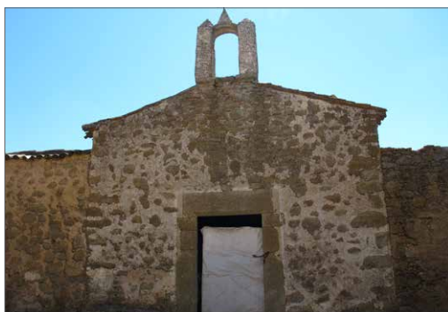
Fachada principal de la ermita y su espadaña
