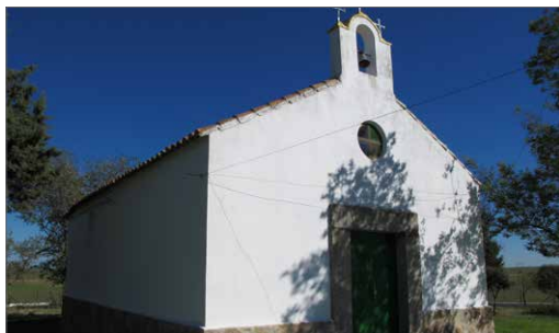
Fachada principal de la ermita
