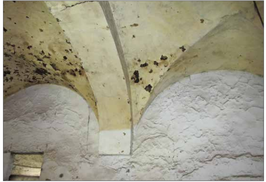
Nave de dos tramos cubierta con bóvedas de aristas
