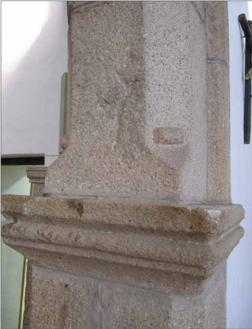
Restos Góticos en los pilares
