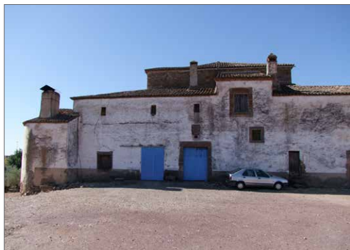
Casa de las Corchuelas
