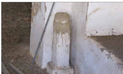
Resto de pilastrilla acanalada.
