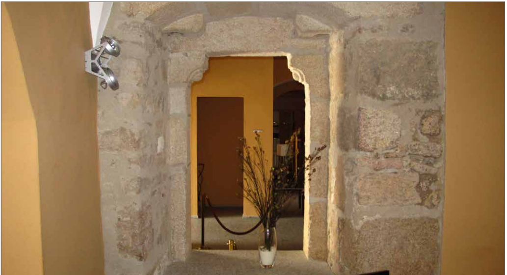
Restos de un ventanal
