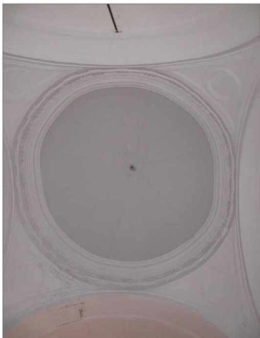
Cúpula semiesférica en el crucero
