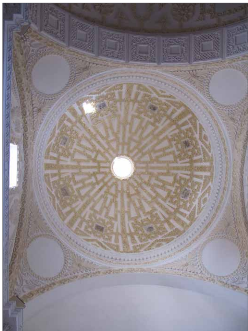
Cúpula sobre pechinas con linterna y vanos.
