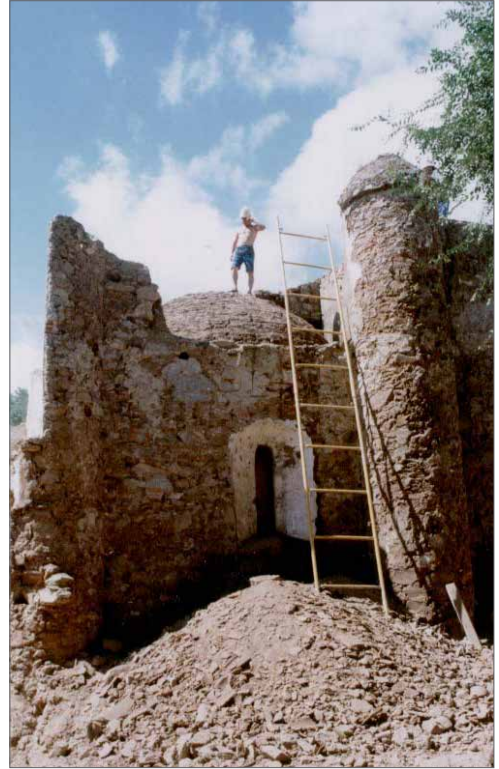
Detalle del proceso de restauración
