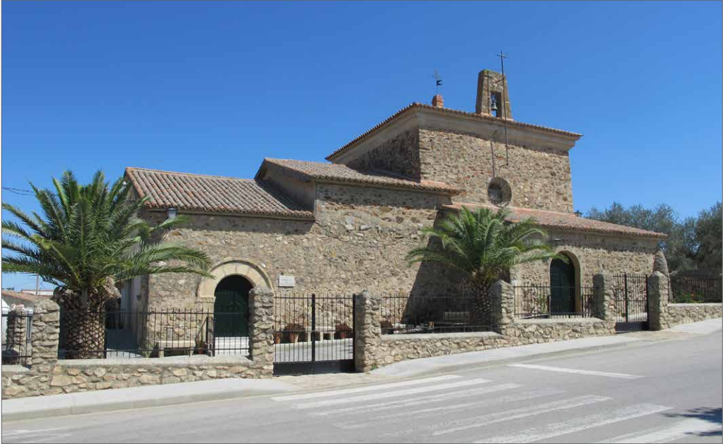
Vista panorámica de la ermita
