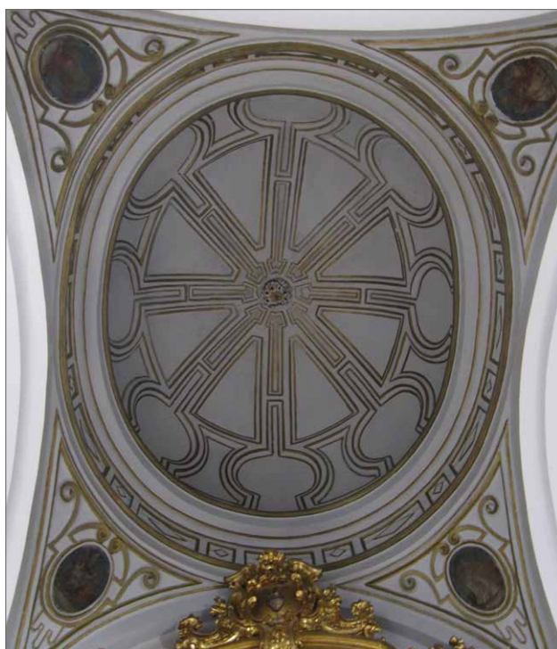
Cúpula de la capilla del Cristo de la Salud
