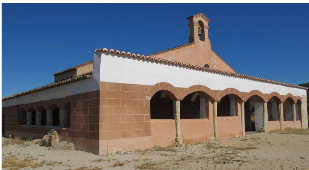
Ermita de San Benito, restaurada vista lateral y frontal
