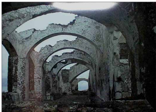
Portico de la ermita antes de la restauración
