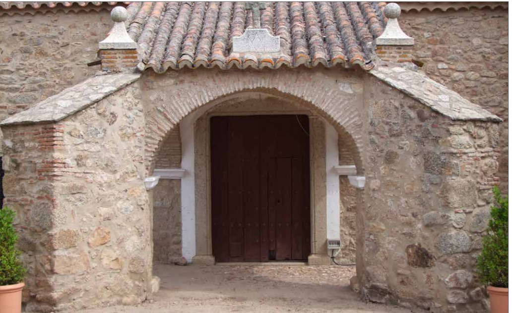
Acceso al interior de la ermita
