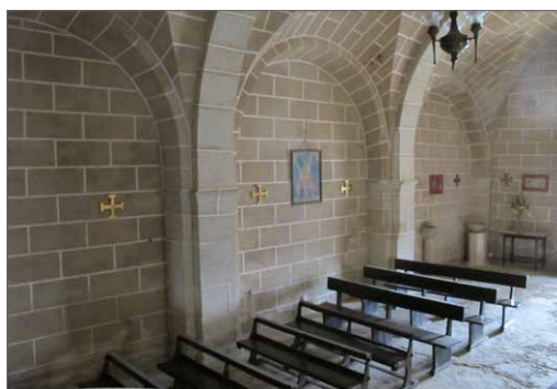
Nave dividida en tres tramos por arcos de medio punto sobre pilares adosados
