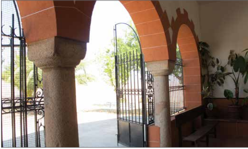
Detalle del pórtico
