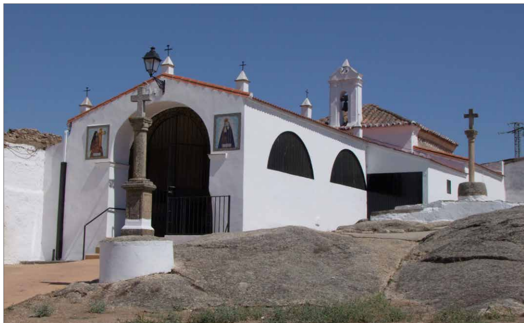
Vista panorámica de la ermita
