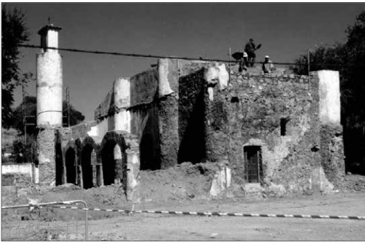
Ermita de Santa Ana en proceso de restauración
