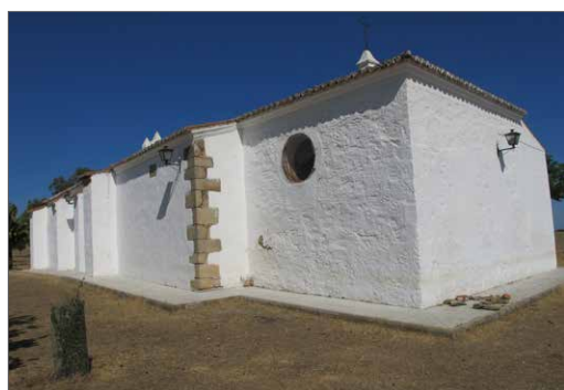
Detalle, muros exteriores
