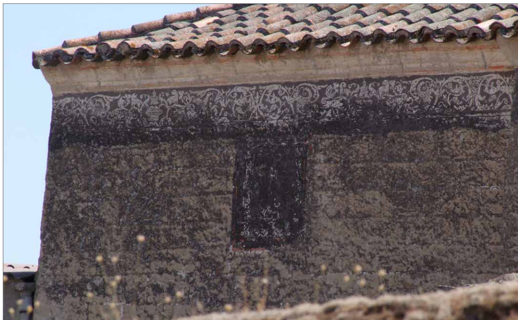
Esgrafiado en el exterior de la cúpula
