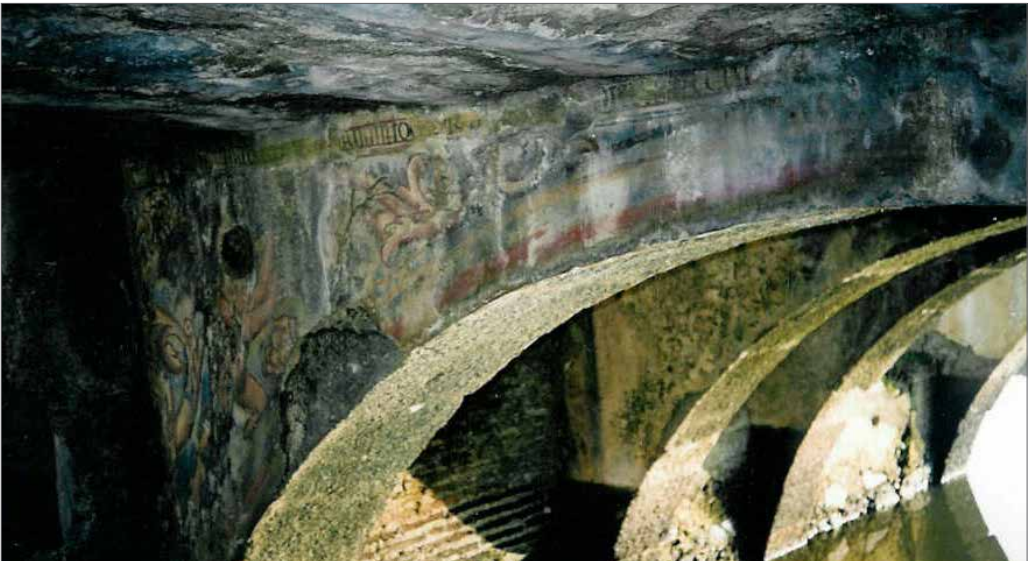
Detalle de los arcos
