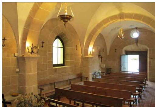
Detalle de las bóvedas de arista de la nave
