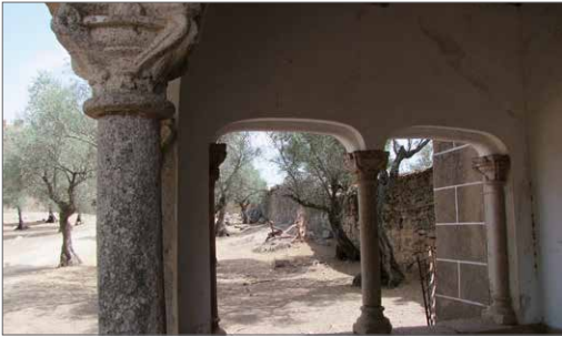
Detalles del pórtico
