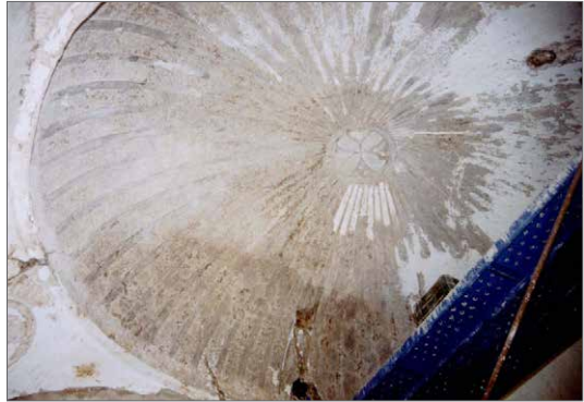
Cúpula que corona el Altar, antes de su restauración
