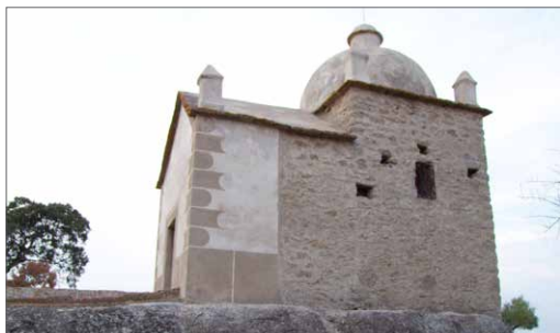
Detalle exterior, con la airosa cúpula
