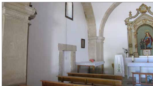
Arcos de medio punto en la nave, descansando sobre pilares adosados
