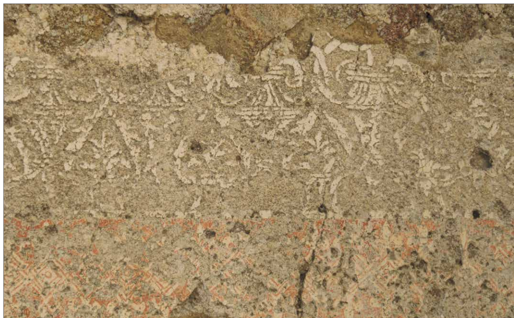
Esgrafiados en el muro de la fachada principal
