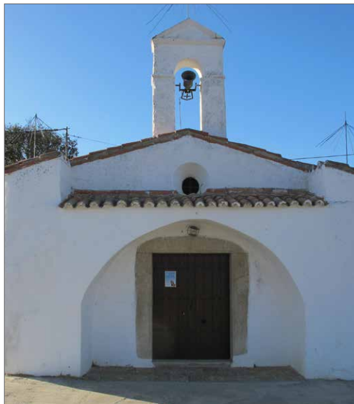
Pórtico de acceso y fachada principal
