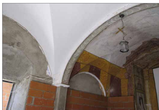
Detalle de las obras de restauración que se están llevando a cabo (2012)
