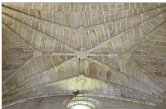
Detalle de la bóveda de terceletes que cubre la nave
