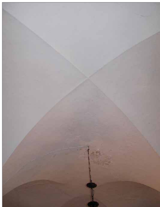
Bóvedas de aristas
