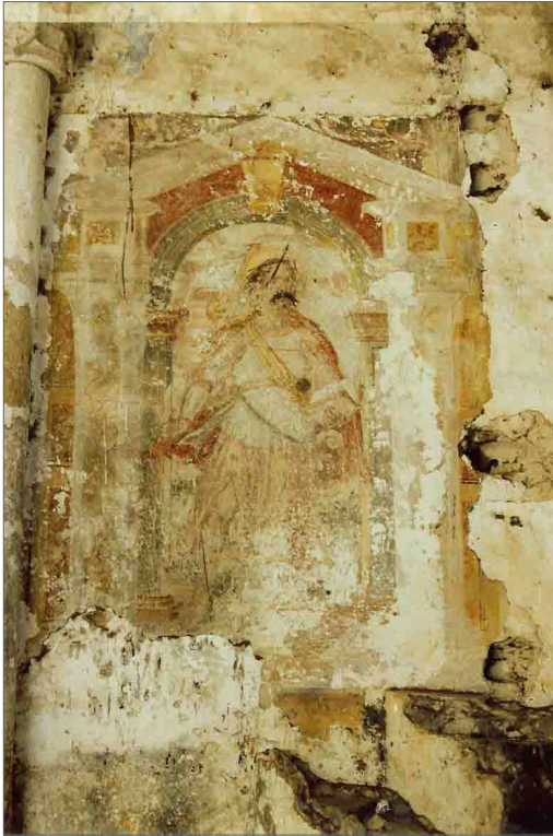
Ascensión del Señor; antes de su restauración
