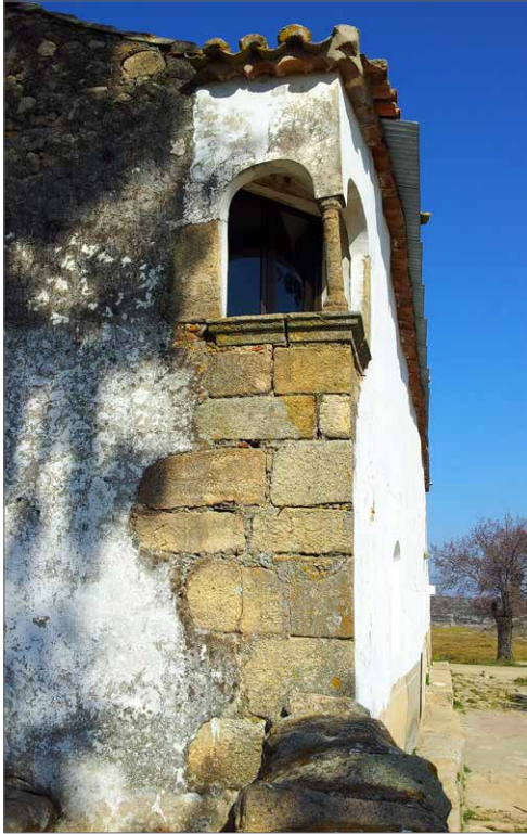
Detalle de la Hospedería, ventana esquinada, germinada por una columnita de granito de traza gótica
