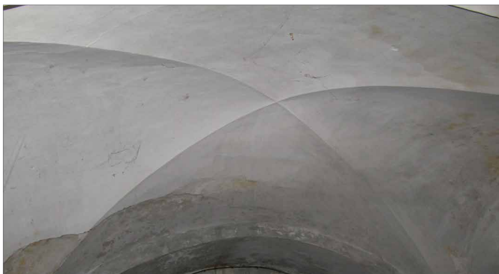
Bóveda de aristas, Capilla de San Miguel
