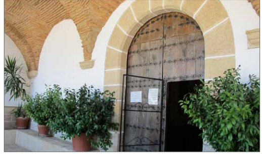
Portada de acceso al interior
