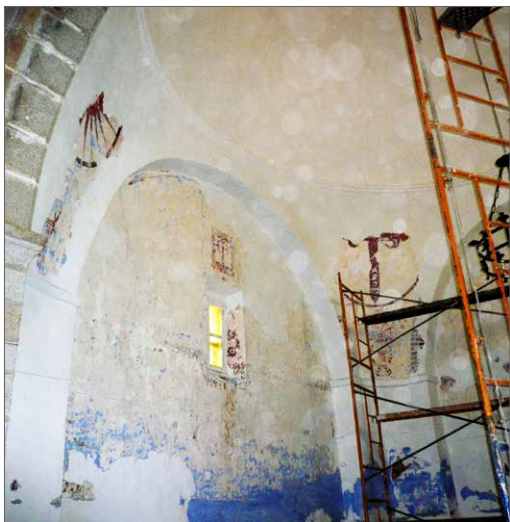
Momento de la restauración, 2008
