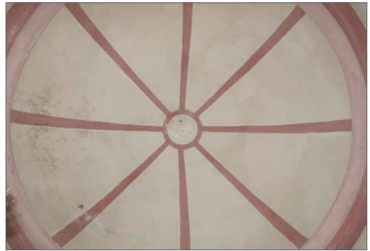
Bóveda de media naranja sobre pechinas, decorada con nervios de estuco, obra del siglo XVIII
