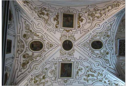
Detalle de la bóveda de la nave
