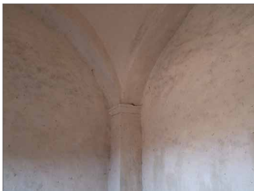
Detalle de uno de los arcos sobre los que se alzan pechinas que sirven de base a una cúpula de media naranja
