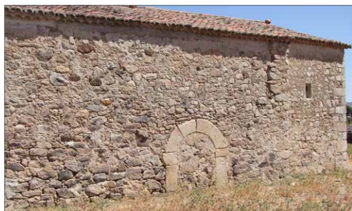
Portada cegada en el lado Sur
