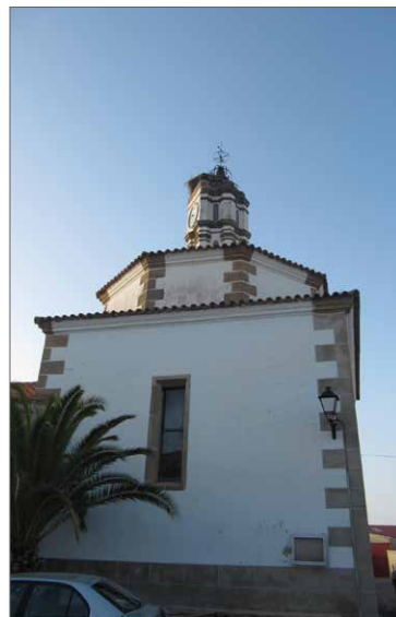
Detalle exterior de la cabecera cubierta con cúpula sobre pechinas
