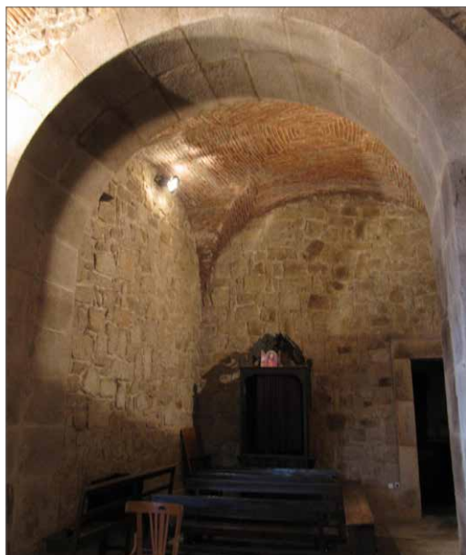
Acceso a la sacristía
