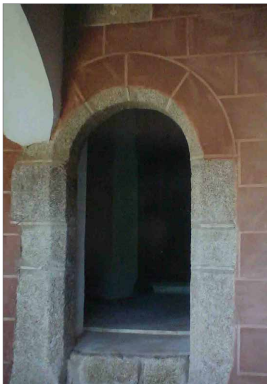
Acceso al interior, restaurado
