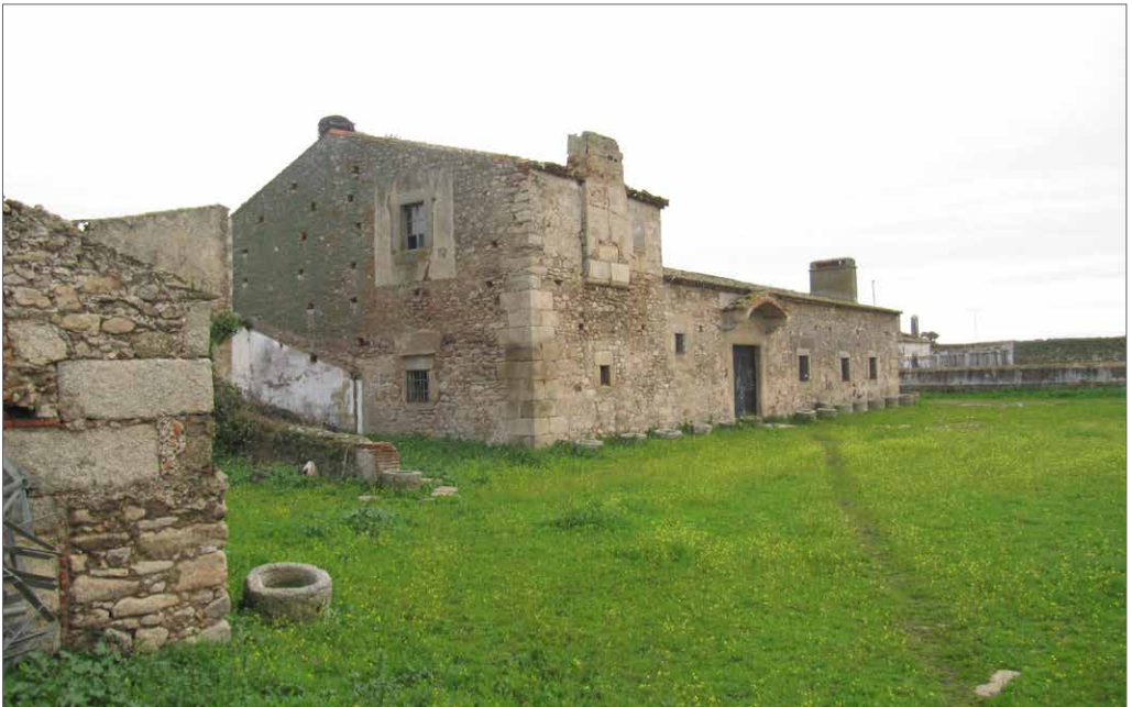
Lavadero de San Miguel en Arroyo de la Luz
