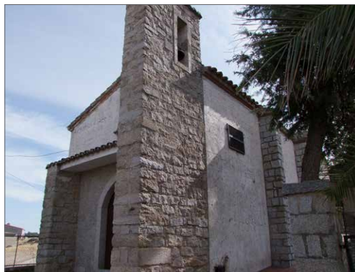
Fachada lateral y campanario
