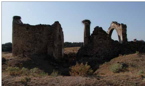
Deplorable estado de conservación de la ermita
