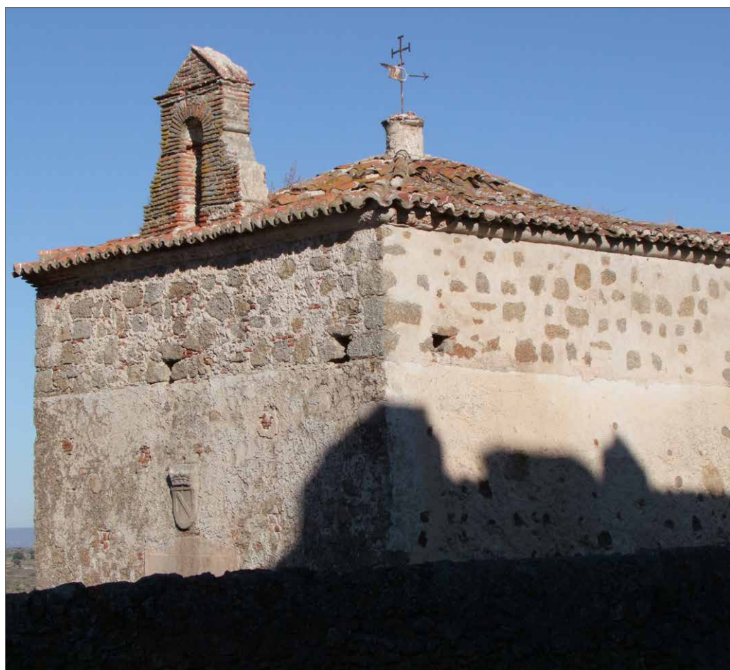
Detalle exterior de la cúpula de media naranja
