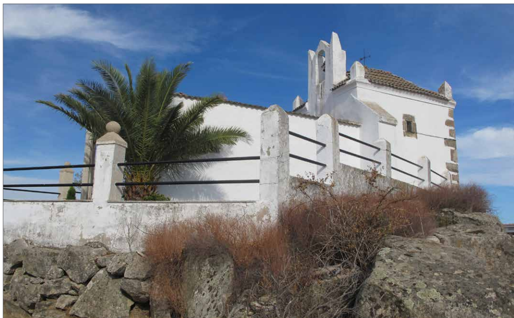
Vista panorámica de la ermita
