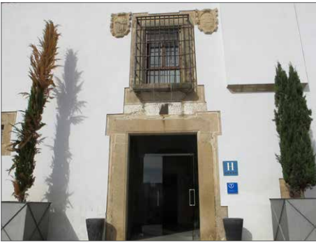
Portada de acceso al interior de la Casa
