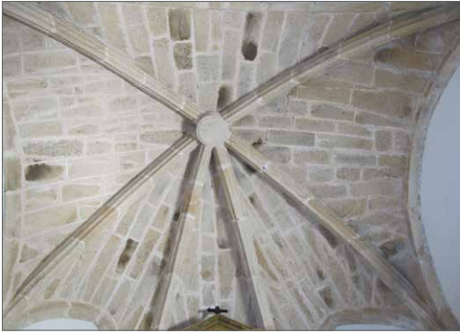
Cabecera cubierta con bóveda ojival estrellada sobre mensulas
