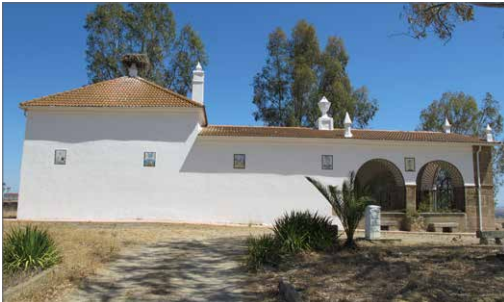
Vista fachada lateral de la ermita
