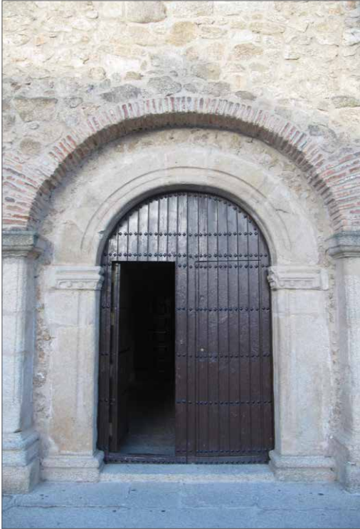
Puerta de acceso al pórtico, arco de medio punto de los años finales del siglo XV
