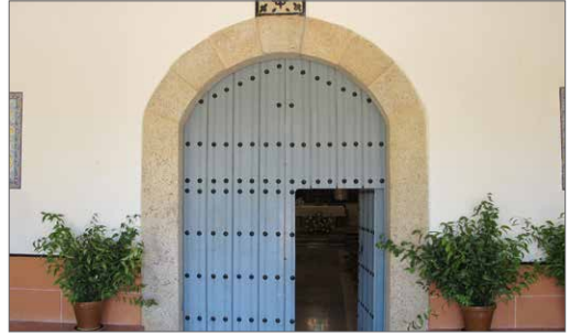
Puerta de acceso a la ermita
