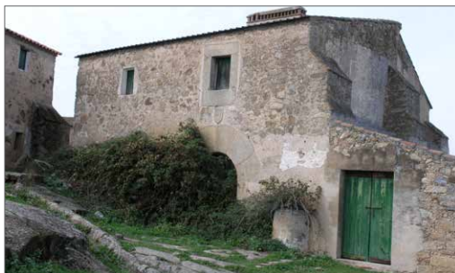
Casa Fuerte del siglo XV, en la heredad de Zamarrillas
