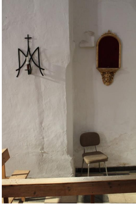
Fig. 23: Pilar de fuste biselado de la fase mudéjar.
