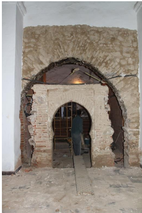
Fig. 24: Puerta con arco tumido apuntado enmarcado en alfiz de la fase mudéjar.
