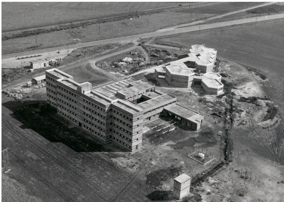
Fotografía aérea de las primeras edificaciones. (c.a. 1969)
