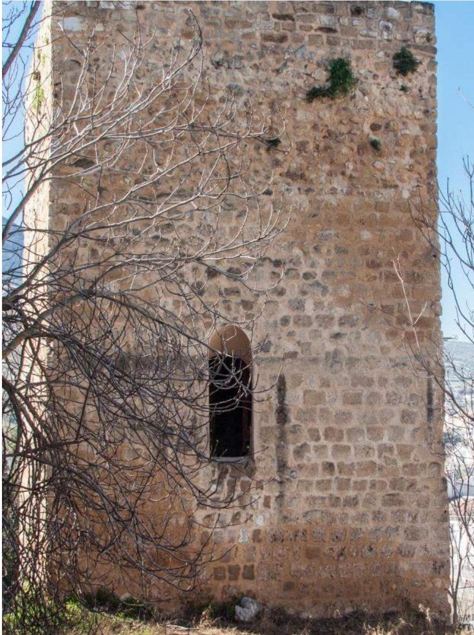
Torre del Batán (Castillo de Locubín).
