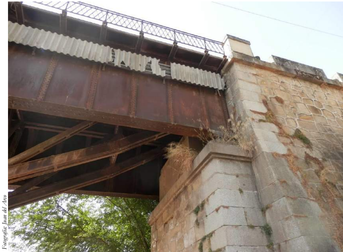
Estribo derecho (detalle)
