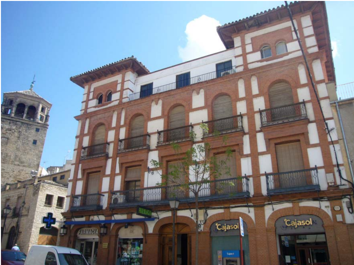
Calle Rastro nº 1
