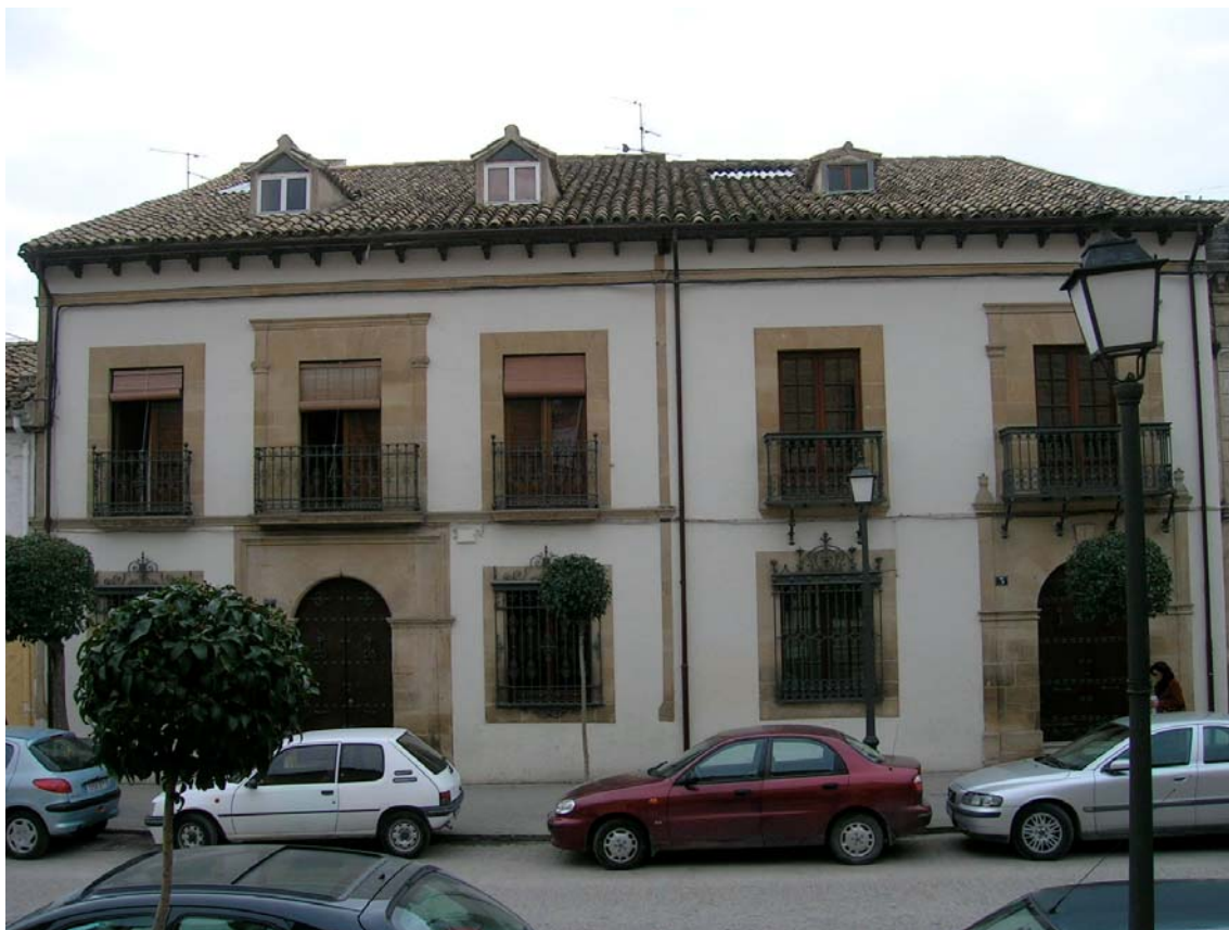
Avenida Cristo Rey, nº 1 y nº 3
