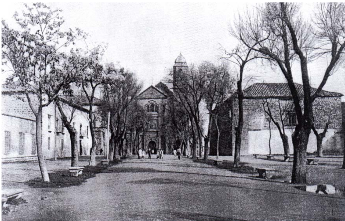
Paseo de las Delicias (hacia 1920). A la derecha el edificio de la Cárcel, antes de añadirle la portada lateral y abrir las ventanas
