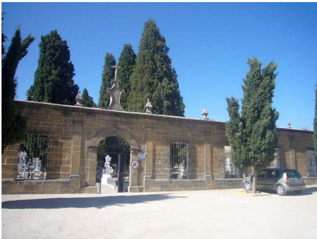
Fachada principal del Cementerio de San Ginés
