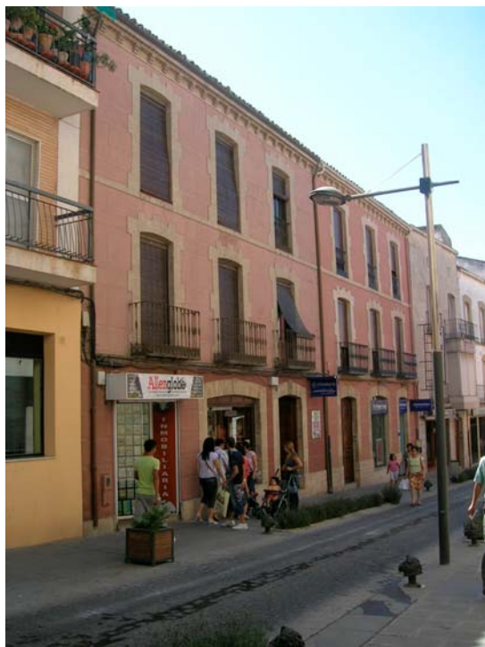
Calle Trinidad nº 22
