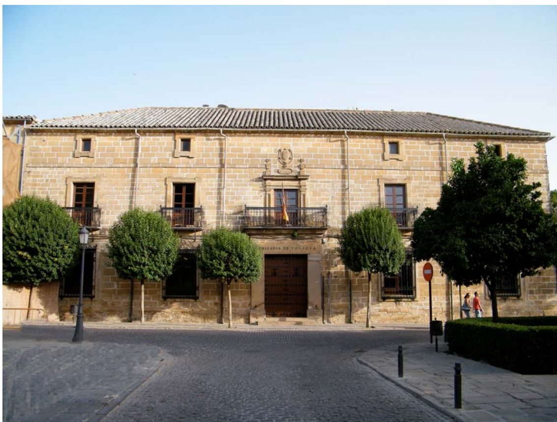
El Pósito ó la antigua Cárcel
