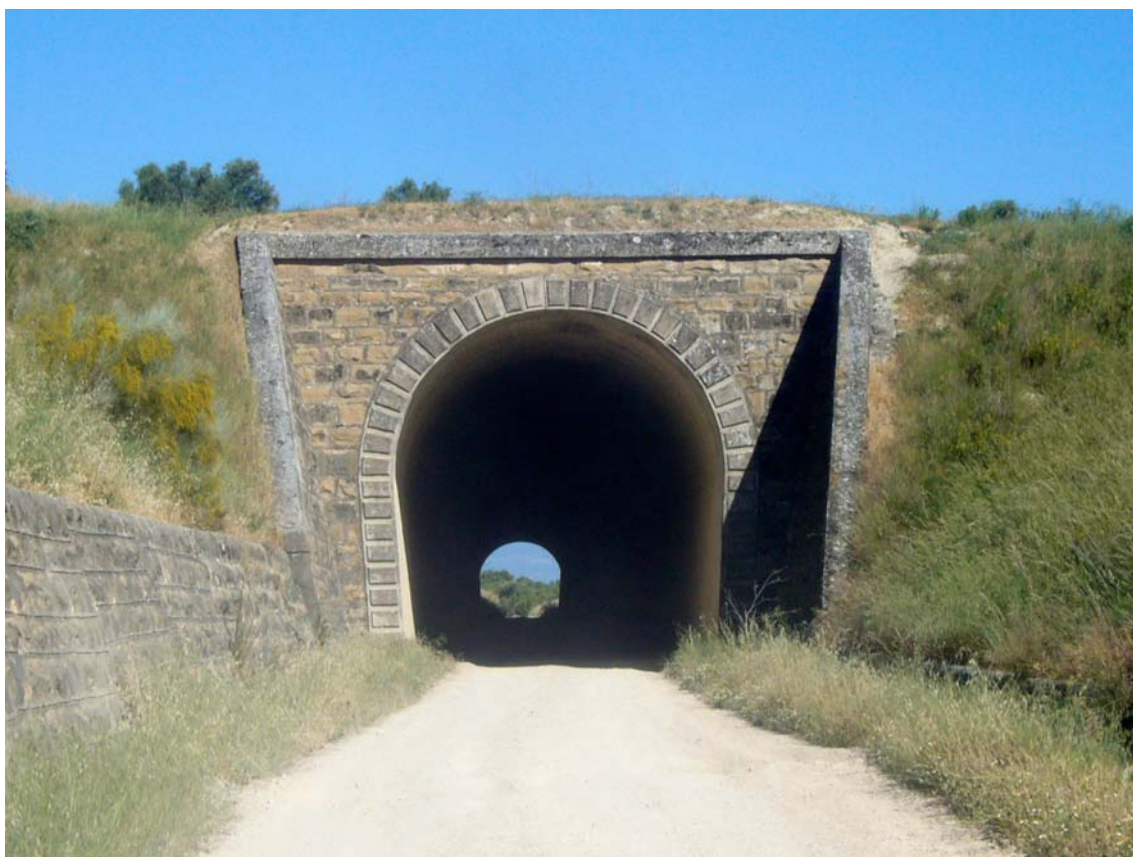
Tunel de la Línea Baeza-Utiel
