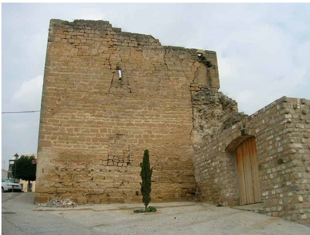
Torreón de la Cava
