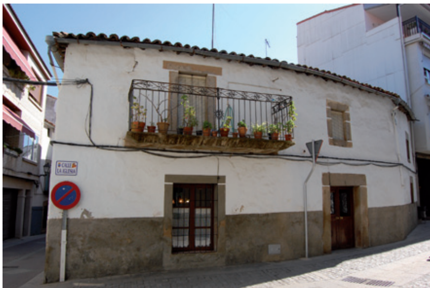
▲ Montehermoso (Cáceres). En las fachadas enfoscadas se combinan sencillas balconadas y vanos con recerco de granito.
