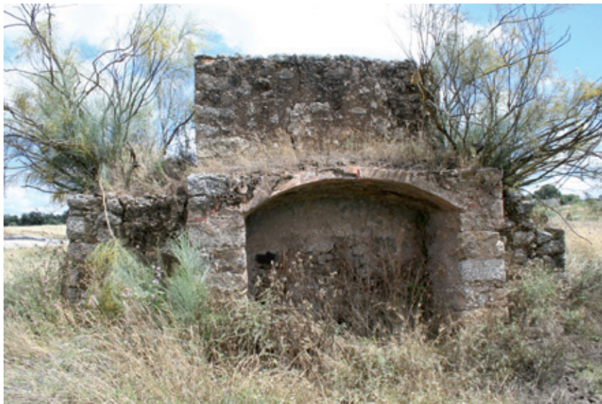
▲ Brozas (Cáceres) . Horno para la fabricación de tejas ubicado en las cercanías de la charca que bordea la localidad.
