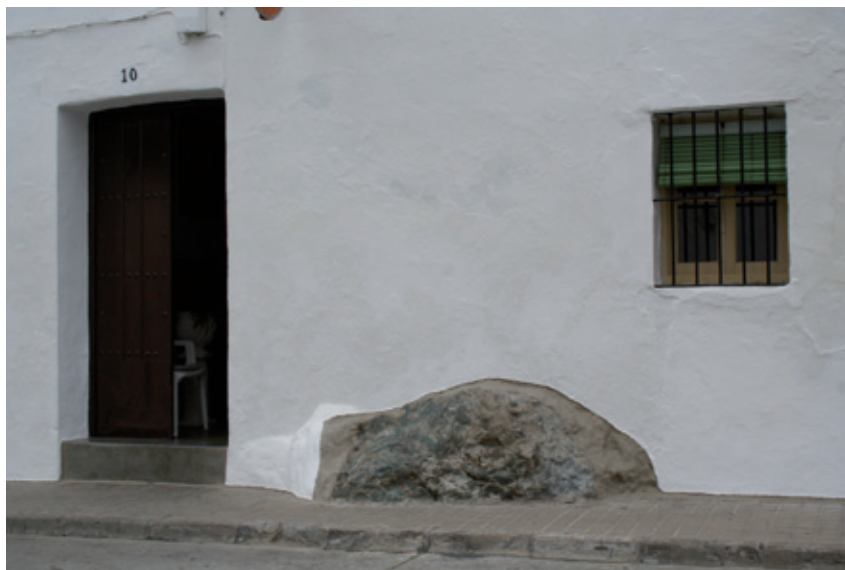
▲ Fregenal de La Sierra (Badajoz) . Adaptación al medio físico como elemento distintivo de la arquitectura tradicional. El blanqueado de la fachada separa con cuidadosa nitidez la roca del sustrato.
