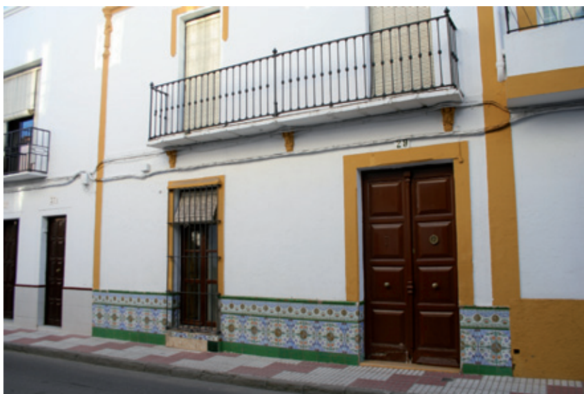
▲ Calamonte (Badajoz). El gusto por la ornamentación en zócalos está extendido en la Baja Extremadura.
