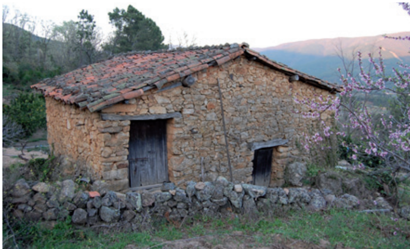
▲ Cadalso (Cáceres). Casa de huerta. La huerta es una explotación de suma importancia en la Extremadura septentrional y minifundista. Las casas de hortelano componen un sencillo esquema de planta rectangular, tejado a dos aguas y mampostería vista.
