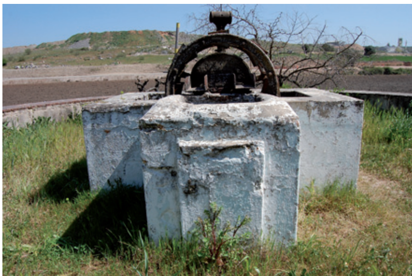
▲ La Garrovilla (Badajoz). Noria en explotación hortícola. El agua es un bien escaso en buena parte de la región. En el contexto temporal de la agricultura tradicional, los ingenios destinados a la extracción de la misma tenían suma importancia estratégica.
