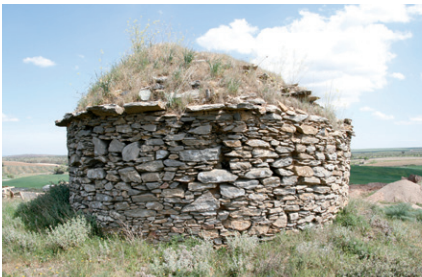
▲ Villagarcía de La Torre (Badajoz) . Chozo levantado en piedra en seco.
