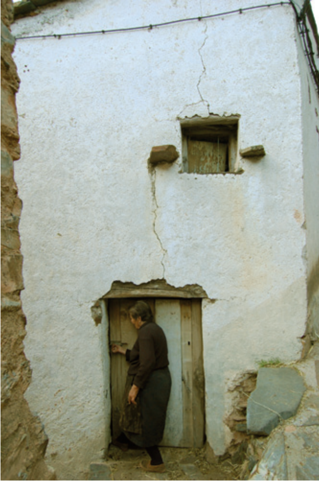
▲ Nuñomoral (Cáceres). Vivienda de pequeños propietarios. El enfoscado mediante cal y el acondicionamiento de sencillas ménsulas en los pequeños vanos de la fachada rompen en algunos casos con la clásica construcción de pizarra vista propia de Las Hurdes.
