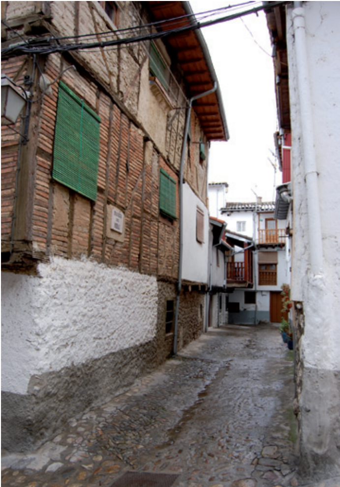
▲ Hervás (Cáceres). El entramado se levanta reforzando el conjunto con ladrillo.
