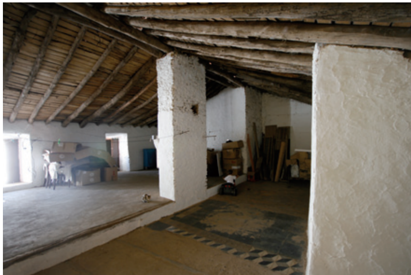
▲ Segura de León (Badajoz). Doblao en vivienda de labradores. La segunda planta de la casa se habilita en la Baja Extremadura como espacio dedicado a almacenaje de productos y aperos agrícolas. Hoy día, las nuevas formas de vida hacen que dicho emplazamiento se reoriente, generalmente, como mero espacio de desahogo.
