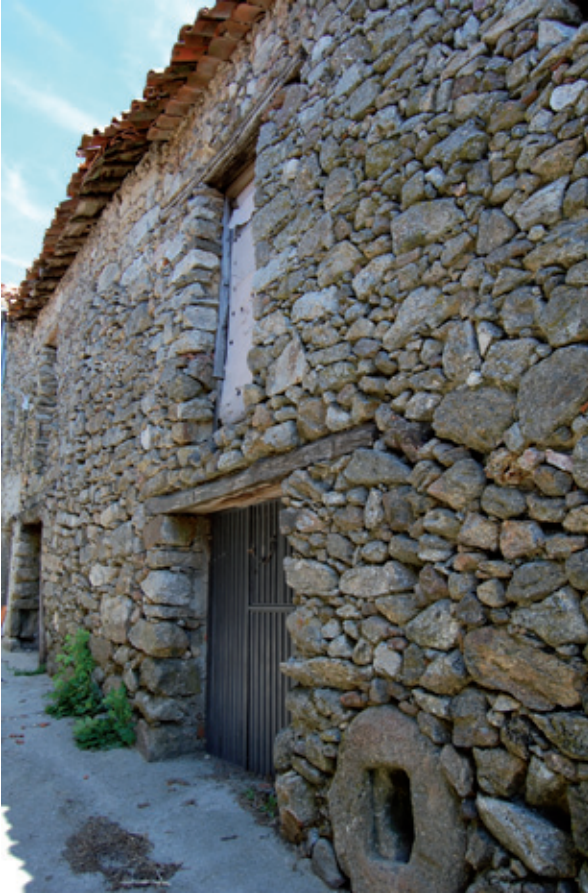
▲ Piornal (Cáceres) . Mampostería con ripio y sencillo dintel de madera en una vivienda adaptada a las condiciones de vida serranas.
