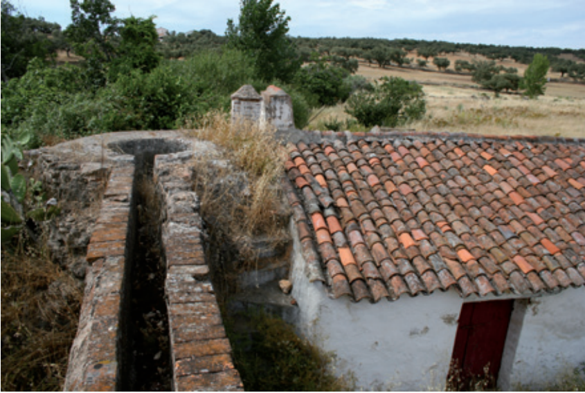
▲ Fregenal de La Sierra (Badajoz) . Molino harinero; vista de canal y cubo y casilla donde se ubican ingenios de molinero.
