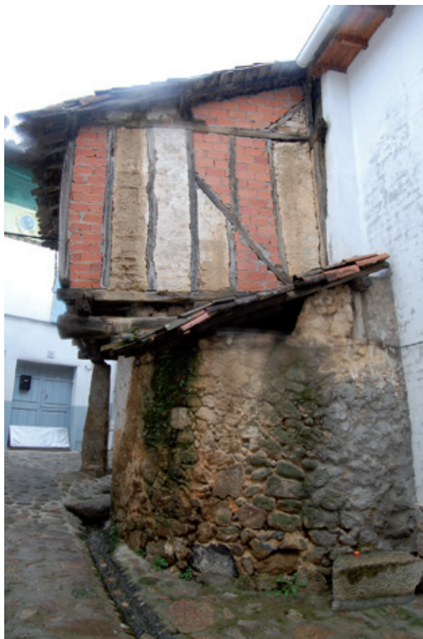
▲ Valverde de La Vera (Cáceres). El entramado de madera se adapta a remodelaciones posteriores de la vivienda.
