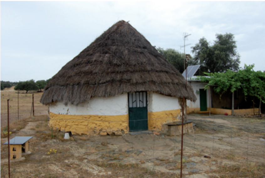
▲ Alburquerque (Badajoz). Chozo con enfoscado y cubierta reforzada con elementos vegetales.
