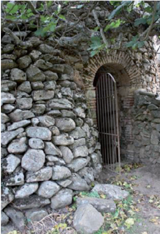
▲ Calera de León (Badajoz). Técnica de la piedra en seco en construcción que alberga noria para riego de huerta y para surtir de agua a cocedero y alberca de endulzado de altramuces.
