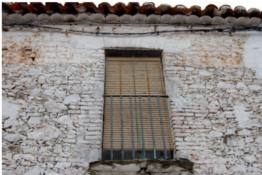
▲Alía (Cáceres). Mampostería con lechada de cal en vivienda de pequeños propietarios.
