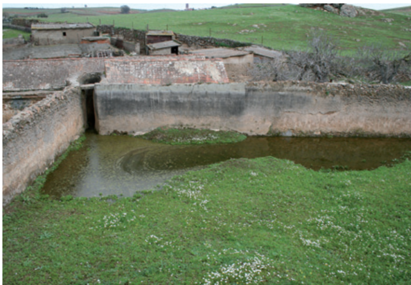
▲ Zafra (Badajoz) . Embalse o aljibe de molino harinero para el almacenaje del agua destinada a mover el dispositivo de molienda.
