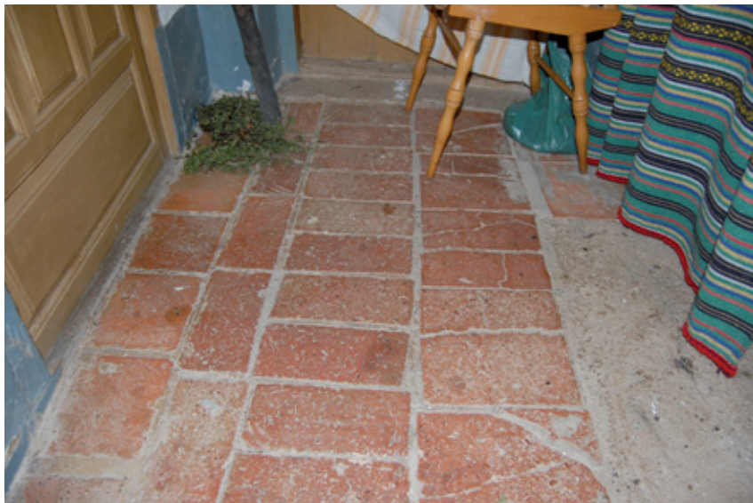
▲ Alía (Cáceres). Suelos de losetas de barro en vivienda de pequeños propietarios.
