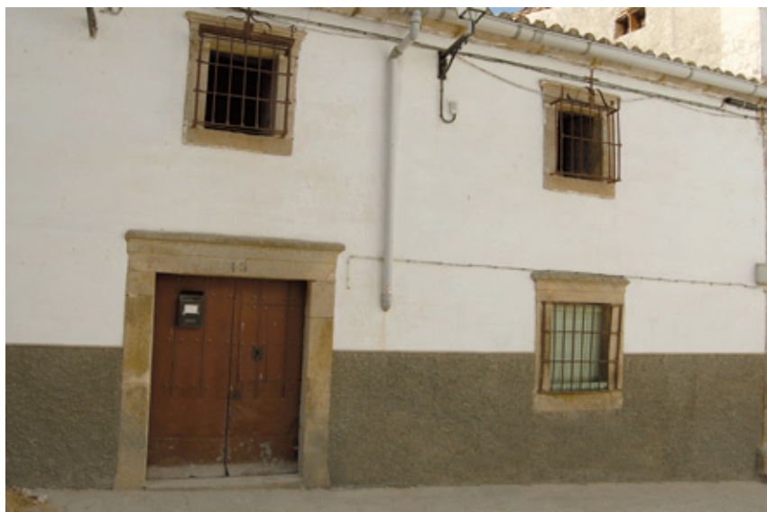
▲Montánchez (Cáceres). Fachada con zócalo y recercos de granito en vanos.
