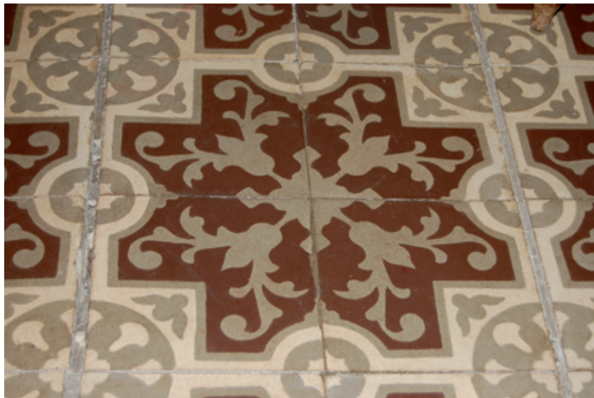
▲ Guadalupe (Cáceres). Los suelos de losetas hidráulicas son un elemento común en la arquitectura vernácula extremeña.
