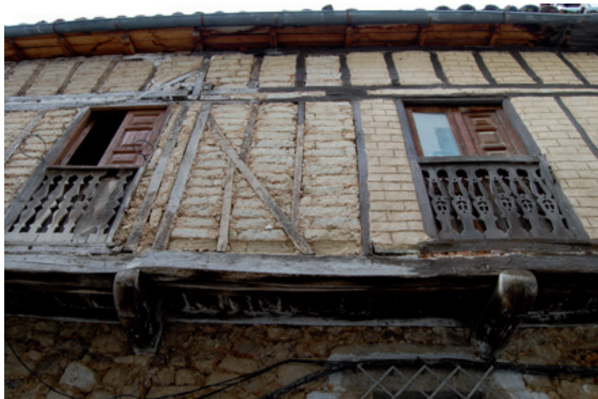
▲ Losar de La Vera (Cáceres). Técnica del entramado de madera, definidora de la arquitectura serrana del norte extremeño y elemento diferenciador en relación a los territorios que se extienden al sur del arco septentrional.
