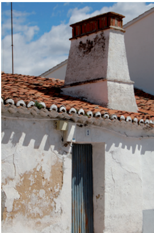
▲ Casatejada (Cáceres) . Grandes chimeneas y fachadas en-caladas conectan parte de la arquitectura habitacional del Campo Arañuelo con modelos más meridionales.
