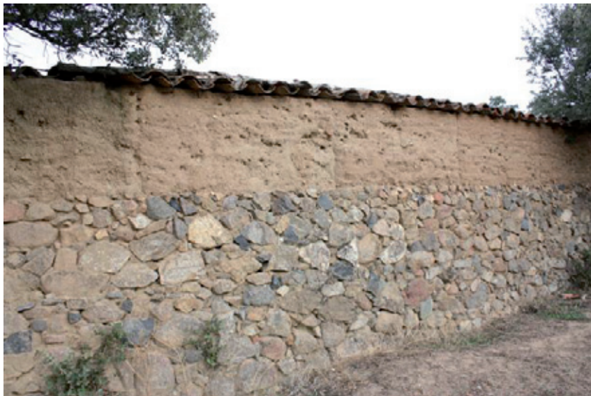
▲ Calera de León (Badajoz). Alternancia, en muro perimetral de huerta de mampostería y tapial, dos técnicas arquitectónicas frecuentes en buena parte del territorio extremeño.
