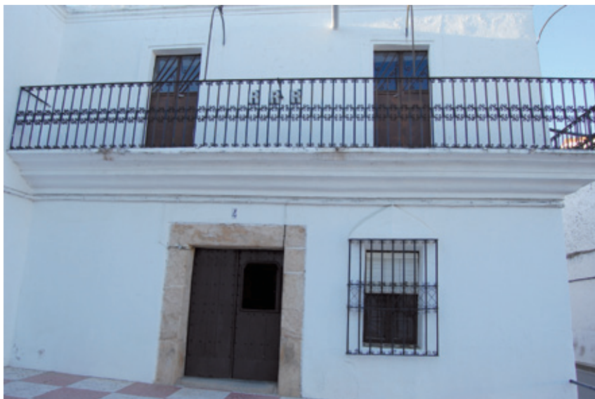
▲ Acehúche (Cáceres) . Sencillas portadas de cantería, rejería con sobria ornamentación y balconadas en viviendas acomodadas. Aún es relativamente común dedicar la segunda planta a espacio vividero, al contrario que en la Baja Extremadura.
