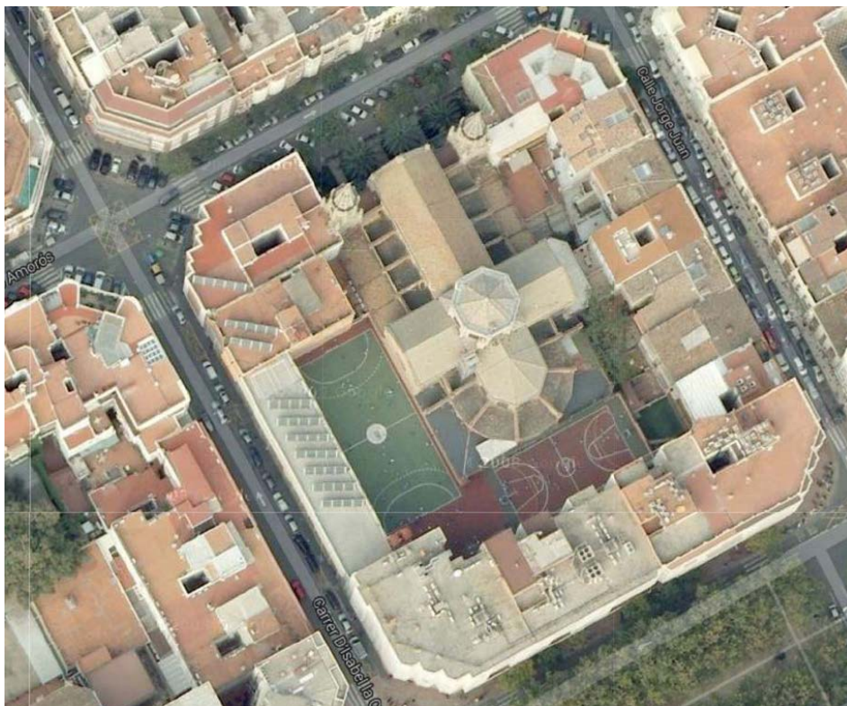
Figura 5.2: Fotografía aérea del edificio. Fuente elaboración propia
