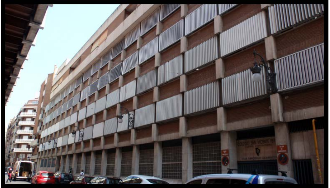
Figura 5.3: Fotografía fachada principal del edificio. Fuente elaboración propia
