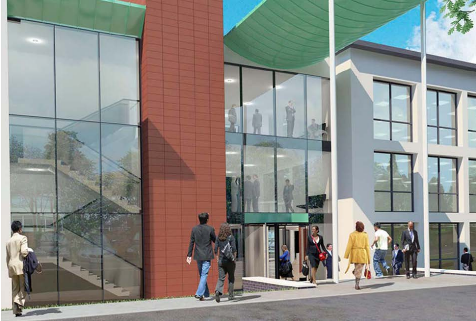
Figura 1.3: Hagley Rd. 138 Fachada principal. Fuente: (Miguel Falomir 3d).
