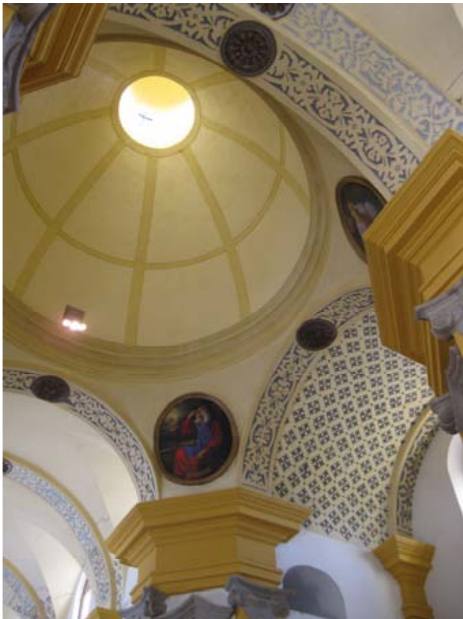
Popayán, detalle de la cupola y de una boveda del templo de San José después la obra de restauración (foto: archivo del autor)
