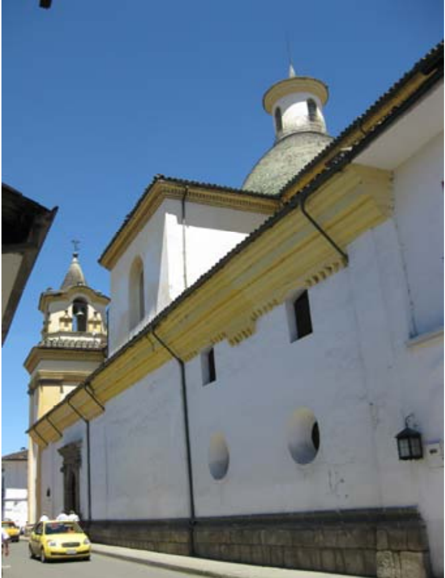
Popayán, fachada lateral del templo de San José después la obra de restauración (foto: archivo del autor)
