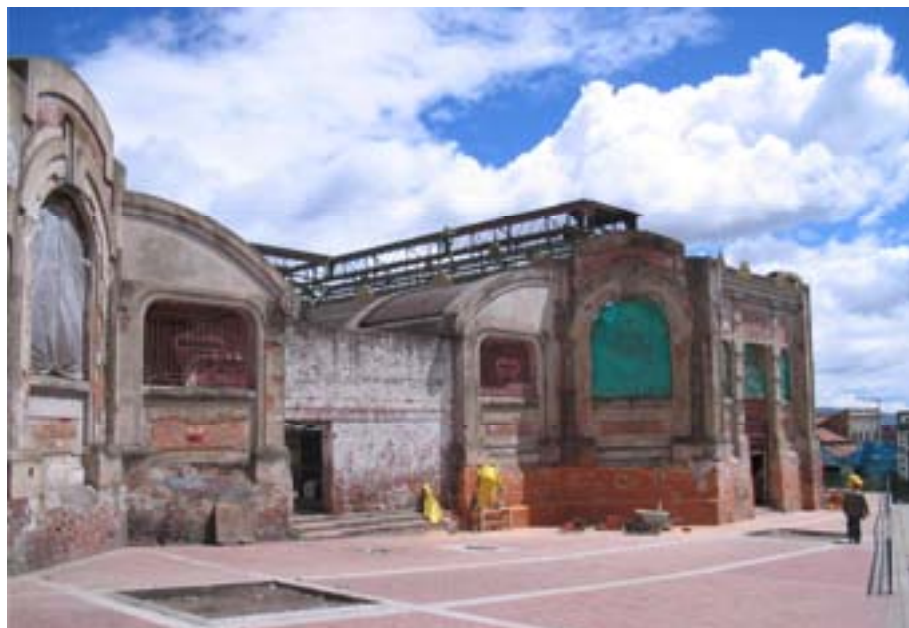
Plaza de mercado antes de la restauración (Foto: Max Ojeda Gómez)
