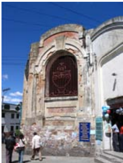
Detalle antes de la restauración. (Foto: Max Ojeda Gómez)
