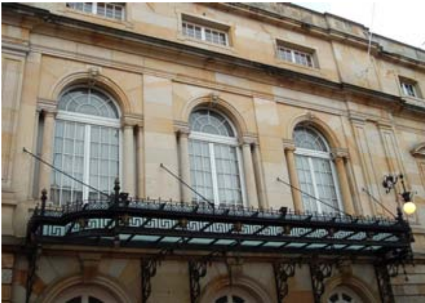
Bogotá. Detalle de la fachada principal del Teatro Colón (1885 -1892) en el barrio La Candelaria. Su construcción fue encomendada (1885) al arquitecto italiano Pietro Cantini que nació en Florencia en 1847. (foto: Olimpia Niglio, 2006).
