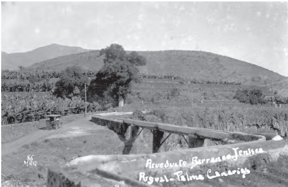
Acueducto sobre el barranco de Tenisca. Argual. Los Llanos de Aridane
