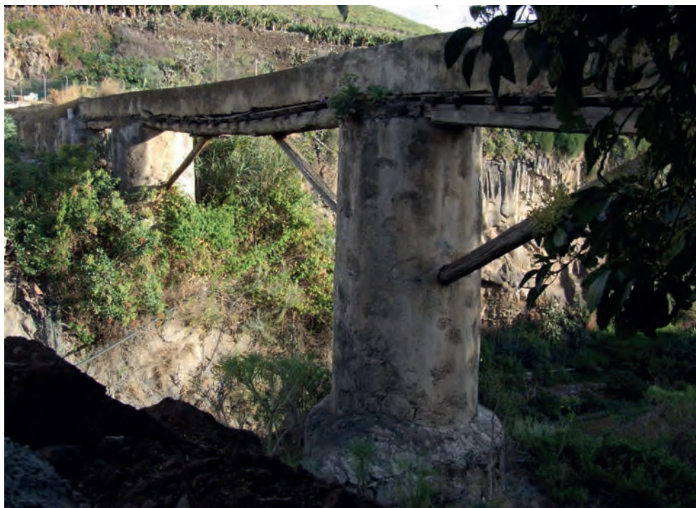
Acueducto de madera y argamasa. Barranco de Tenisca. Argual
