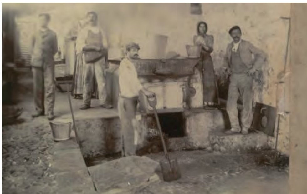
Trapiche «Dos Hermanos» durante la etapa de Joaquín Gisbert. Argual. Los Llanos de Aridane
