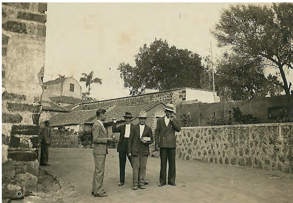
Camino de La Vica junto a la entrada al Llano de Argual. A la izquierda, esquina del edificio del antiguo ingenio
