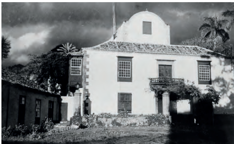
Casa Sotomayor Massieu antes de la reforma de la fachada lateral. Argual
