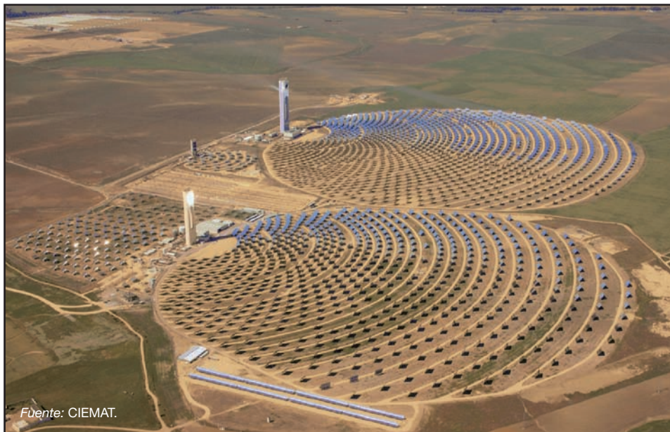
Figura 8. – Solúcar PS-10, PS-20 (Abengoa).
