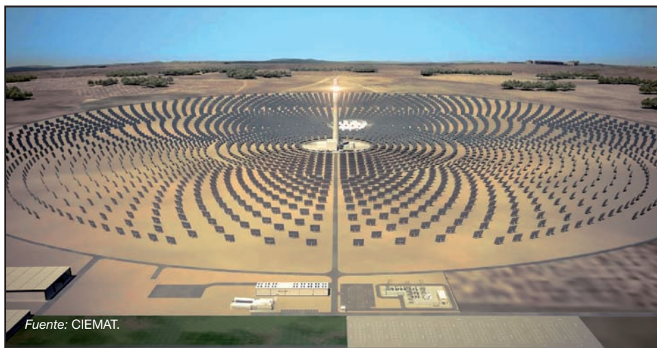
Figura 9. – Gemasolar: 17 megavatios eléctricos, receptor central y sales fundidas (como fluido portador y de almacenamiento) en Fuentes de Andalucía año 2011. 304.750 metros cuadrados de helióstatos, 15 horas de almacenamiento, promovida por Torresol Energy/SENER+MASDAR, receptor ensayado en la PSA.
