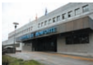
Hospital Comarcal de Monforte
