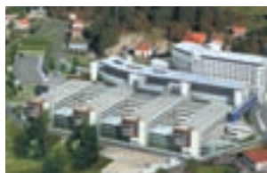
Novo Hospital de Pontevedra
