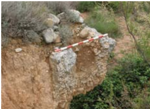
Canalización tipo del acueducto en la zona de San Pedro Mártir (término de Arnedo). Foto J.L. Cinca.
