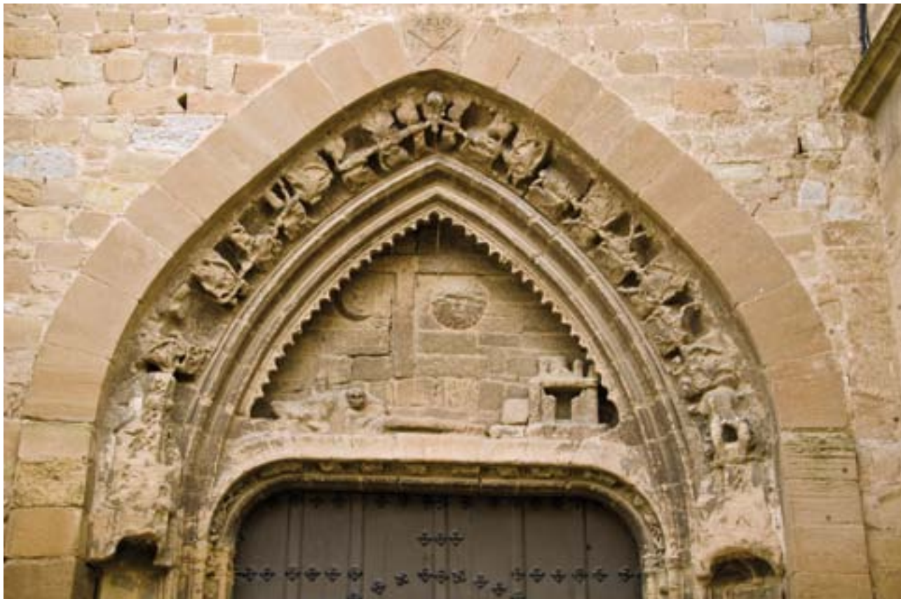
Tímpano de la fachada principal de la iglesia de San Andrés. Foto R. Muñoz.
