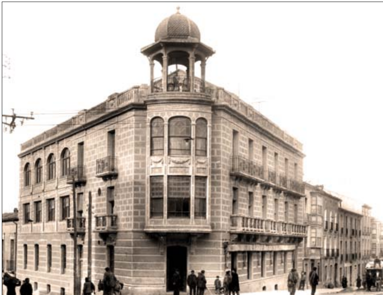
De 1922 era el edificio del Casino Principal, con un excepcional templete superior de planta hexagonal rematado en cúpula. Fue destruido en los años 70 del pasado siglo. Foto Archivo Bella.
