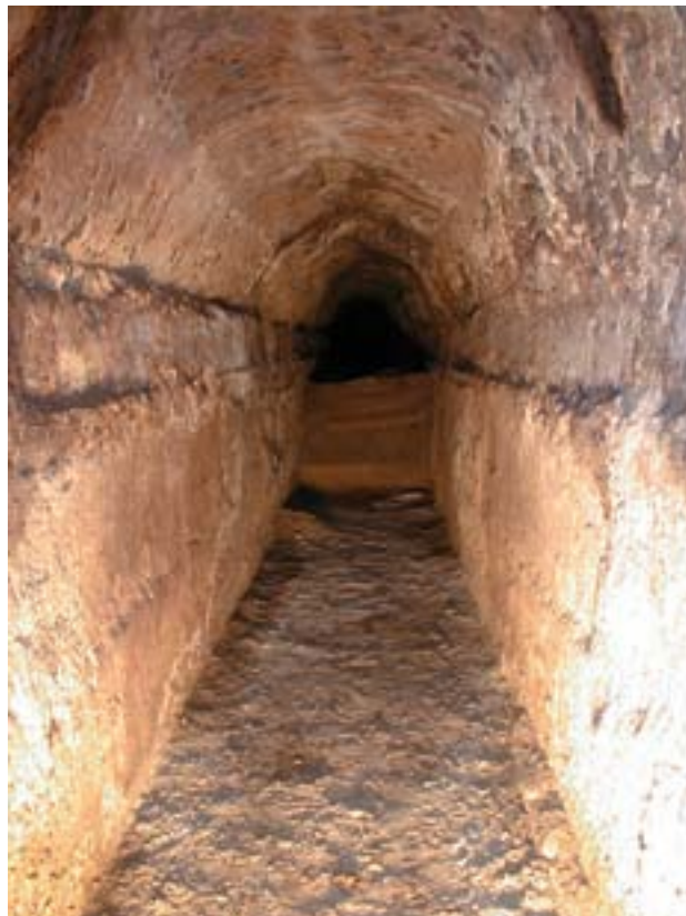
Tramo de cloaca romana en la calle San Andrés, nº 27. Foto J.L. Cinca.
