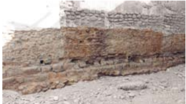
Pared del circo romano haciendo de medianería actual entre los edificios del paseo del Mercadal y la calle Teatro. Foto A. Pérez.
