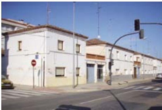
Viviendas llamadas “de los labradores” en la carretera de Arnedo, frente al actual Centro de Salud. Foto A. Pérez.
