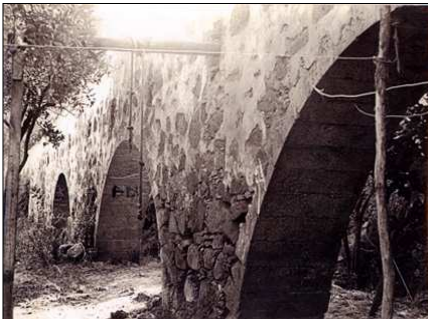
FIG. 13 Vista parcial de un antiguo acueducto localizado en el casco municipal de Vega de San Mateo Década de los años setenta del siglo XX. FUENTE: Colección privada
