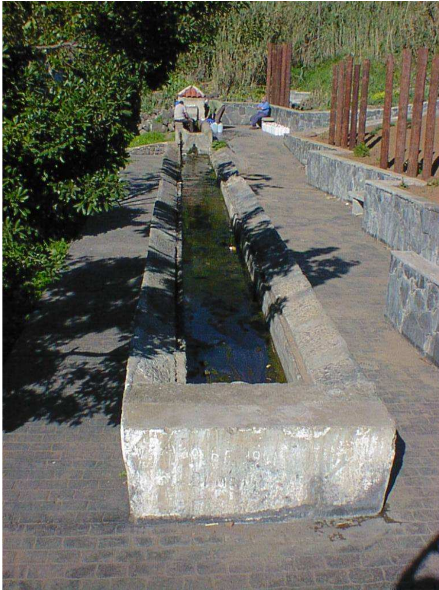
FIG. 35 Lavadero del Barranco de la Mina (Utiaca). Vega de San Mateo. 2001. FUENTE: Catálogo Arquitectónico. Vega de San Mateo.
