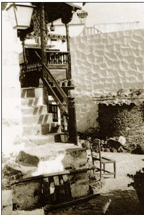
FIG. 1 Detalle de bienes patrimoniales en vivienda rural. En primer término, escalera exterior de piedra y mobiliario doméstico. En segundo término, horno de leña y balcón de madera. Vega de San Mateo (Gran Canaria). Década de los años treinta del siglo XX. FUENTE: Colección privada
