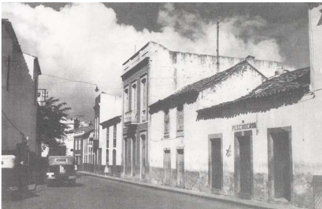
FIG. 16 En la página anterior y en la presente, conjunto de viviendas, en San Mateo, en la Calle Principal y Calle del Agua, respectivamente.
