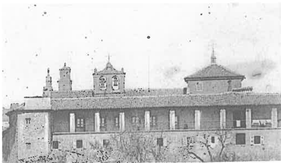
Aspecto del convento todavía con la azotea abierta al sur.
