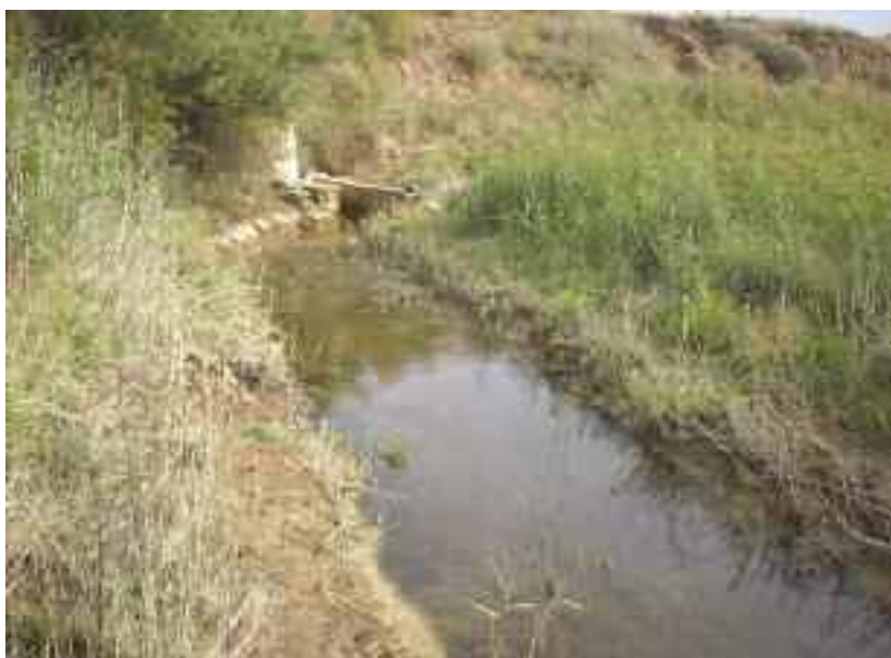
Presa de Valroyuelo en el paraje de Santa María (margen izquierda del Río Cidacos, aguas abajo). Fotografía: Arturo Pérez Fernández.
