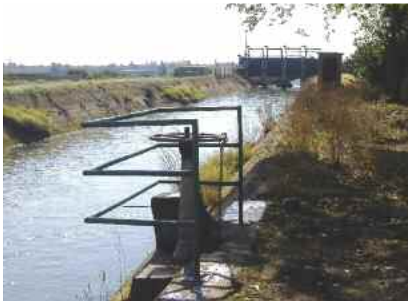
Canal de Lodosa. Toma de Melero y la Quebrada (punto kilométrico 20.400). Al fondo, las compuertas del acueducto sobre el Cidacos. Fotografía: Cristina Imaz González.
