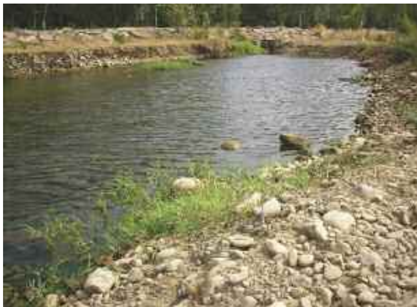
Presa de Melero, Presillas y Perenzano en el río Cidacos (margen izquierda del Río Cidacos, aguas abajo). Fotografía: Arturo Pérez Fernández.
