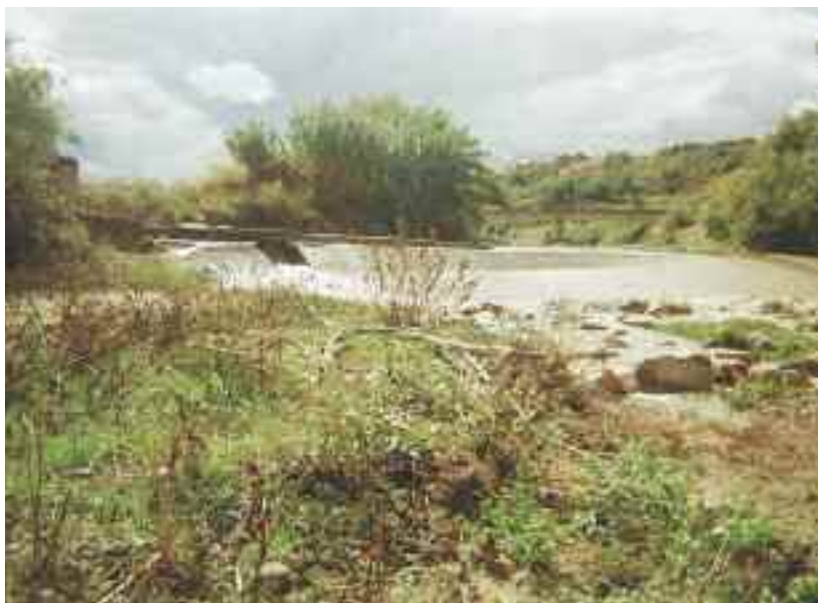
Los Molinos. Presa en el río Cidacos (margen derecha del Río Cidacos, aguas abajo). Fotografía: Roberto Martínez Gurrea.
