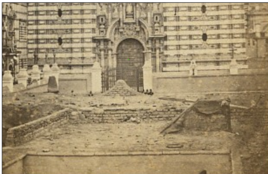
Figura 43. Obras en la plazuela en un estadio más avanzado
