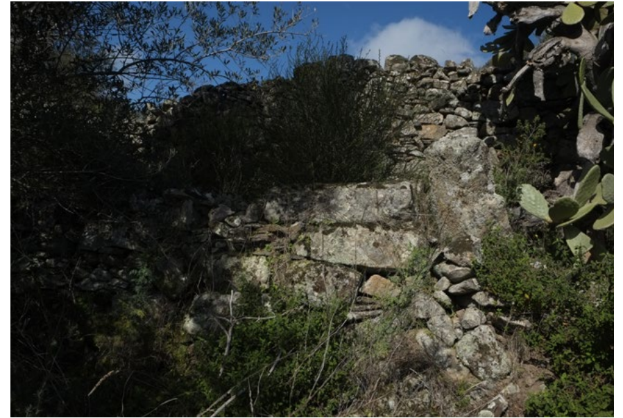
Cimentación del Bronce y muralla de la II Edad del Hierro
