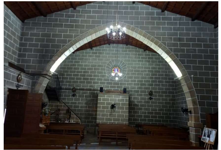
Detalle del interior
