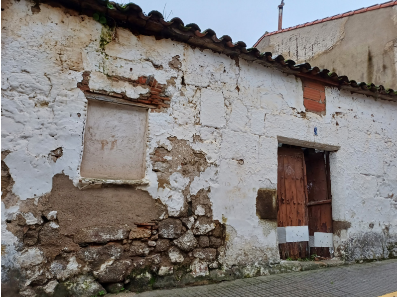
Edificación tradicional, en calle San Antonio
