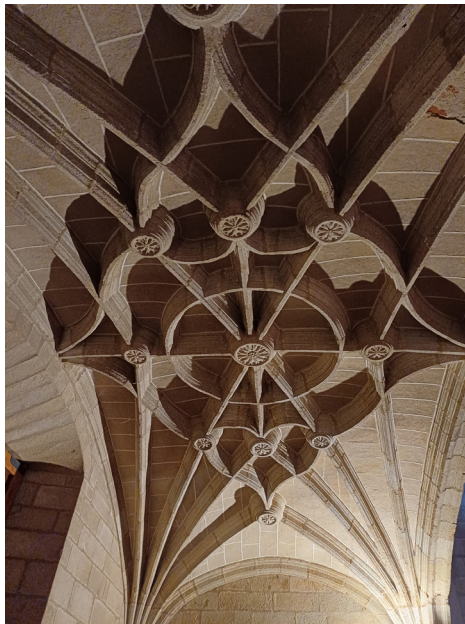
Bóveda del sotocoro
