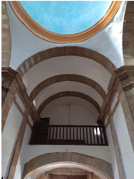
Bóveda de cañón con lunetos
