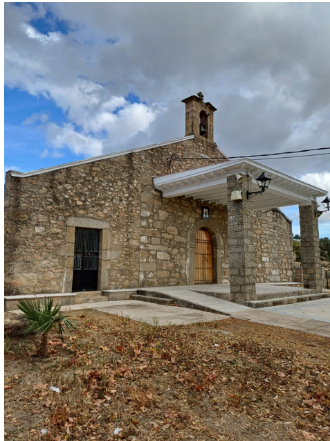
Detalle de la fachada de la ermita
