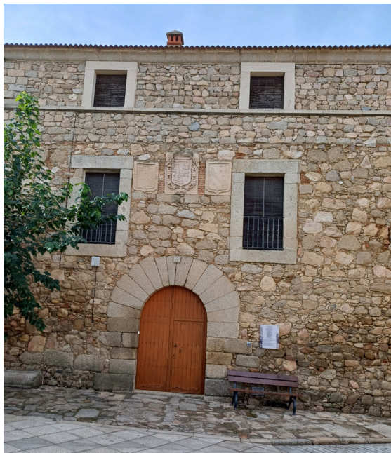
Fachada principal de la casa de la Encomienda
