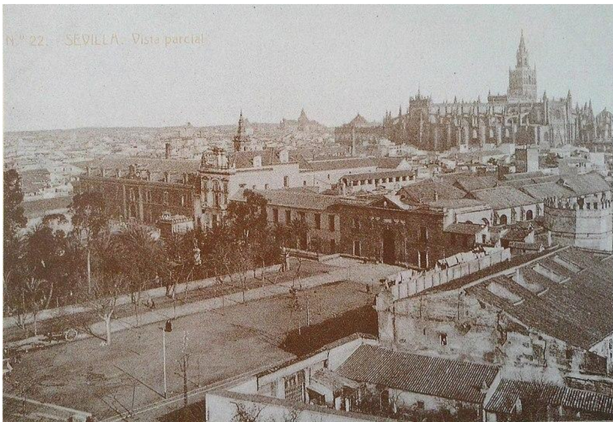
Figura 32. Anónimo, Sevilla. Vista Parcial , finales del siglo XIX-principios del XX, La Sevilla que se fue (en postales), Diario 16 Andalucía, 1992. En la fotografía se observa la fachada de la antigua Aduana que se abría al paseo del Arenal. Junto a ella, el Hospital de la Caridad y la iglesia del Señor San Jorge, las Atarazanas reales y la Torre de la Plata. Actualmente el solar de la Aduana está ocupado por la Delegación de Hacienda de Sevilla.
