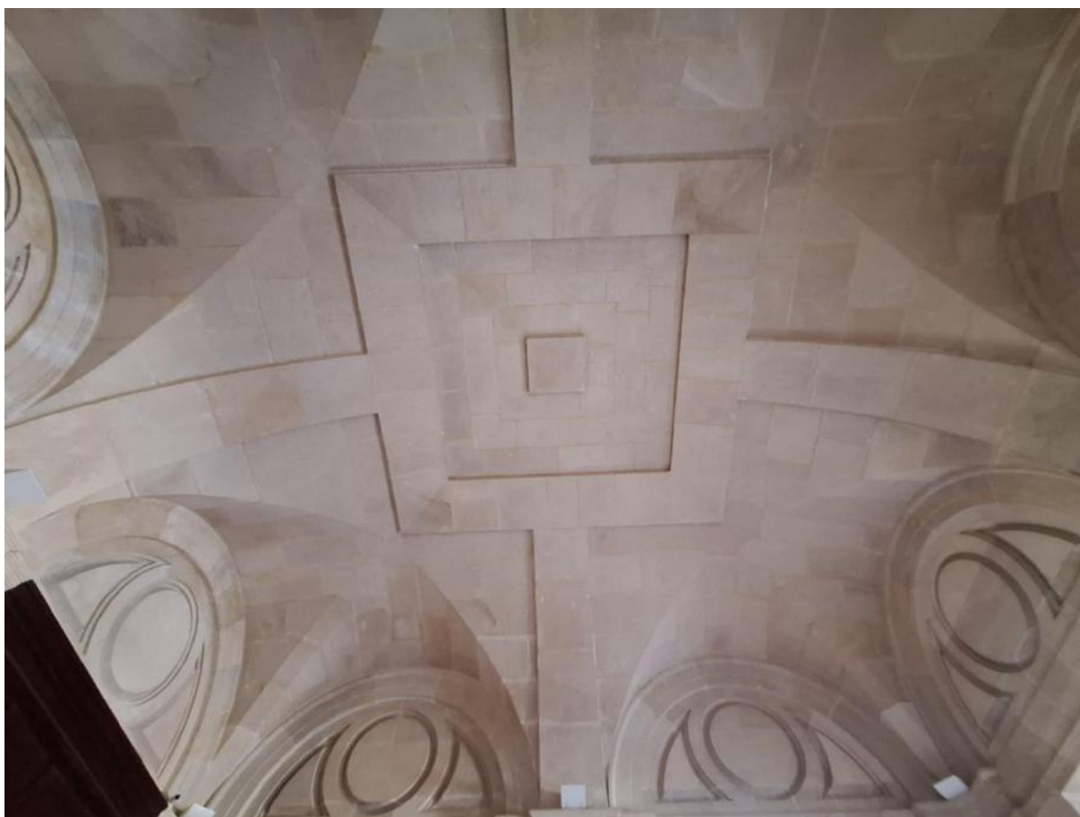
Figura 42. Bóveda de una sala angular, Casa Lonja de Sevilla. Foto autor.
