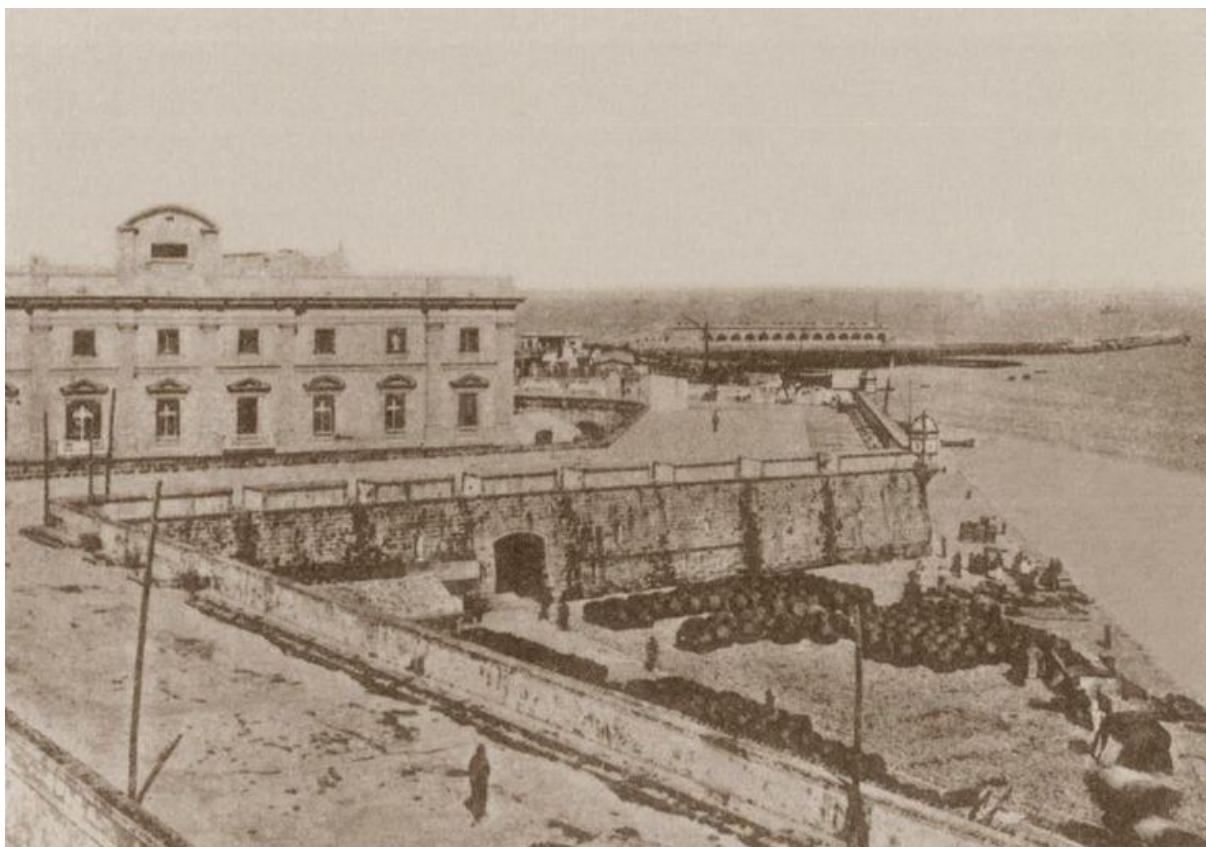
Figura 3. Anónimo, Vista del antiguo edificio del Consulado de Cádiz (después Aduana) junto a las murallas del muelle, 1905. Fuente: Portal web “Historia de Cádiz”.
