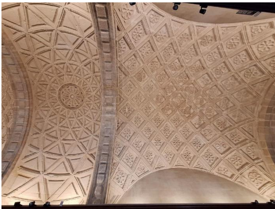
Figura 13. Miguel de Zumárraga, Bóvedas del piso superior de la Casa Lonja , 1610-1613. Foto autor.
