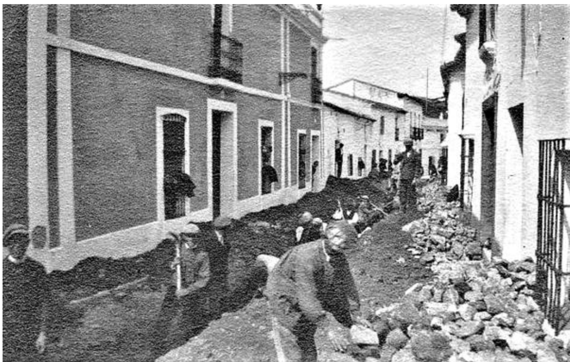
Obras en calle Sevilla (1928). 25
