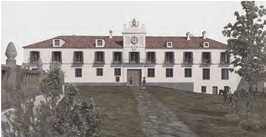
Fachada principal del edificio de la Escuela de Veterinaria desde el acceso principal de paseo de Recoletos. Autoría: P + S Estudio de Arquitectura, 2023.
