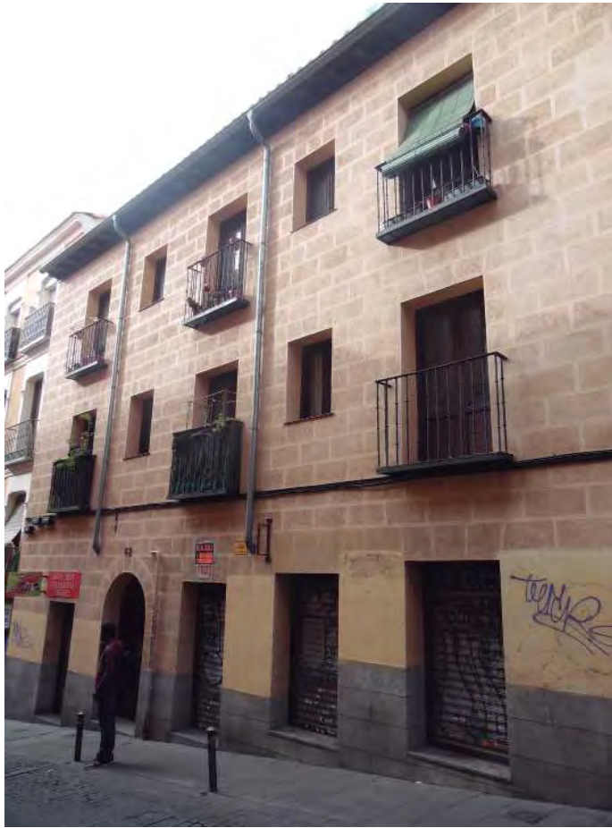
Ilustración 15. Fachada conservada en c/ Amparo 62 (González-Redondo, E.).
