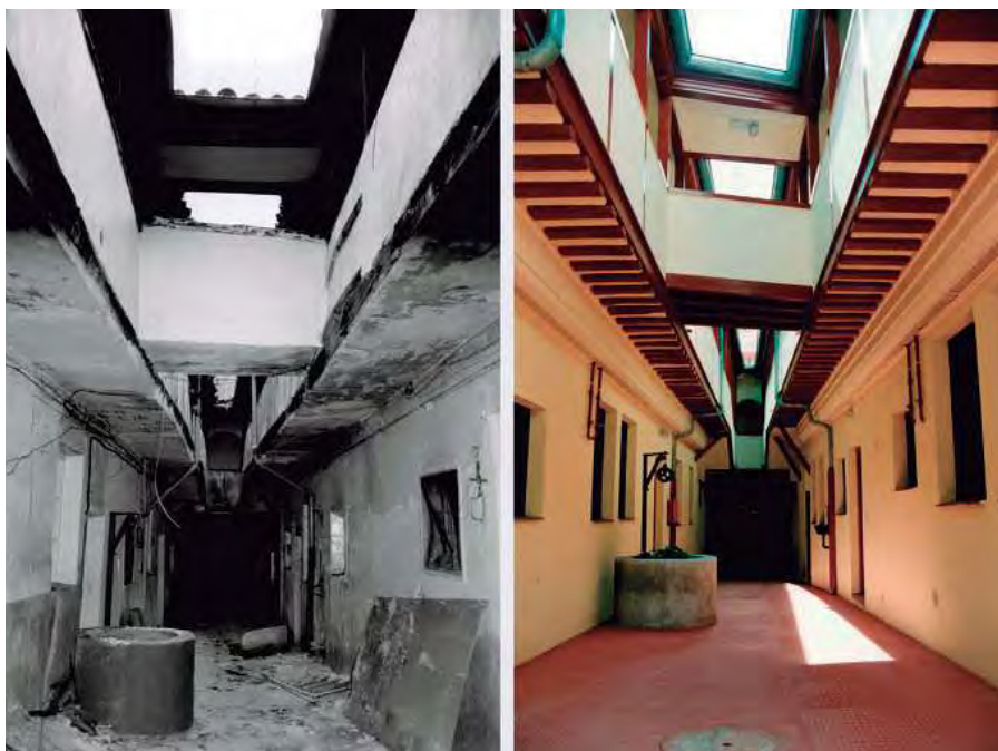
Ilustración 8. Casa de vecinos en c/ Provisiones 12 (Rehabilitación EMVS, 2006).
