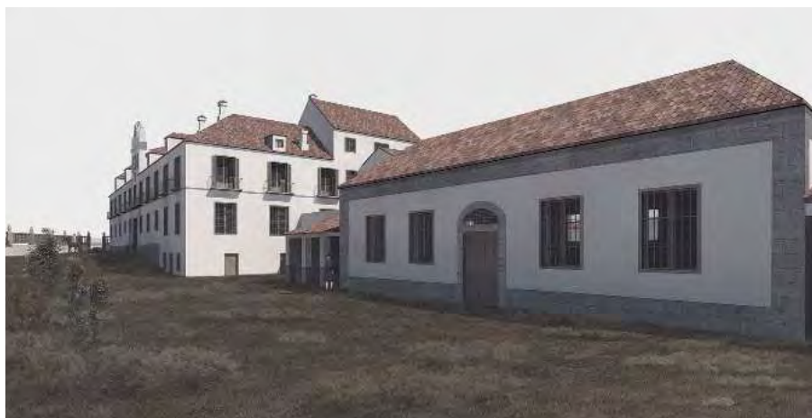
Vista oblicua desde paseo de Recoletos, en la que se puede apreciar en primer plano el herradero y también la variable topografía del terreno.
