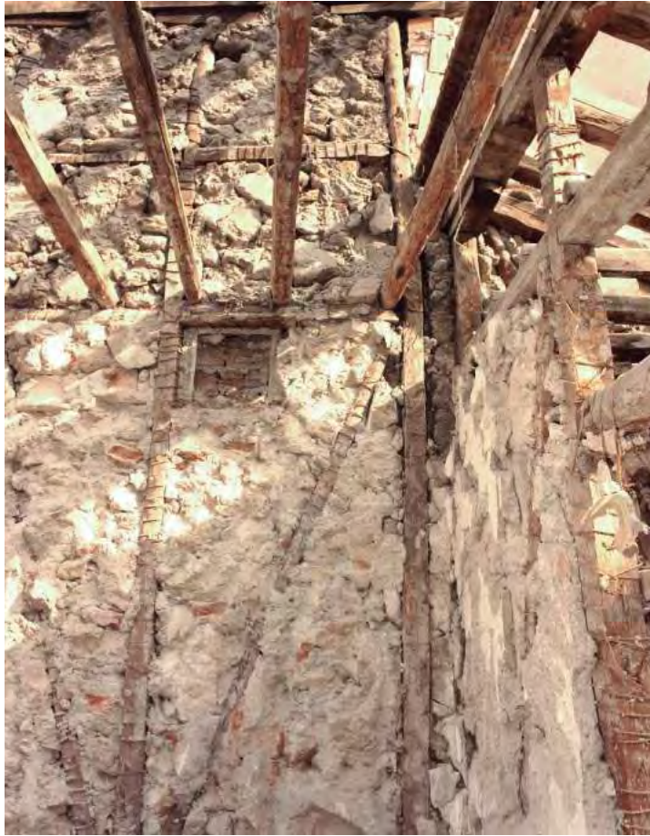
Ilustración 4. Entramados de madera en c/ Tribulete, 11 (EMVS, 2006).
