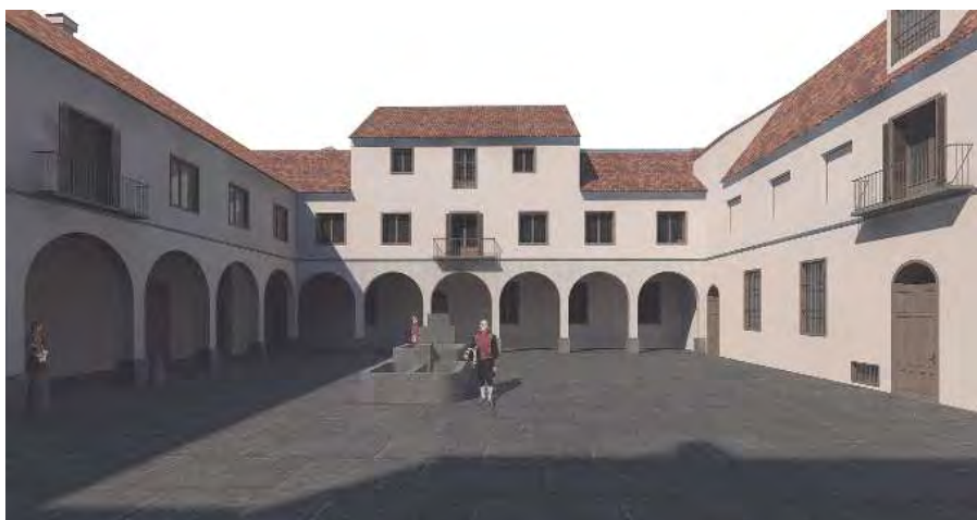
Vista del patio principal de la Escuela de Veterinaria, desde el acceso del ala sur (residencia de estudiantes internos) hacia la galería porticada norte.
