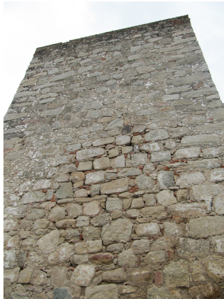
Torre de la muralla en el interior del Palacio
