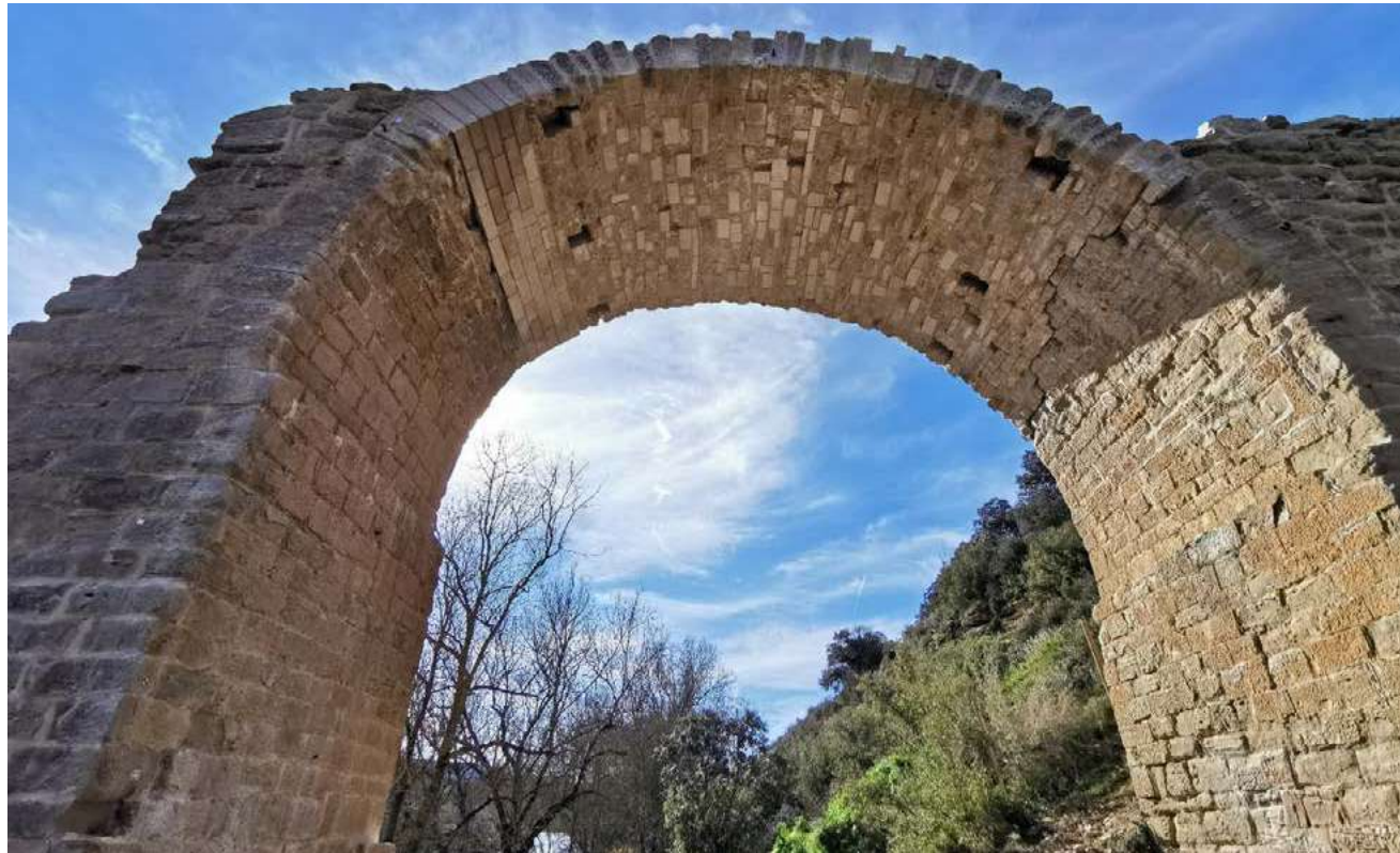
Fig. 7: Estado restaurado con vista de intradós del arco desde aguas arriba
