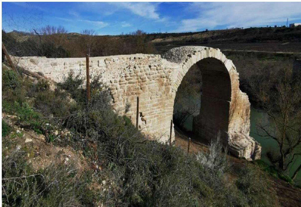
Fig. 4: Estado restaurado de vista desde aguas abajo desde margen derecha
