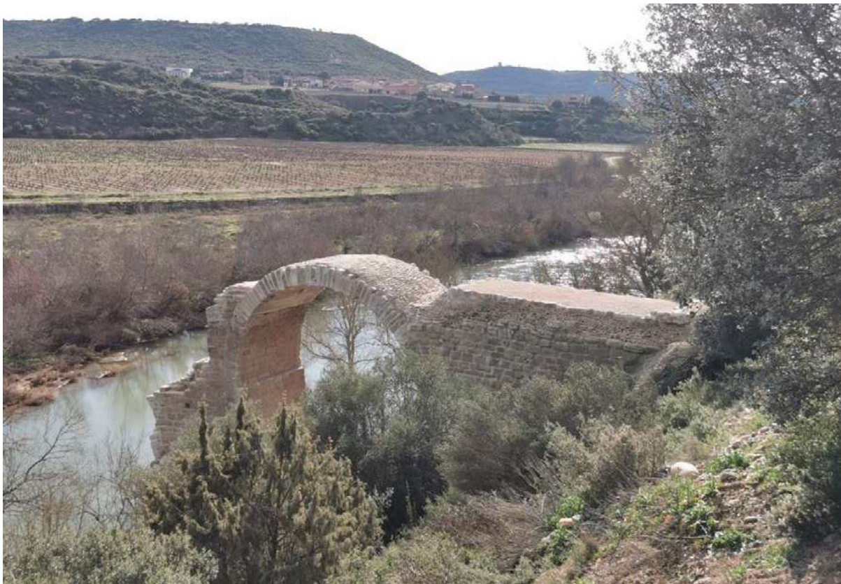
Fig. 3: Estado restaurado de vista desde aguas arriba desde margen derecha
