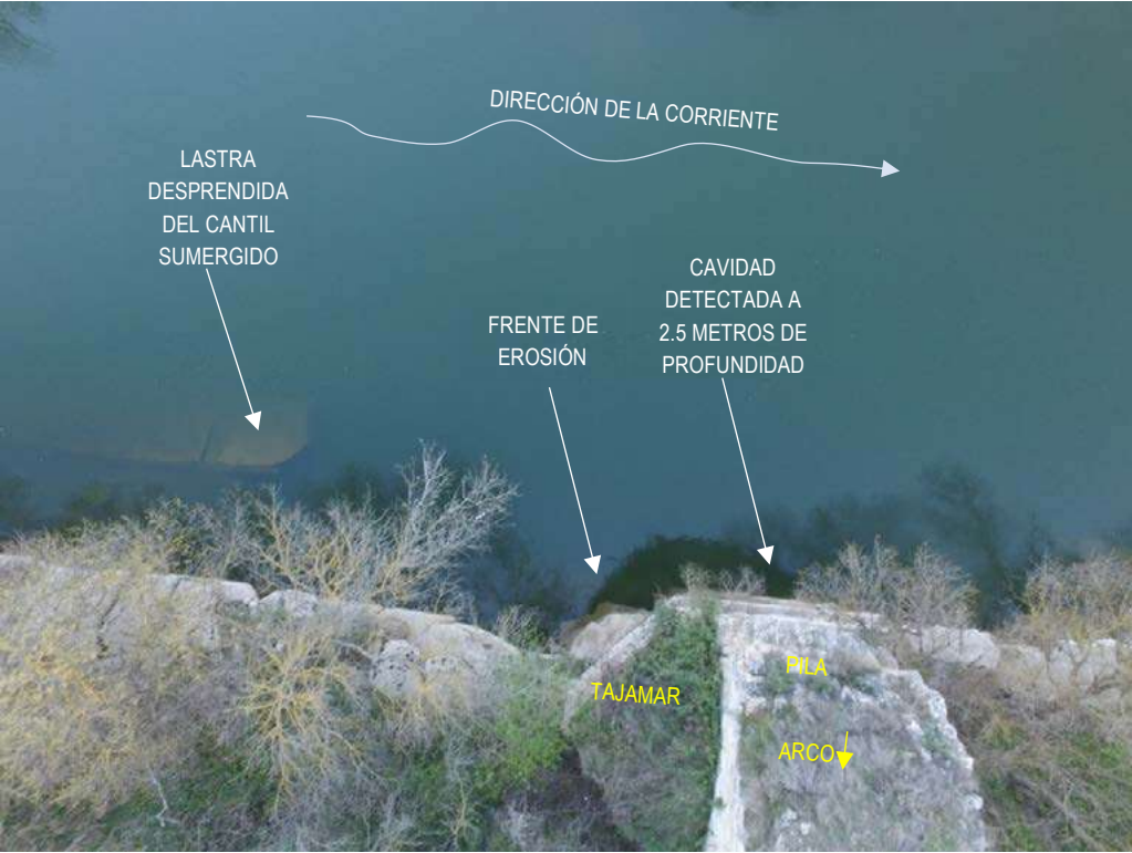
Fig. 29: Vista cenital del r o. Abajo el arco sobre el que se ha intervenido
