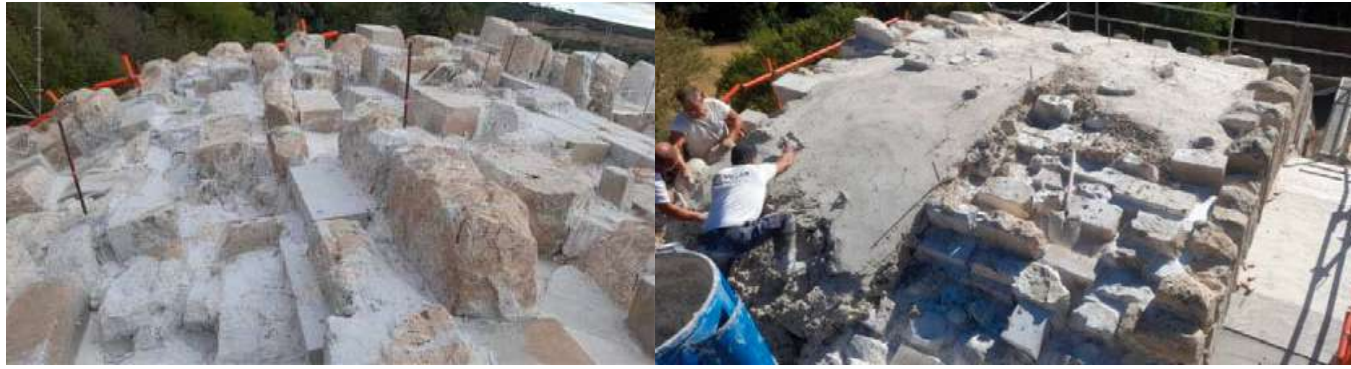
Fig. 65 y 66: A la izquierda, relleno con mortero fluido, y a la derecha, aplicación de hormigón de cal.
