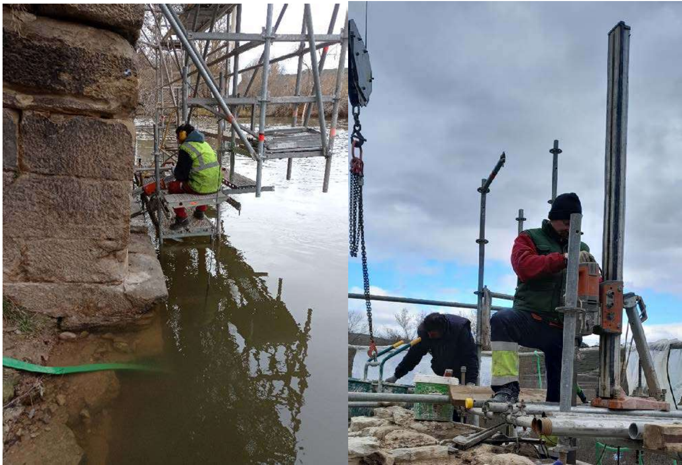
Fig. 46 y 47: A la izquierda se aprecia a un operario realizando las perforaciones desde el frontal de la pila desde el andamio descolgado sobre el Ebro. En la imagen derecha se aprecia a dos operarios, El más cercano realiza una de las perforaciones desde la coronación del cuerpo superior de la pila, el operario más alejado se encuentra vertiendo la lechada de cal de forma manual, una vez colocada la barra de acero inoxidable con ayuda de la grúa torre.
