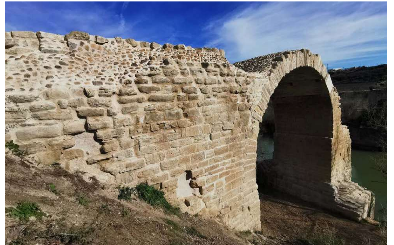
Fig. 5: Estado restaurado de vista desde de aguas abajo
