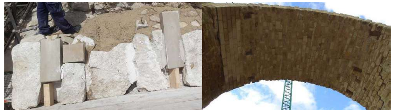
Fig. 61 y 62: A la izquierda, proceso de formación de cajeados, y a la derecha, las huellas de los mismos
