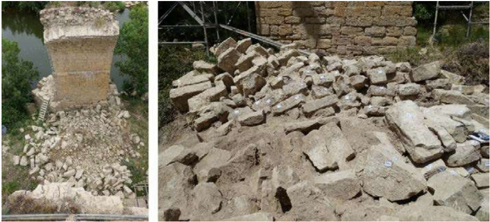
Fig. 20: Arco arruinado orilla derecha del puente de Mantible
