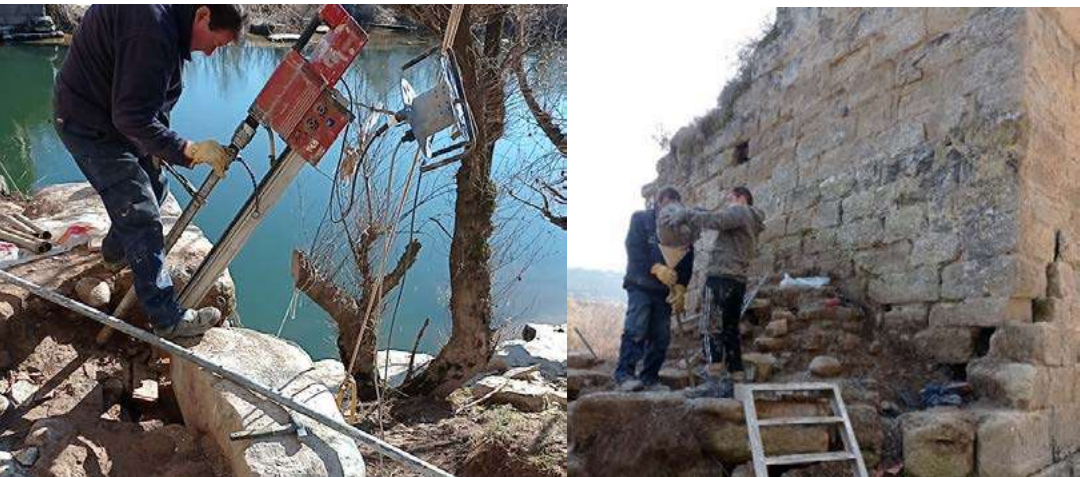
Fig. 44 y 45: Perforación en el espolón a la izquierda, y relleno por colada de la perforación a la derecha en el tajamar
