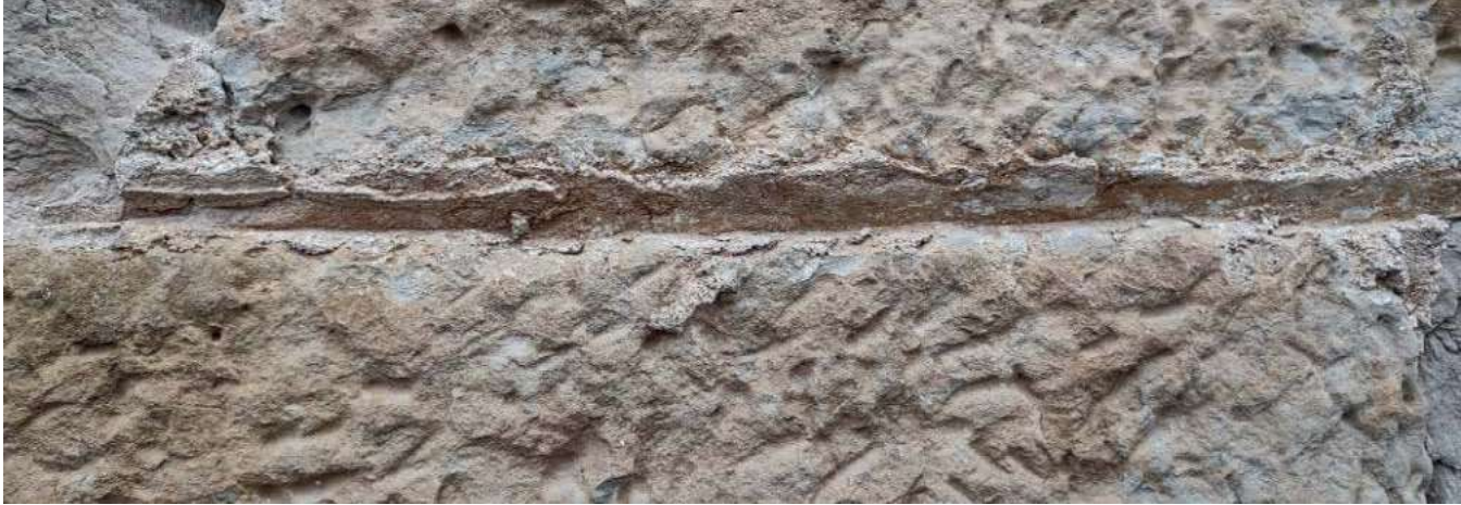
Fig. 36: Junta original ejecutada con un pase de la punta de la paleta
