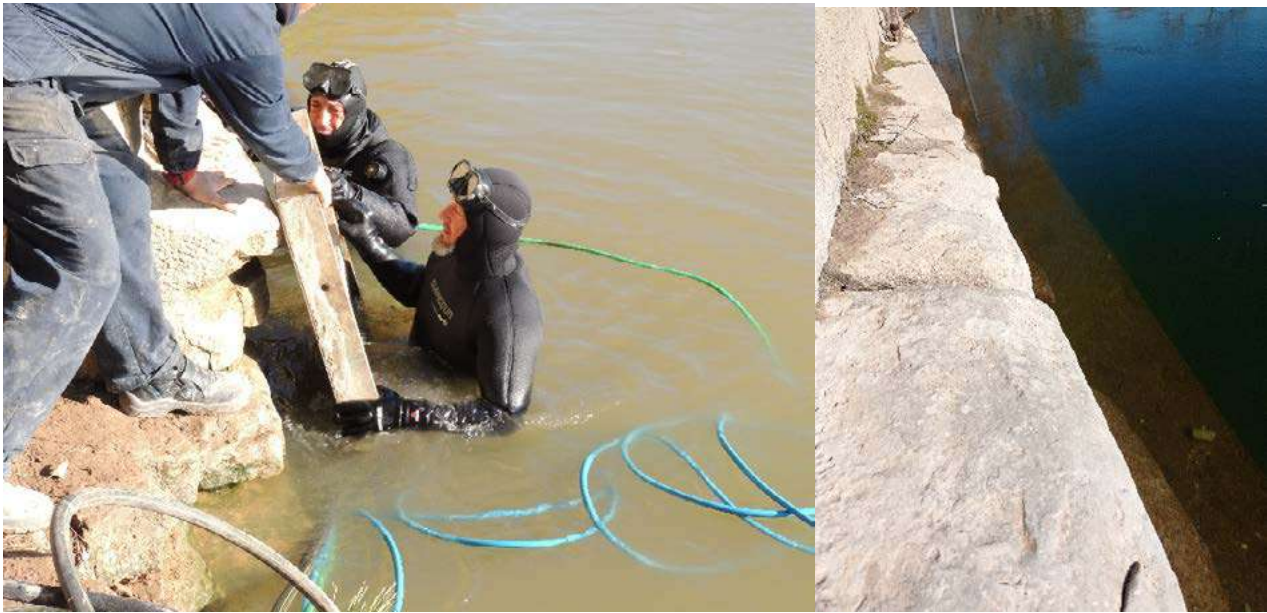
Fig. 40 y 41: A la izquierda, labores subacuáticas en la cimentación de la pila de encofrado, y a la derecha el recalce.
