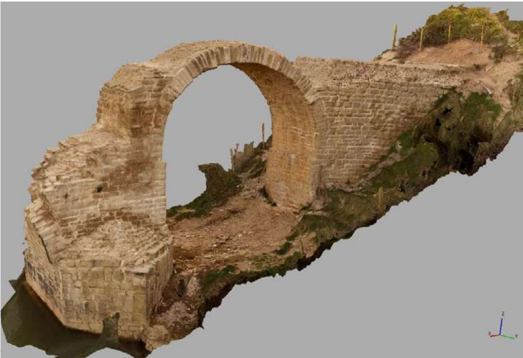
Fig.75: Imagen del levantamiento fotogramétrico del puente restaurado, fachada de aguas arriba.
