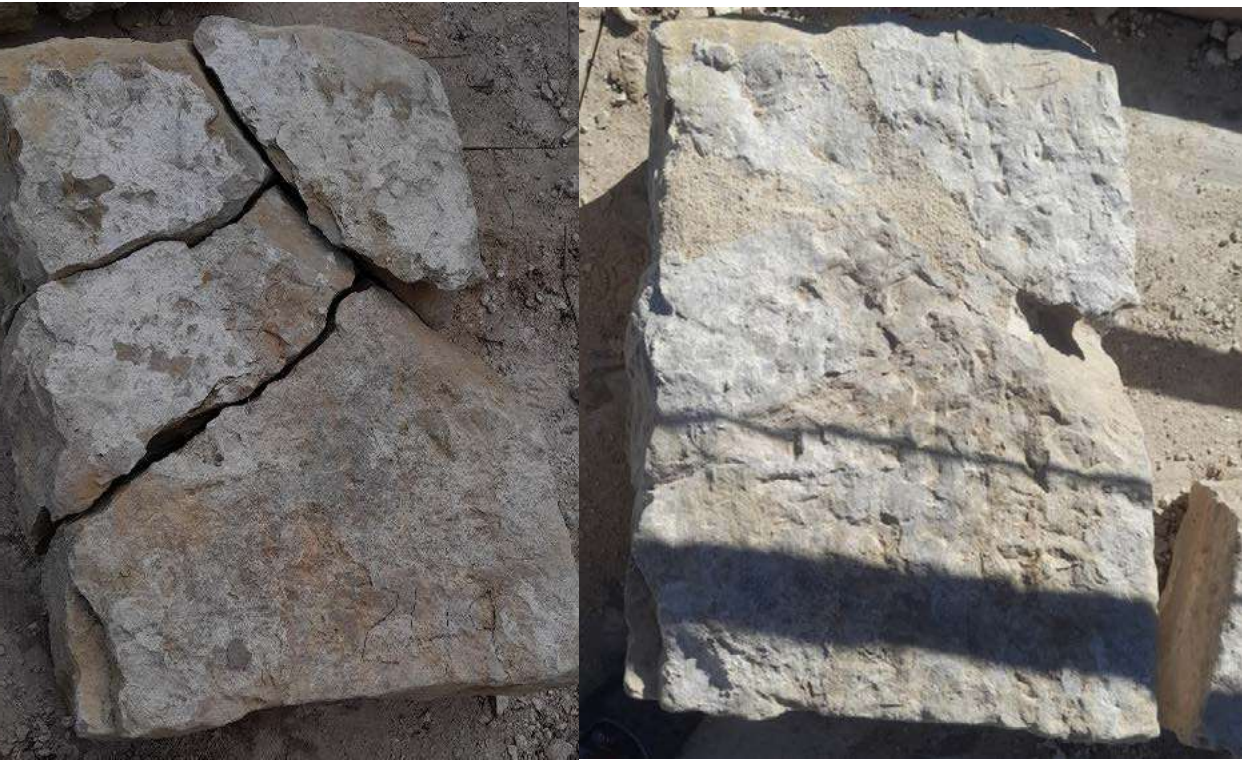
Fig. 52 y 53: A la izquierda, se aprecia la pieza 249 en estado previo, y a la derecha, una vez restaurada, previo a la reintegración con mortero y el injerto en la parte del trasdós.
