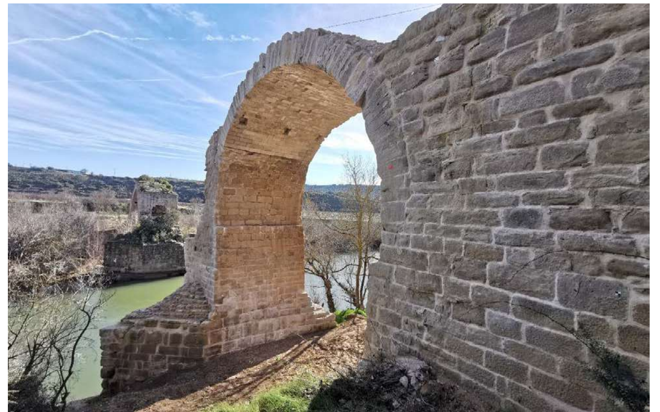
Fig. 6: Estado restaurado de vista desde de aguas arriba
