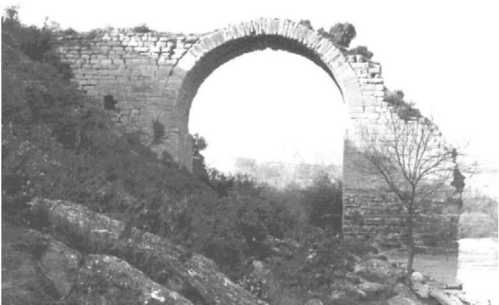
Fig. 12: Vista aguas abajo del arco de la orilla derecha del puente Mantible (Año 1970; Archivo Histórico Provincial de la Rioja, Fondo Patrimonio Histórico)
