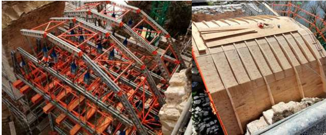
Fig. 57 y 58: A la izquierda, el montaje de la cimbra y a la derecha, la formación de la directriz con camones .
