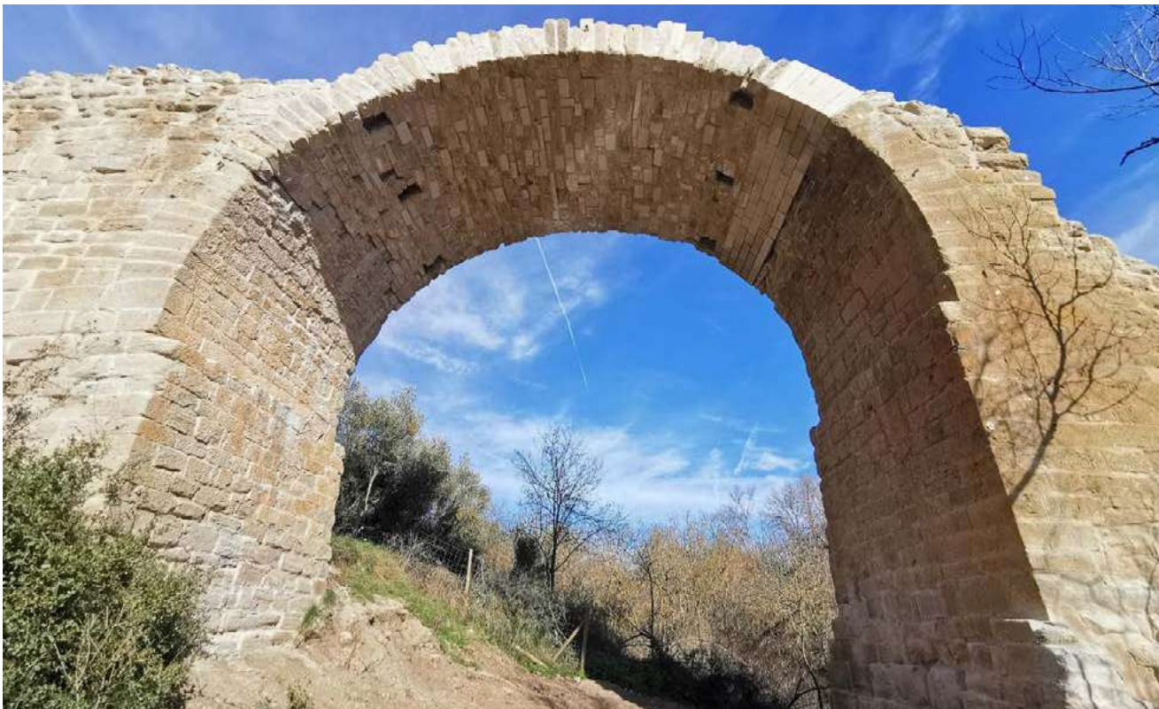
Fig. 8: Estado restaurado con vista de intradós del arco desde aguas abajo
