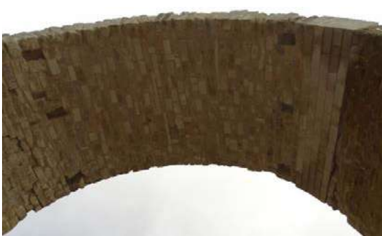
Fig. 56: Intradós final del arco reconstruido.
