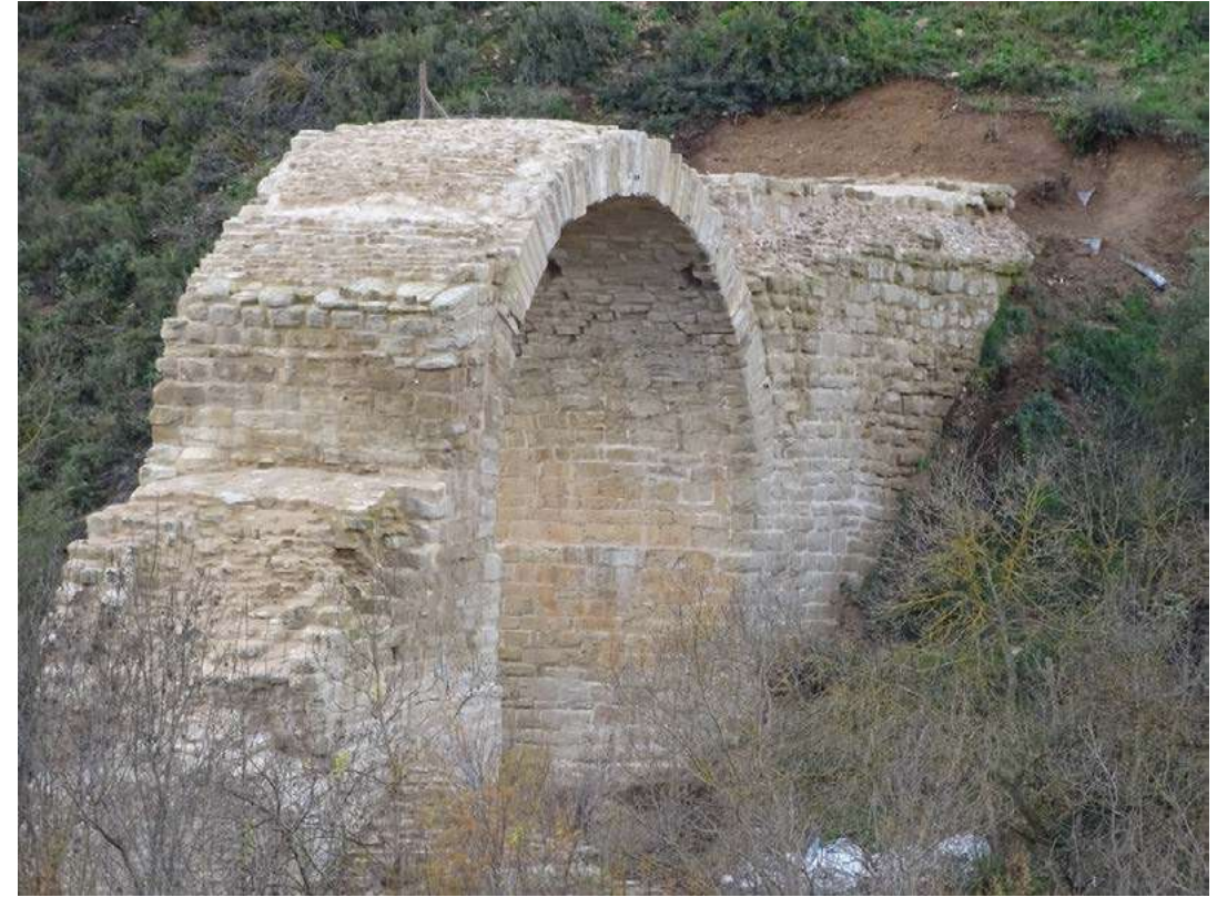
Fig. 1: Estado restaurado de vista desde aguas arriba desde margen izquierda
