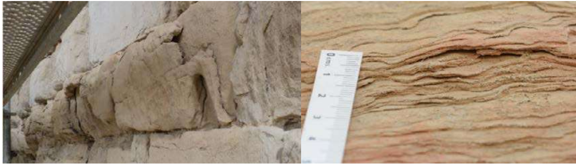
Fig. 34 y 35: En la izquierda alteraciones en hilada de disyunción y en la derecha distintos procesos de la exfoliación
