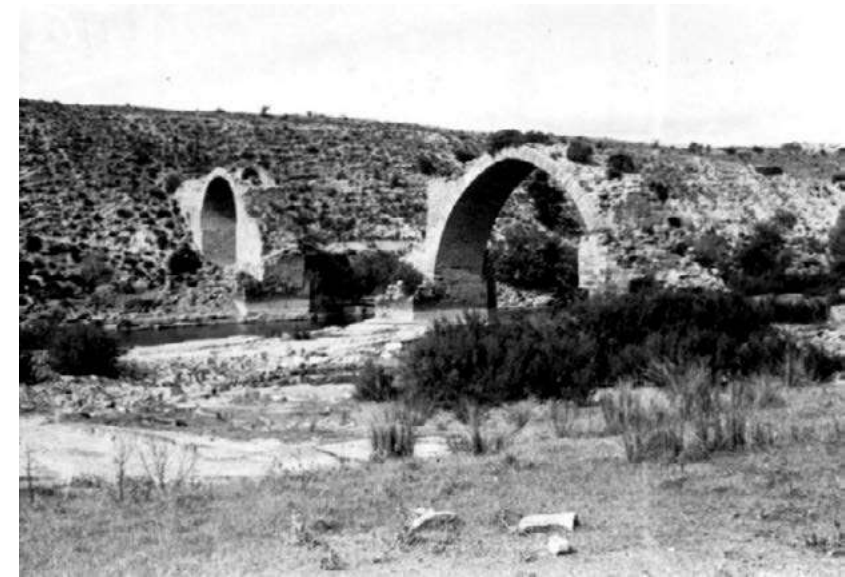
Fig. 9: Vista del puente Mantible desde la orilla izquierda aguas abajo (Años 1959–1965; Archivo de Álava, ES.01059.ATHA.ENC.CD.32372–32374)
