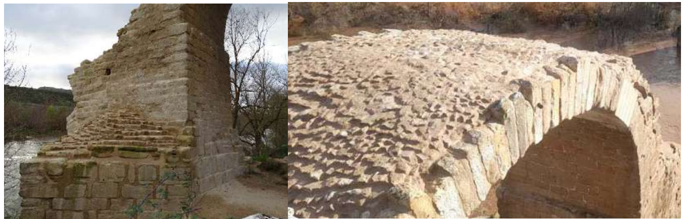
Fig. 70 y 71: A la izquierda la coronación del tajamar aguas arriba y a la derecha la coronación del tablero del arco
