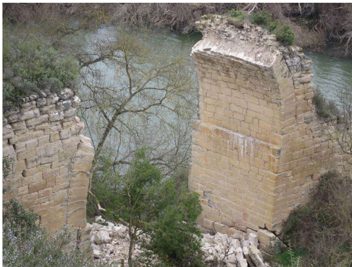
Fig. 31: Estado previo Alzado aguas abajo desde el camino de acceso en la margen derecha del Ebro
