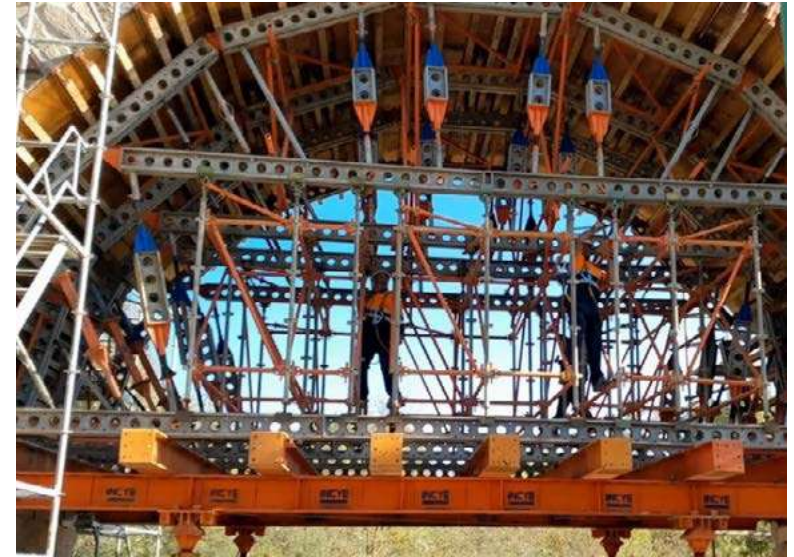
Fig.69: Imagen del desapeo durante la manipulación de los husillos de los pies derechos.
