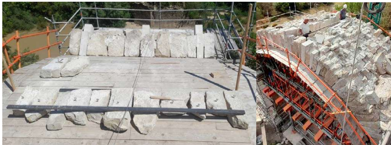
Fig. 59 y 60: A la izquierda, una fase del montaje para su ajuste y la derecha, el montaje definitivo
