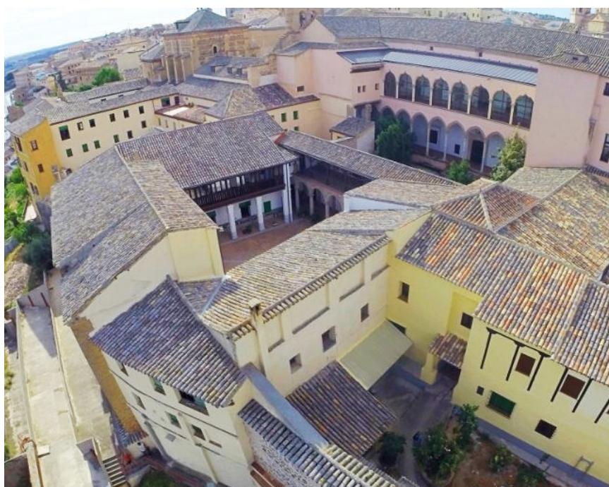
Vista aérea del convento de Santo Domingo el Real con el claustro del Rosal en primer término y al fondo el del Moral, con la galería o cobertizo interior de comunicación entre ambos claustros, obra de Juan Bautista Monegro.
