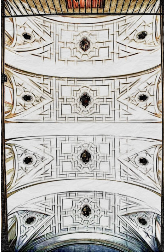
(12) Bóvedas del convento de la Inmaculada Concepción o Gaitanas (1627)
