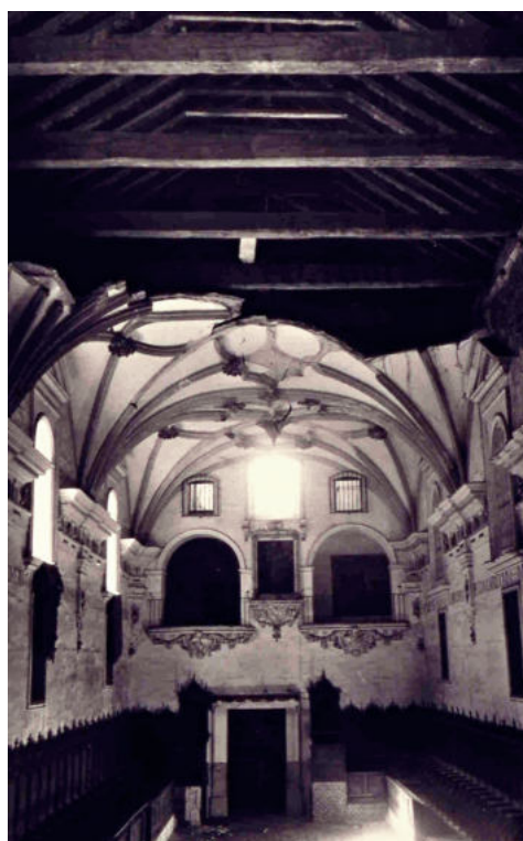
Bóvedas del coro del convento de San Clemente, estado después del bombardeo de 1937 y reconstrucción, Archivo General del Estado, Regiones Devastadas
