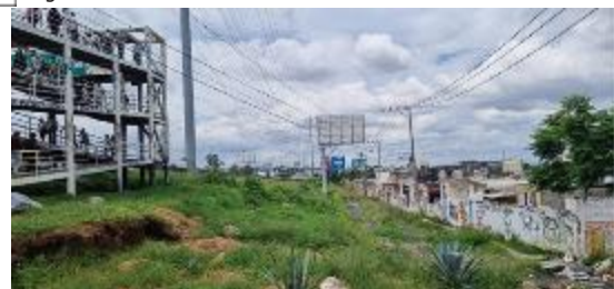
b Figura 3.4. Baldío colindante a la carretera
