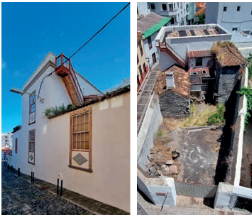
Fachada lateral hacia la calle Baltasar Martín y vista aérea de la parte trasera de la vivienda correspondiente al huerto o sitio
