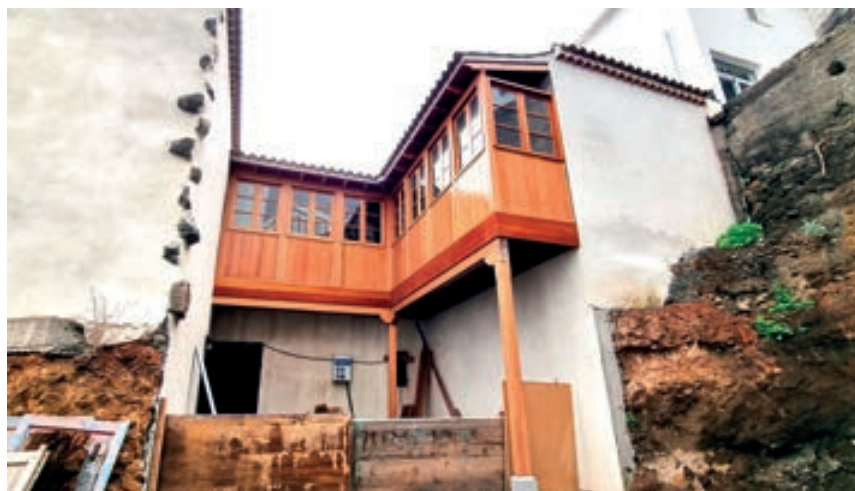
Balcón cubierto o galería en la fachada trasera de este inmueble
