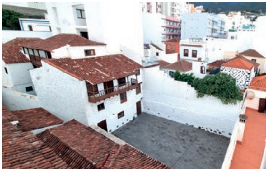
Fachada trasera con balcón y patio del inmueble, sede de la Cruz Roja
