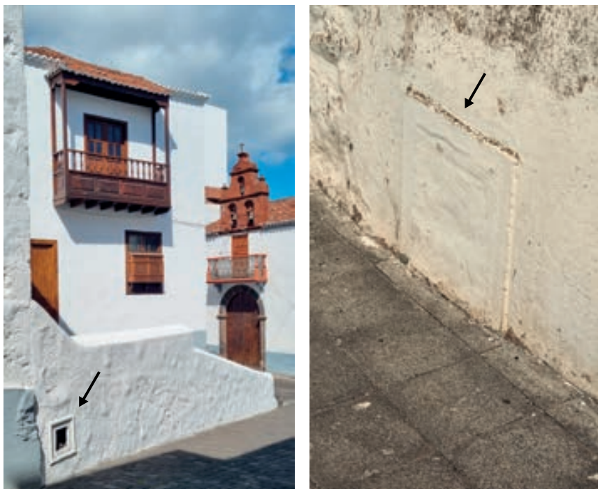
Izquierda, restos de la antigua cajita de reparto de agua entre las calles Sierra y San José. Derecha, otra cajita de reparto de agua, tapiada, para las casas en la calle San José, número 12 (hoy 24). De esta última se repartía el agua a la vivienda de Baltasar Martín, número 5
