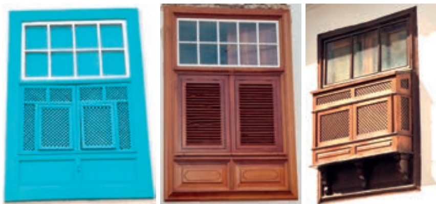
Ventanas de carpintería tradicional. Izquierda, de celosía con antepechos de cojinetes, hojas de celosía con postigos abatibles y tercio superior acristalado. Centro, postigos de lamas con cojinetes decorados. Derecha, ventana ajimez de celosía sobre canes y tercio superior acristalado. Calles Santa Águeda y San José
