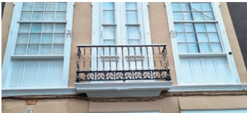
El balcón de madera es sustituido por el de fundición, al que se abre la puerta-ventana. A los lados, ventanas de guillotina acristaladas de desplazamiento vertical con antepechos de tableros lisos, 1905. Calle San José
