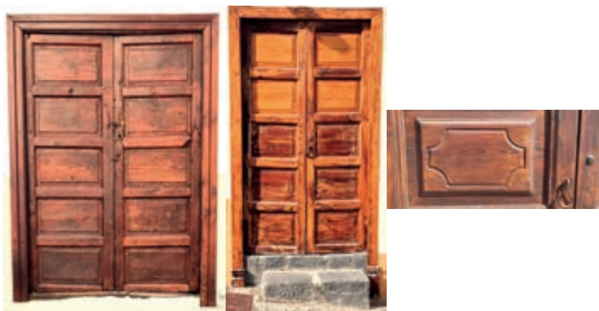
Puertas de doble hoja realizadas en carpintería tradicional con peinazos y cojinetes lisos y distribuidos de manera homogénea, una con sardinel de madera de tea (izquierda) y la central con sardinel de piedra. Derecha, cojinete o cuarterón con decoración geométrica habitual, abocelado en su encuentro con los peinazos (detalle). Calles Cruz Roja y Santa Águeda
