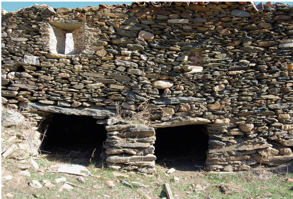
Aldeacentenera. Infraestructura de molino. IAVE
