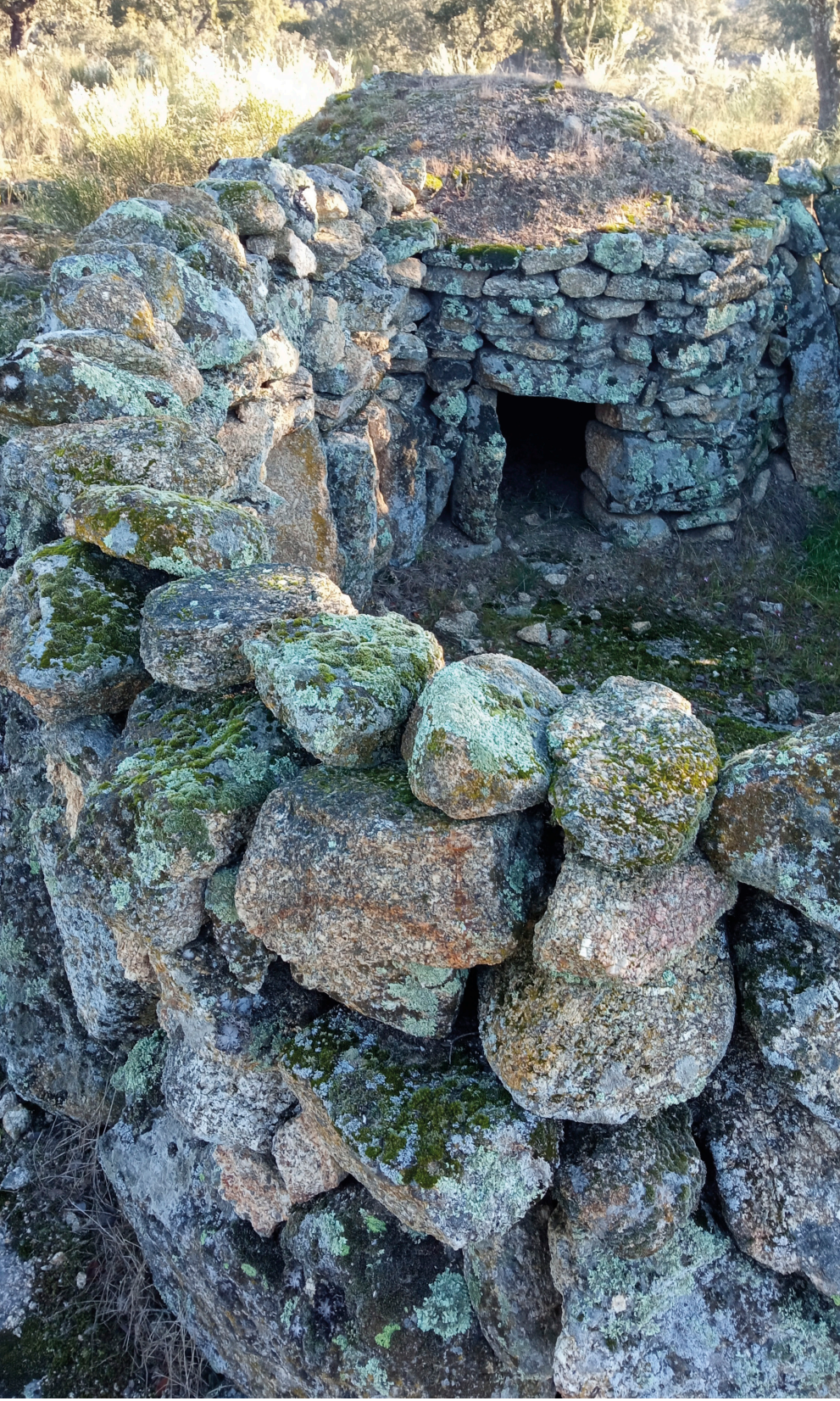
Torrequemada, corralá para cerdos. La similitud de las estructuras constructivas de chozos y zahúrdas es, en ocasiones, notable. DGBAPC
